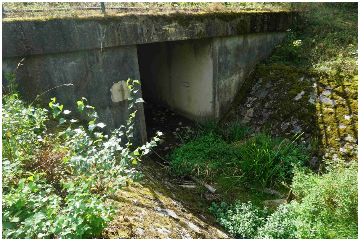
11. Výustní čelo šachty sdruženého objektu
