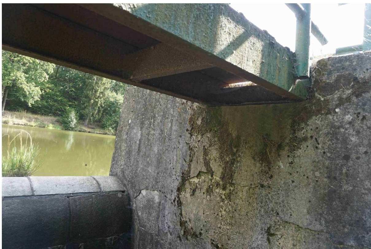
6. Nosná konstrukce lávky
