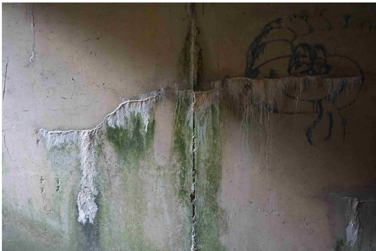
15. Šachta sdruženého objektu - pracovní spára
