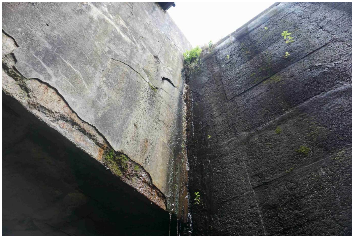
17. Dilatační spára mezi přelivnou hranou a šachtou sdruženého objektu
