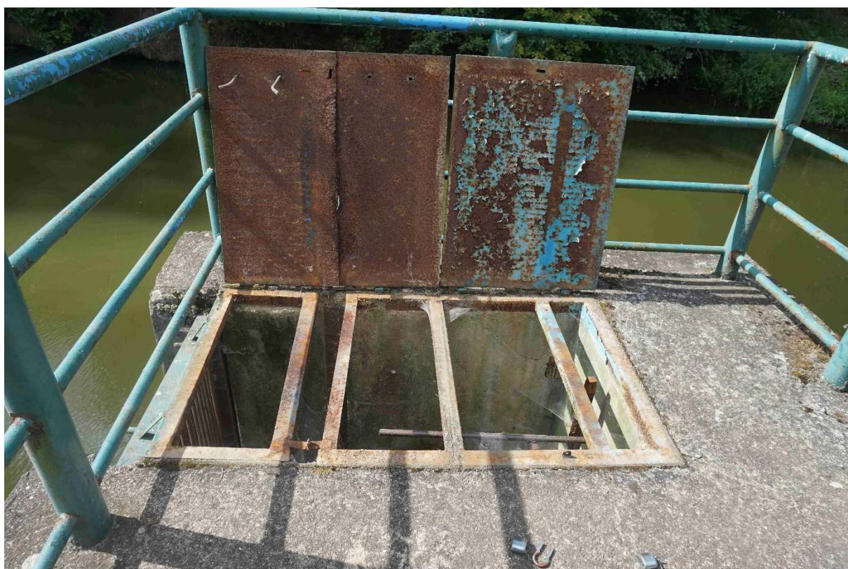
8. Poklop a rámeček poklopu spodní výpusti
