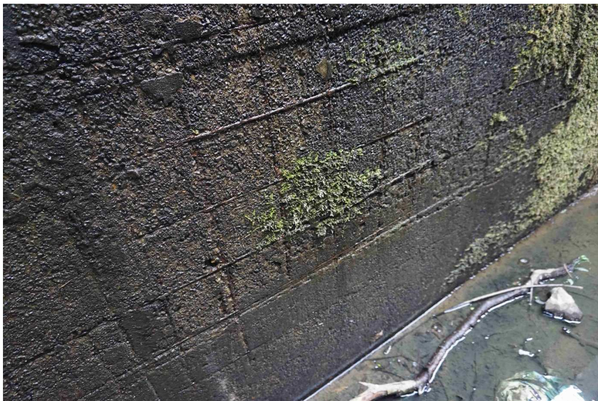
18. Stěna spadiště - vystupující výztuž
