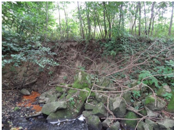
km cca 17,45 - proti proudu - opevnění břehové nátržky lom. kamenem (bez vazby) v blízkosti silnice
