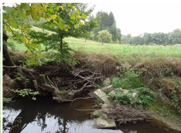
km cca 17,39 - po proudu - opevnění podezmlétoho prav. břehu stavebním odpadem, v pozadí svah s ovocnými stromy
