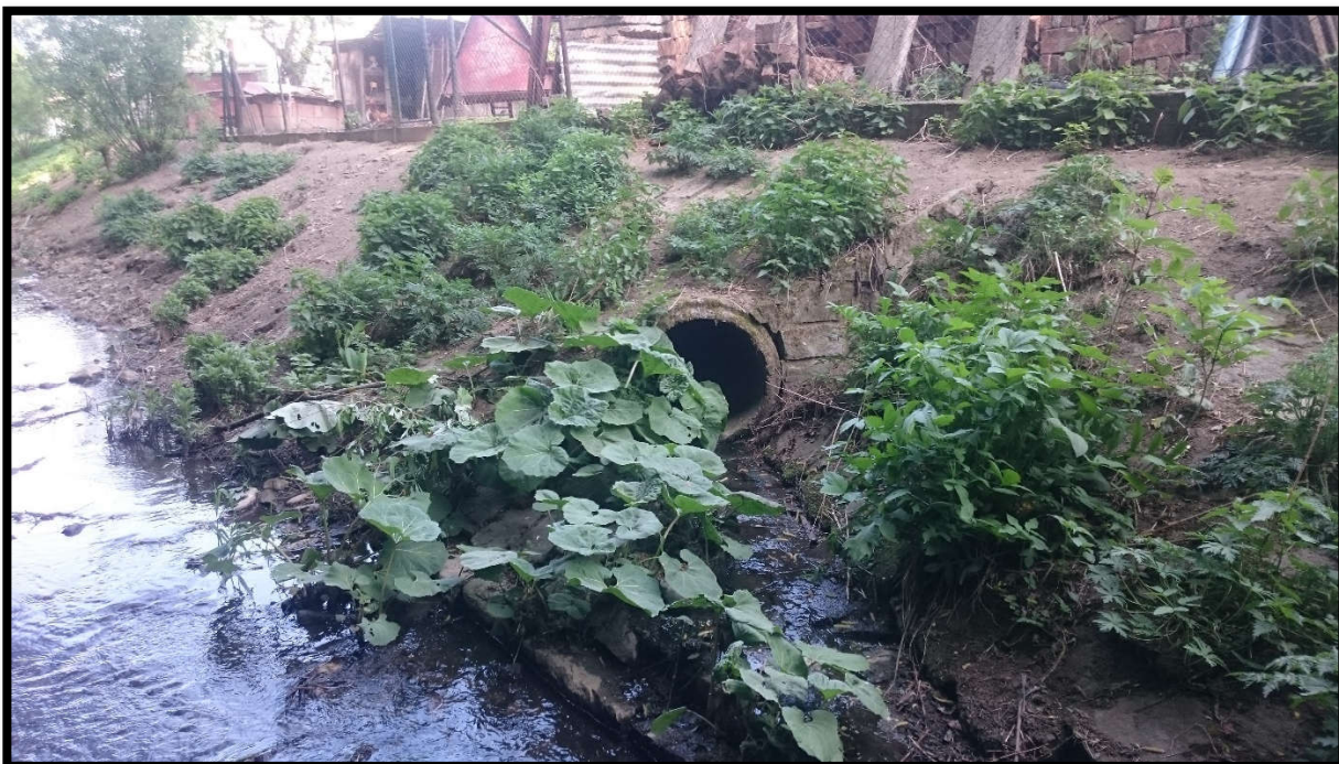
Úsek č. 1 a 2, km 33,303 dělení úseků 1/2 – vyústění kanalizace
