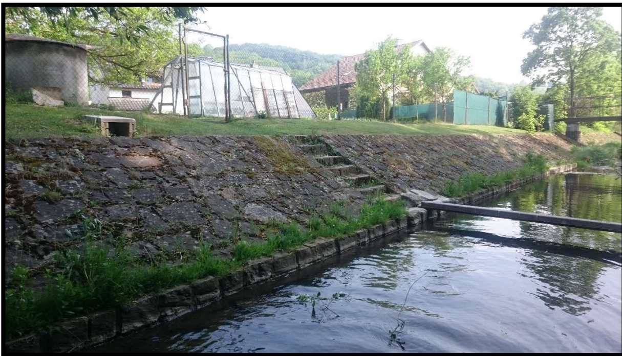
Úsek č. 2, LB – stávající kamenná dlažba
