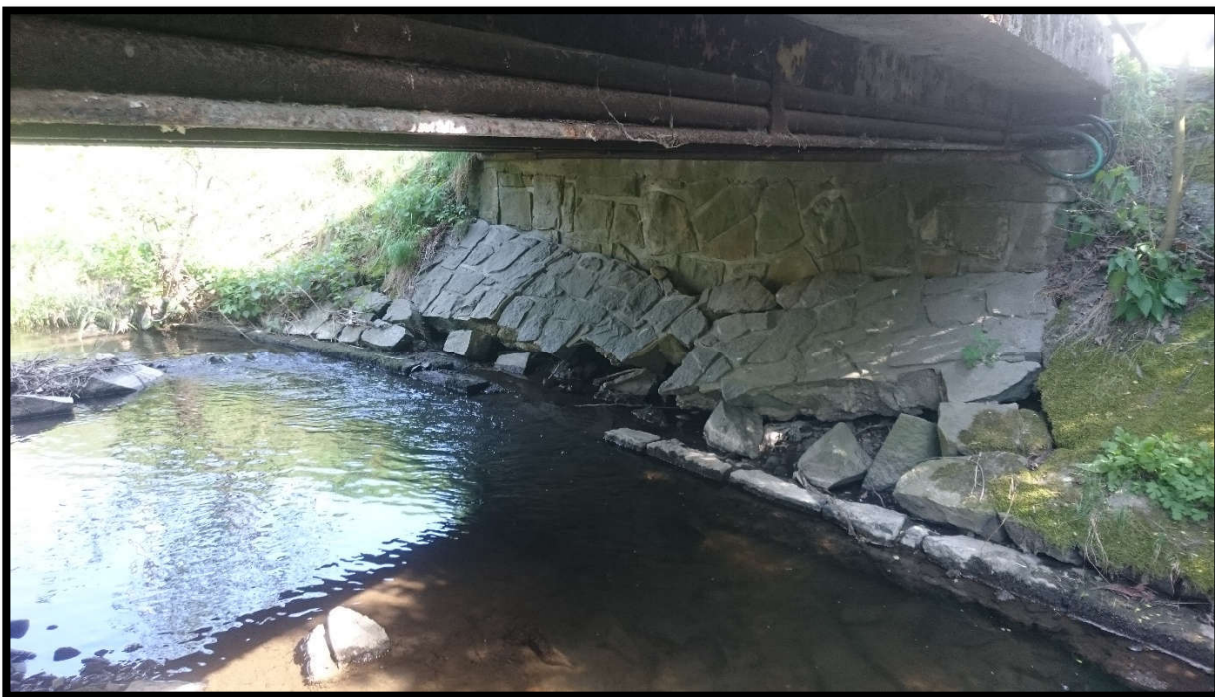
Úsek č. 3, km 33,795 – porušené opevnění pod mostem
