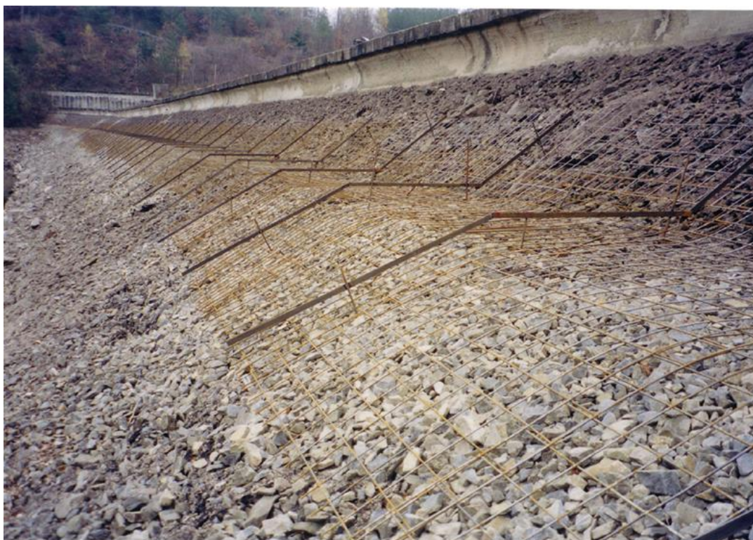
Obr. 9 Umístění KARI sítě v sanované části návodního líce [zdroj: Povodí Moravy, s.p.]
