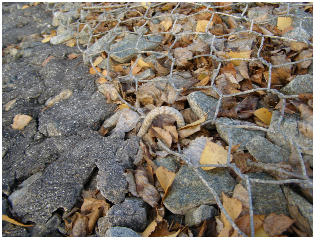
Obr. 4 Část návodního líce sanovaná překrytím drátěnou sítí – detail ukotvení sítě
