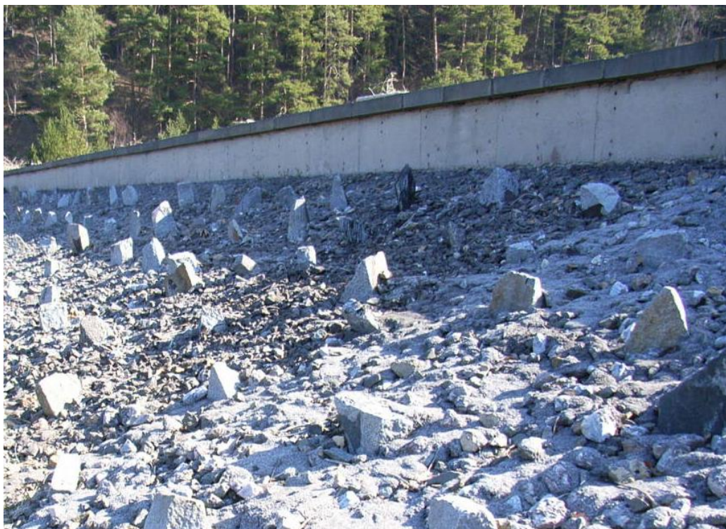
Obr. 1 Opevnění návodního líce VD Letovice se solitérními kameny pro zdrsnění
