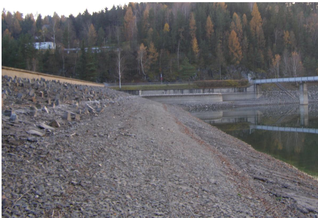
Obr. 3 Část návodního líce sanovaná překrytím drátěnou sítí
