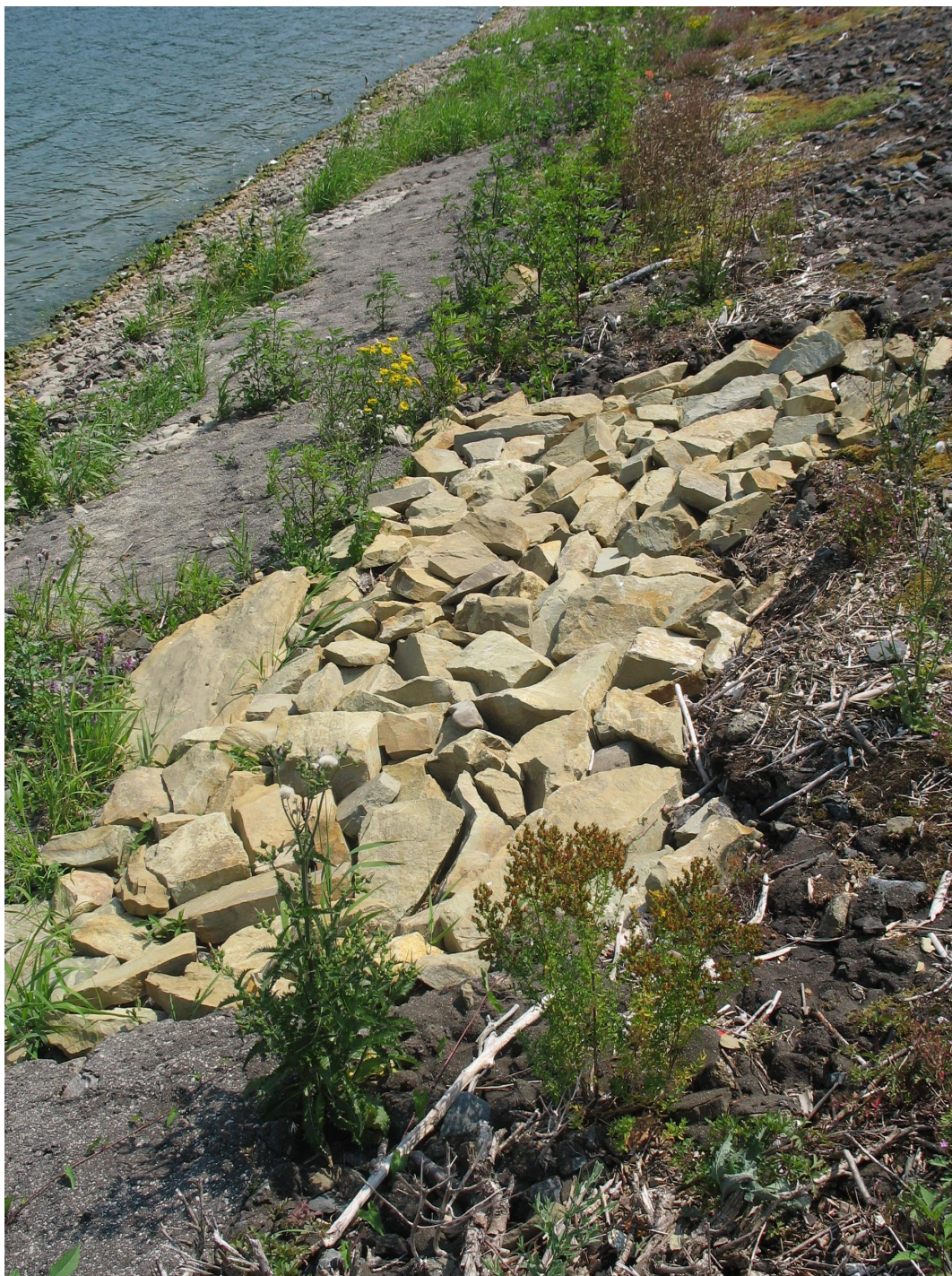
Obr. 15 VD Slušovice – místo poruchy sanované lomovým kamenem
