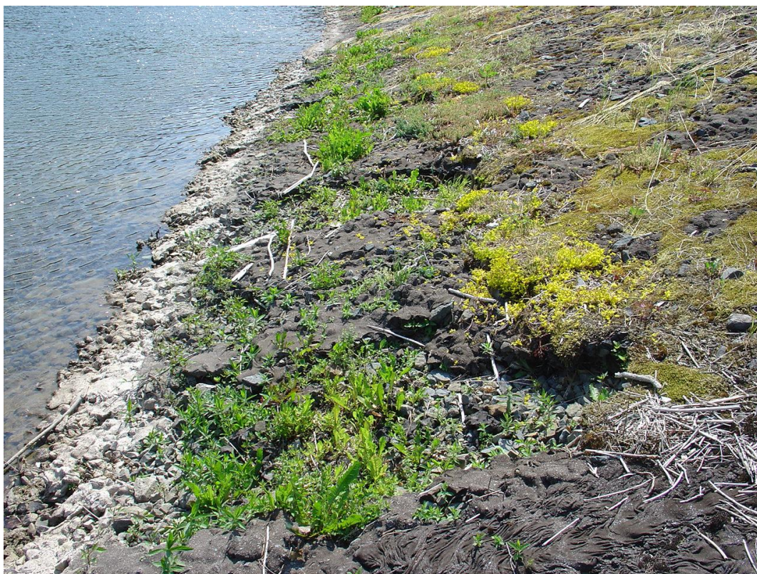
Obr. 14 VD Slušovice – detail návodního líce, vegetace v porušeném místě
