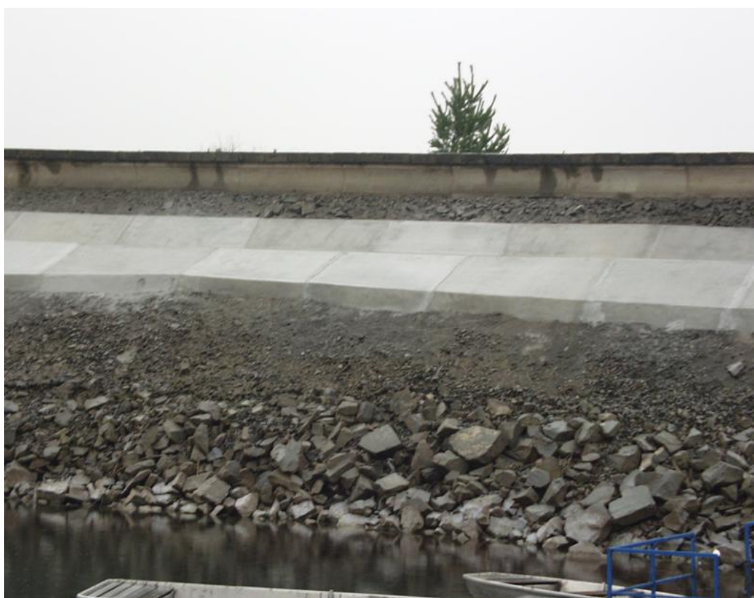
Obr. 11 Pohled na hotovou sanaci návodního líce [zdroj: Povodí Moravy, s.p.]
