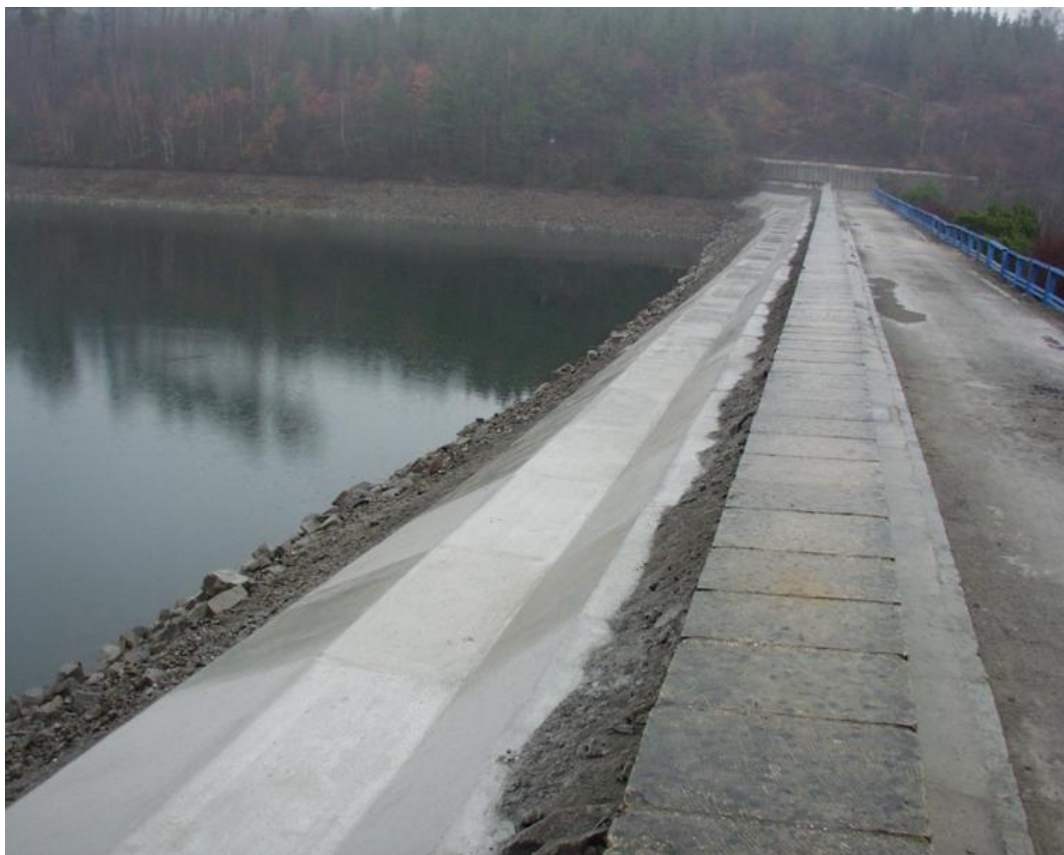
Obr. 12 Celkový pohled na hotovou sanaci návodního líce [zdroj: Povodí Moravy, s.p.]
