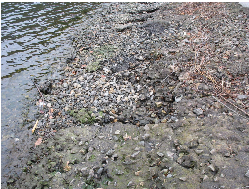
Obr. 2 Porucha opevnění návodního líce způsobená vlnobitím
