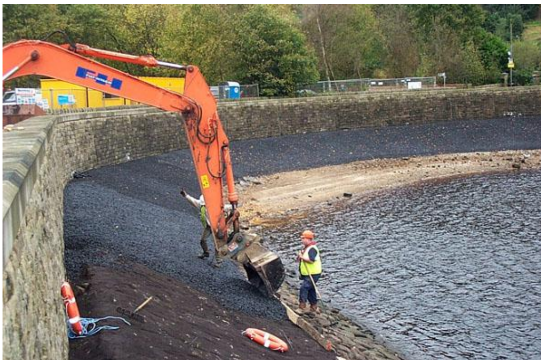
Obr. 8 Rekonstrukce návodního líce vodárenské nádrže Rivelin Dam ve Velké Británii [zdroj: Hesselberg Hydro, Ltd.]
