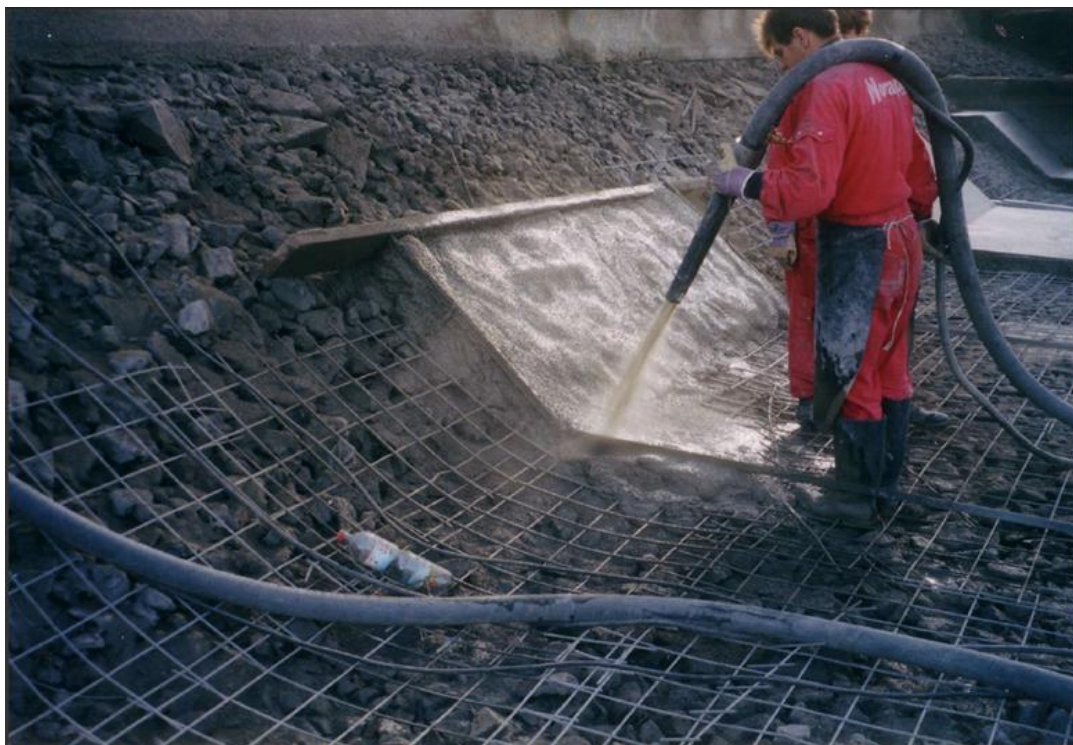
Obr. 10 Betonáž sanované části návodního líce [zdroj: Povodí Moravy, s.p.]
