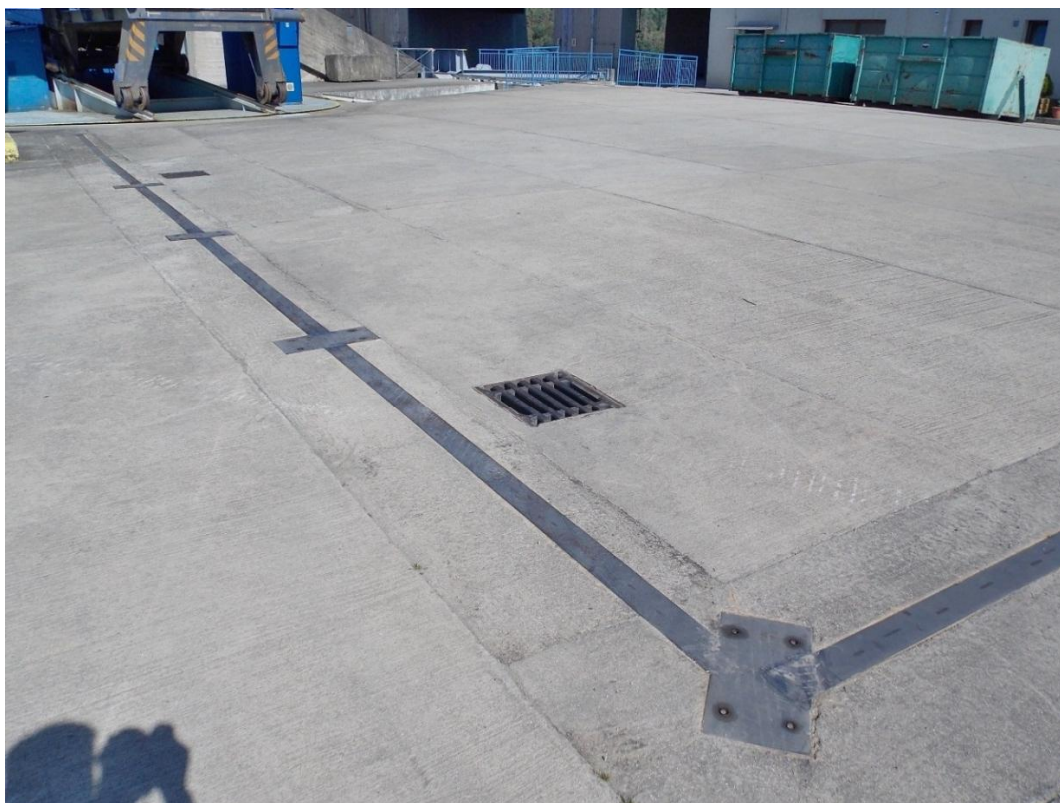
Obr. 1 – Pohled na stávající kotvení mobilního hrazení
