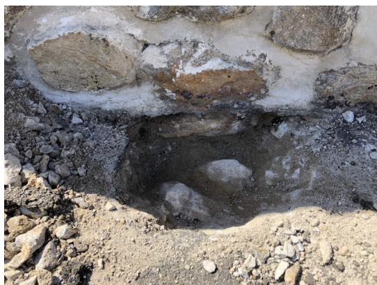
Obrázek 17 – Pohled na řimsu v sondě č. 4
