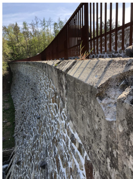
Obrázek 3 – Pohled na vzdušnou část hráze a římsu koruny hráze
