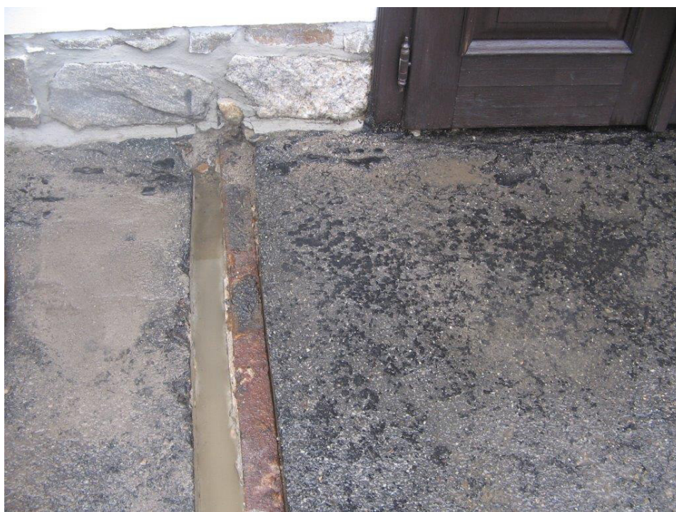
Obrázek 24 - Umístění jednoho ze čtyř válcovaných I profilů u strojovny s drážkou pro kabel TBD (u zídky - v pohledu dveře strojovny)
