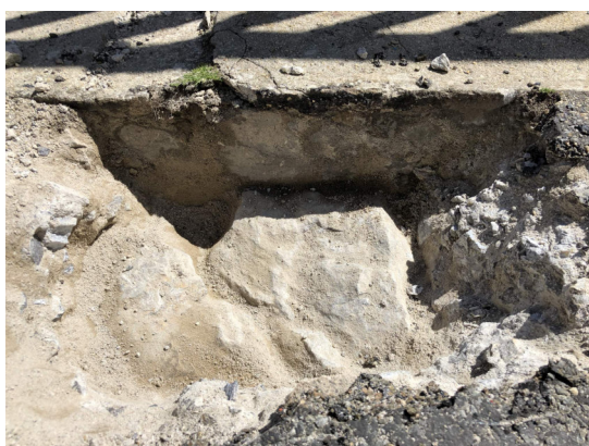
Obrázek 11 – Pohled na římso v sondě č. 1
