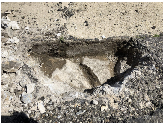
Obrázek 16 – Pohled na řimsu v sondě č. 3
