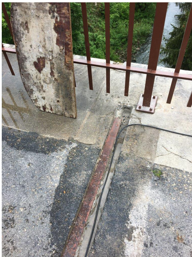
Obrázek 23 - Umístění jednoho ze čtyř válcovaných I profilů u strojovny s kabelem pro TBD (u bet. římsy)
