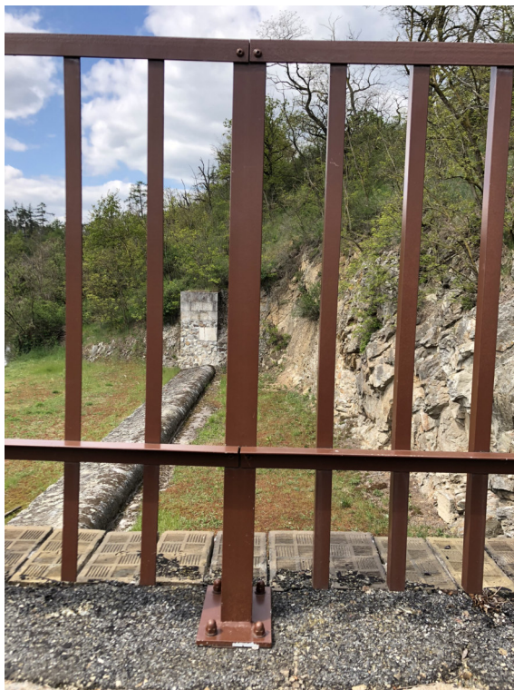
Obrázek 21 - Detailní pohled na stojnu ocelového zábradlí
