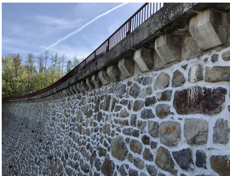
Obrázek 5 – Pohled na podpěry římsy
