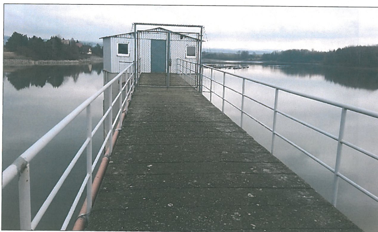
Pohled na pochůznou konstrukci lávky
