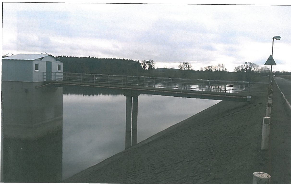
Pohled na obslužnou lávku z koruny hráze
