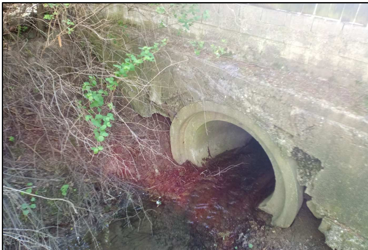
začátek zatrubnění km 0,173, pohled po toku na část potrubí DN 800 – (SO02)
