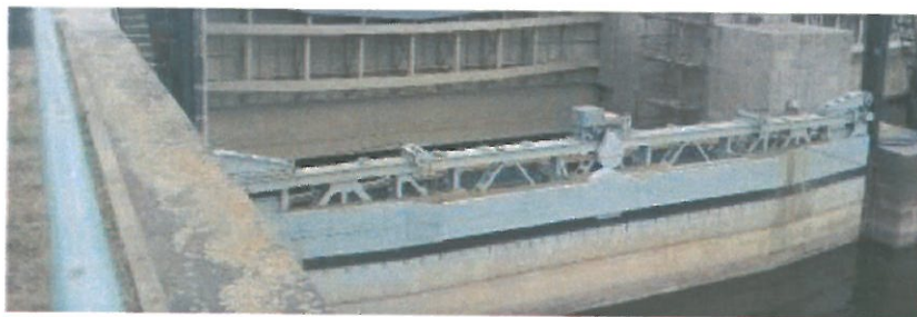
Provizorní hrazení z DV včetně motorového hradidla
