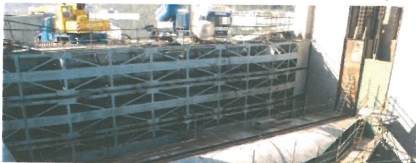
Provizorní hrazení z HV
