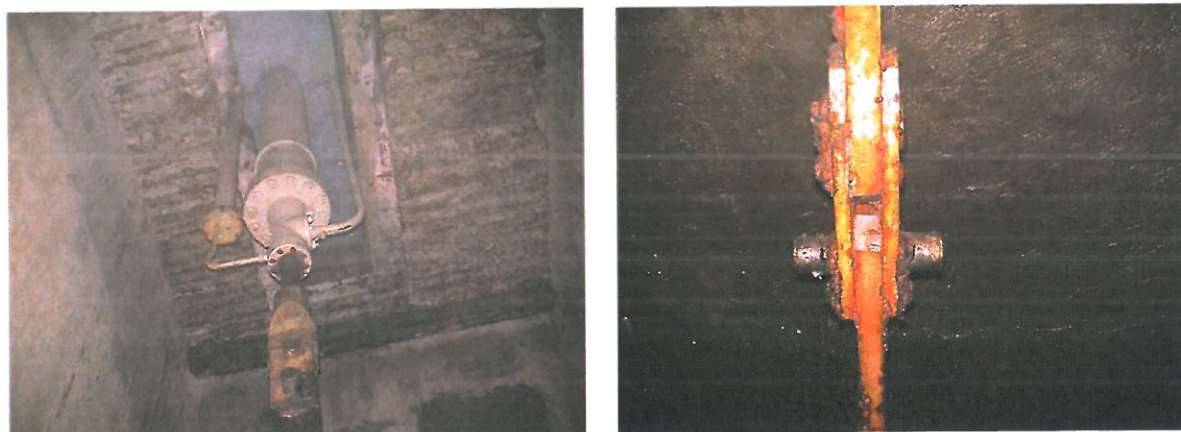
Obrázek 5 Hydraulický mechanismus a táhla pro ovládání provozního tabulového uzávěru
