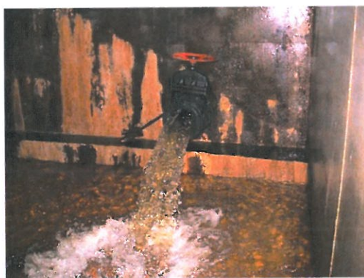
Obrázek 6 Šoupátko DN 200 pro vypouštění šachty tabulového uzávěru
