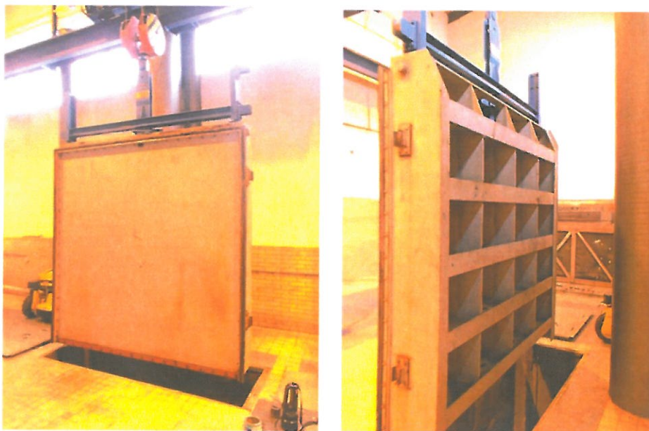
Obrázek 3 Revizní tabulový uzávěr
