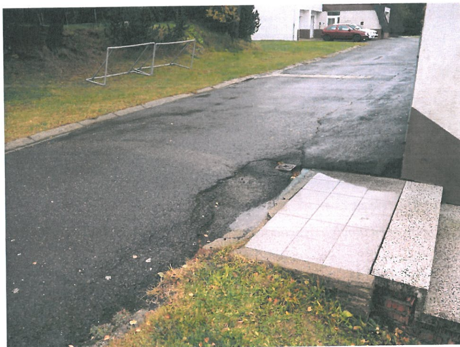
Propadlá vozovka a absence odvodnění zpevněné plochy před schodištěm
