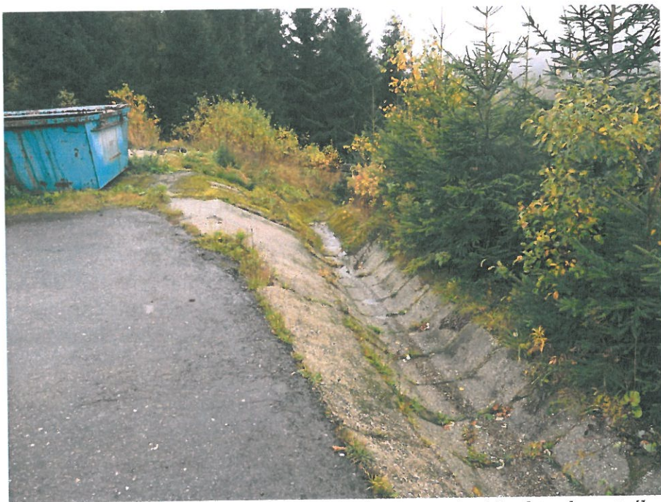
Odvodňovací žlab z parkoviště svedený přes revizní šachtu do patního drénu hlavní hráze - betonové žlabovky jsou na mnoha místech poškozené a revizní šachta má degradovaný beton a nevyhovující česle
