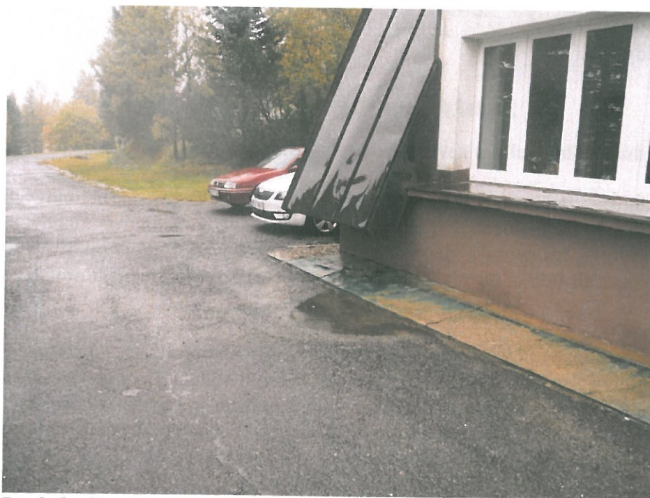
Před objektem st.p.č. 359 došlo k sedání vozovky a okapového chodníčku a vlivem toho dochází k zamokření oblasti základových pasů a dále vztlínání vlhkosti do zděných konstrukcí a fasády i mimo zimní období
