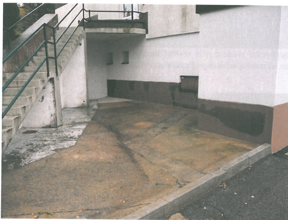
Špatné spádové poměry zpevněných ploch a degradovaný beton zpevněných ploch
