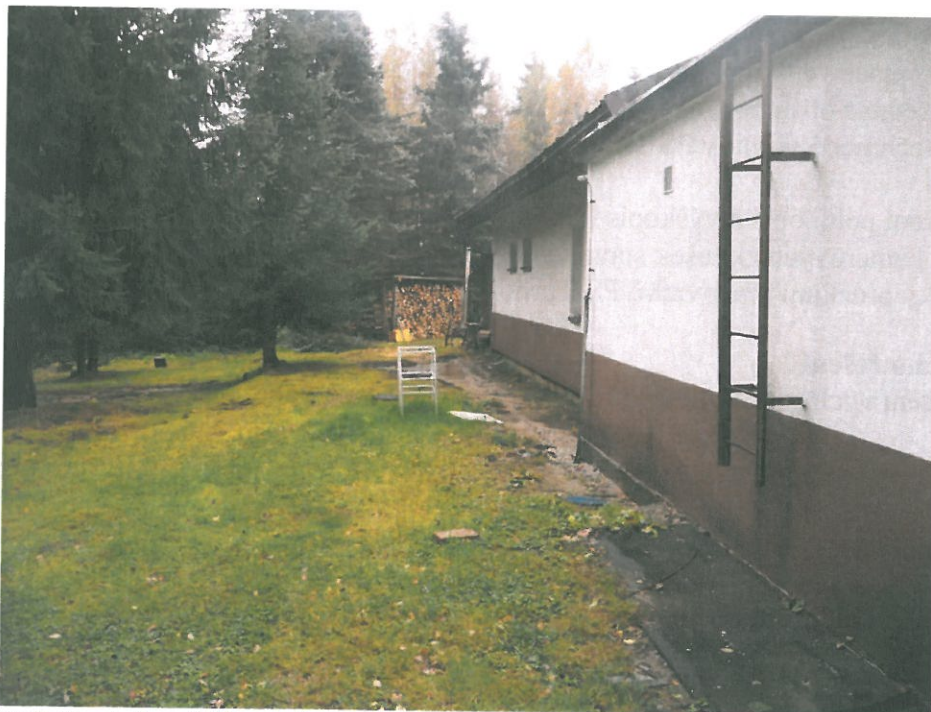
Objekt st.č.p. 359 - silné zamokření v oblasti základových pasů, střešní žlab není možné nainstalovat z důvodu velkého zatížení sněhem+ledem
