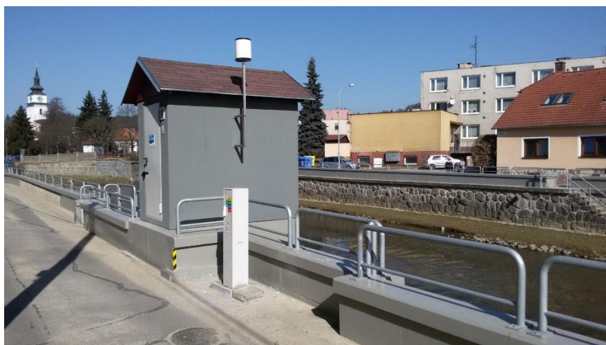
Obr.3 Příklad prefabrikovaného objektu limnigrafu – Velké Meziříčí
