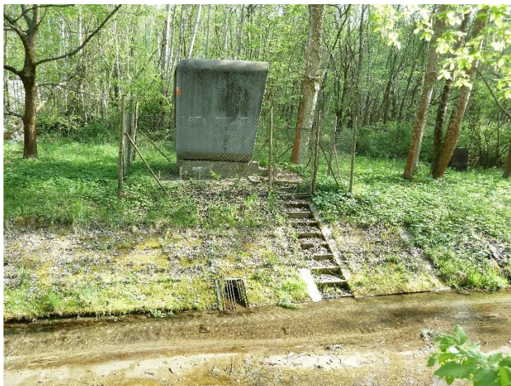
Obr.2 Stávající objekt limnigrafu včetně měrného profilu
