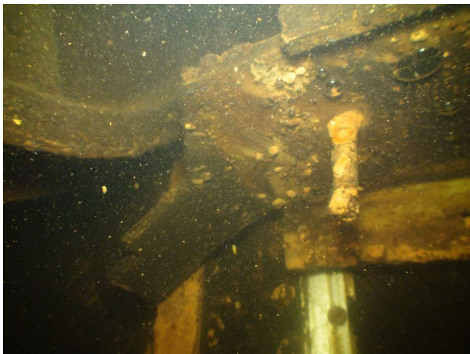
Podvodní pohled na práh stavítka s chybějícím prahovým dubovým těsněním
