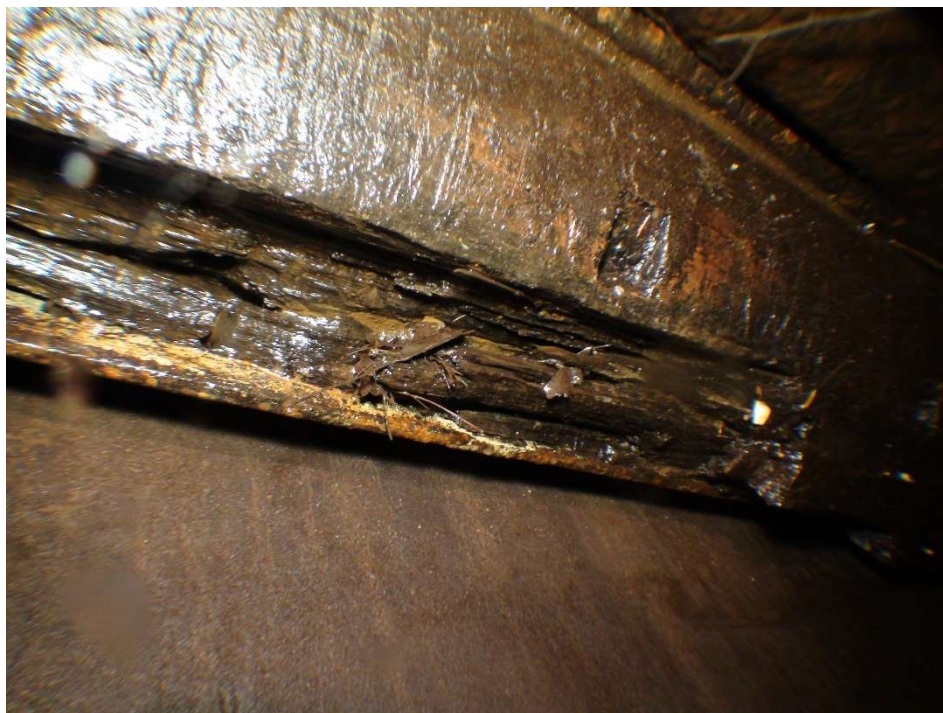
Pohled na stavítko po vodě – detail prahového dubového těsnění
