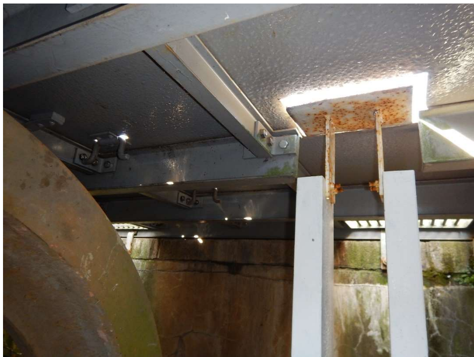
Pohled na kryt šachty stavítka z vnitřního prostoru – vlevo řetězové kolo, vpravo cévová tyč
