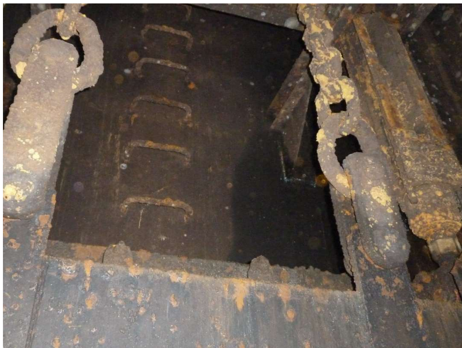
Pohled na stavítko po vodě – v popředí úchyty řetězů protizávaží, vpravo pružné zakončení cévové tyče
