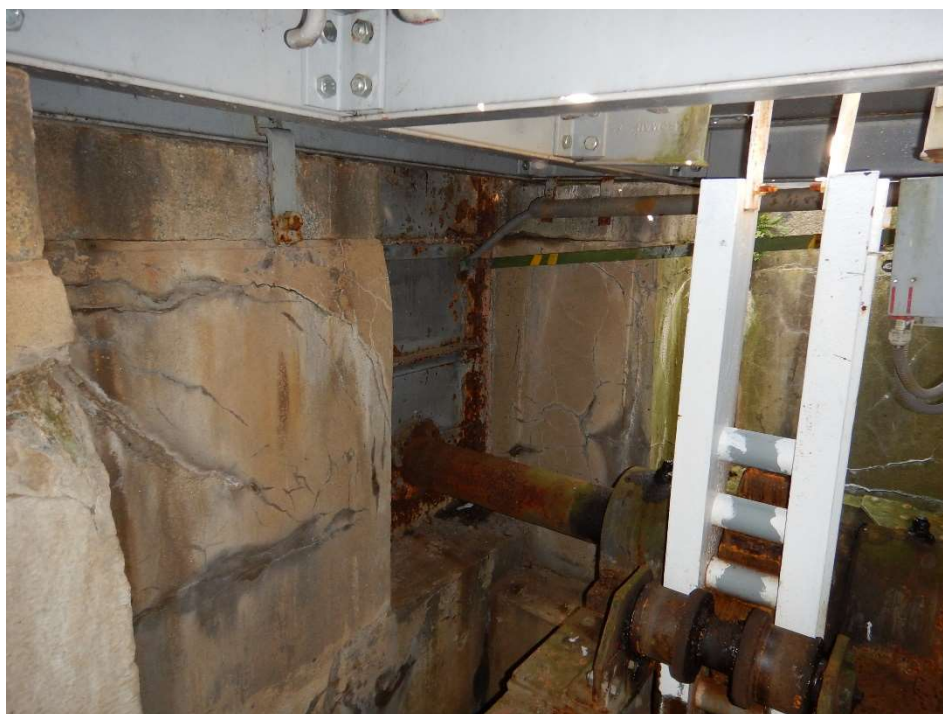
Pohled na průchod cévové hřídele do strojovny pohybovacího mechanismu
