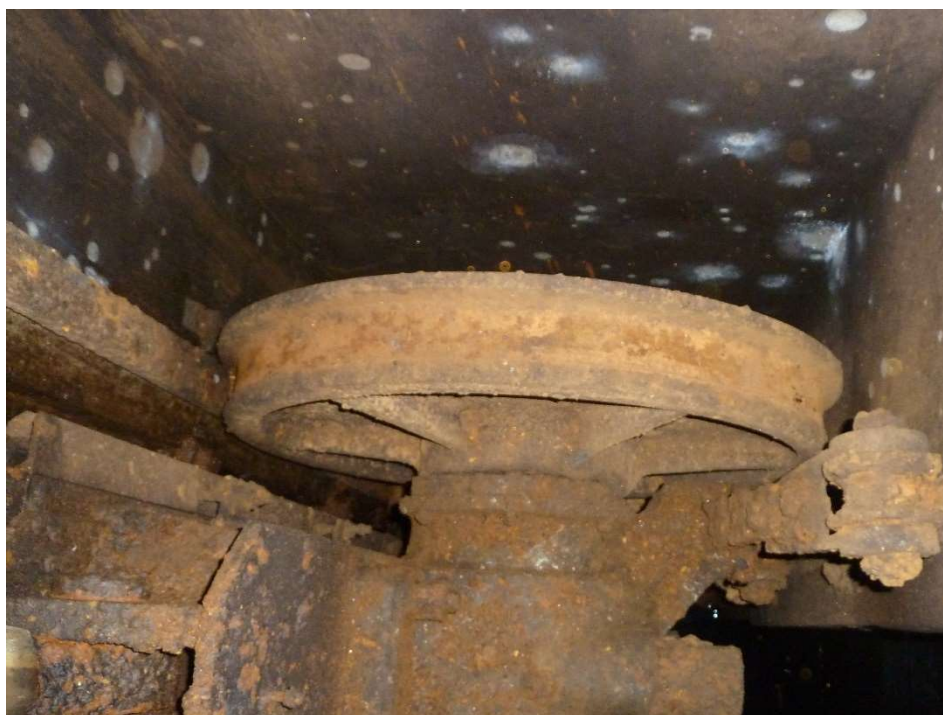
Pohled do drážky stavítka – vlevo pojezdová kolejnice, vpravo rolna zpružiny, mezi nimi pojezdové kolo
