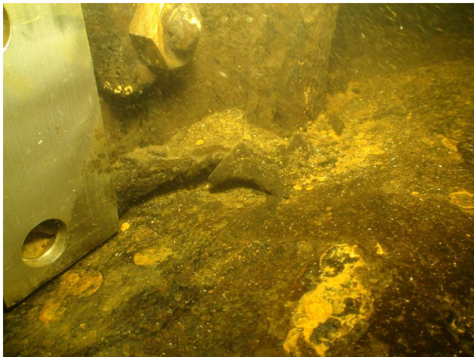
Podvodní pohled na patu boční těsnicí lišty na rámu stavítka – vpravo konec pojezdové kolejnice s úchytkou
