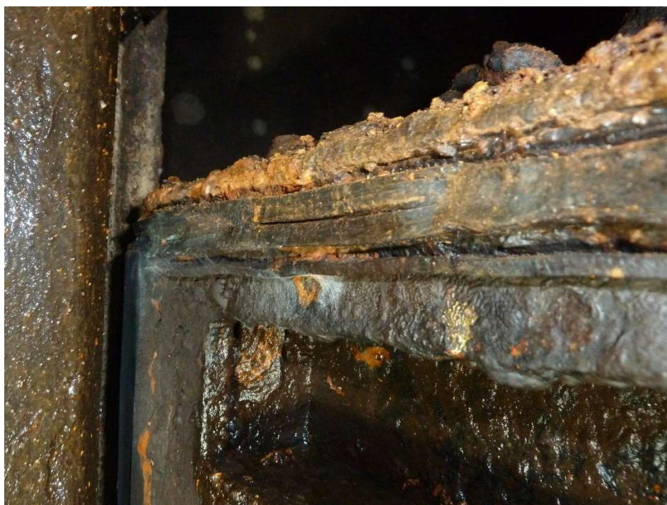
Pohled na stavítko proti vodě – detail horního těsnění
