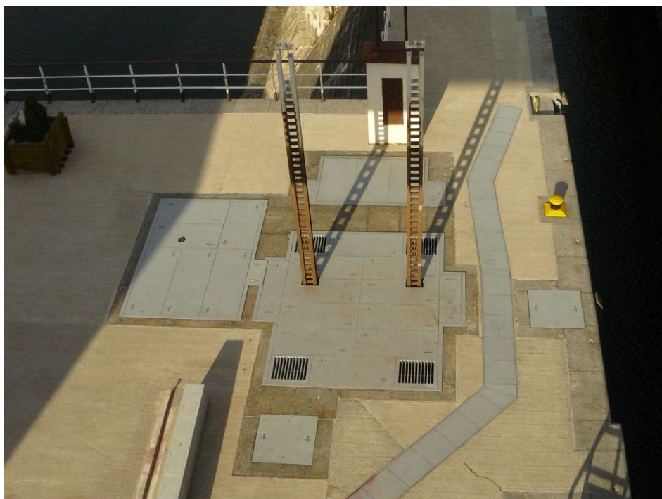
Pohled na kryty šachty stavítka, pohybovacího mechanismu a dolního pr. hrazení
