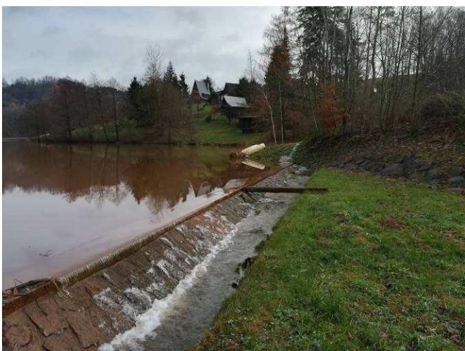
Obr. 3 Pohled na bezpečnostní přeliv (budoucí sjezd do nádrže)
