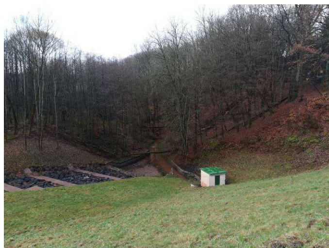
Obr. 4 Pohled na vzdušnou stranu hráze, skluz a vývar
