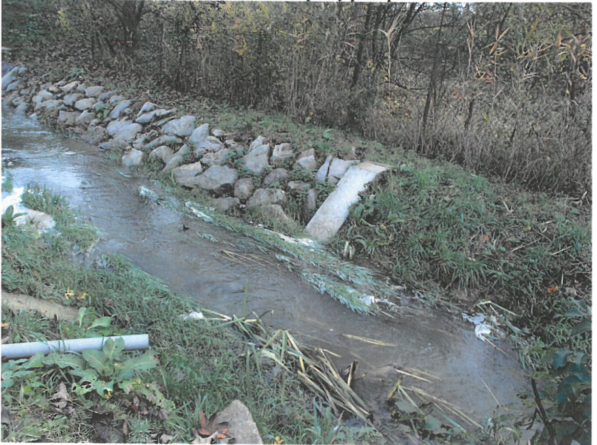
Ukončení investice opevnění ř.km. 2,740 pevný práh pod VN Drahotuše
