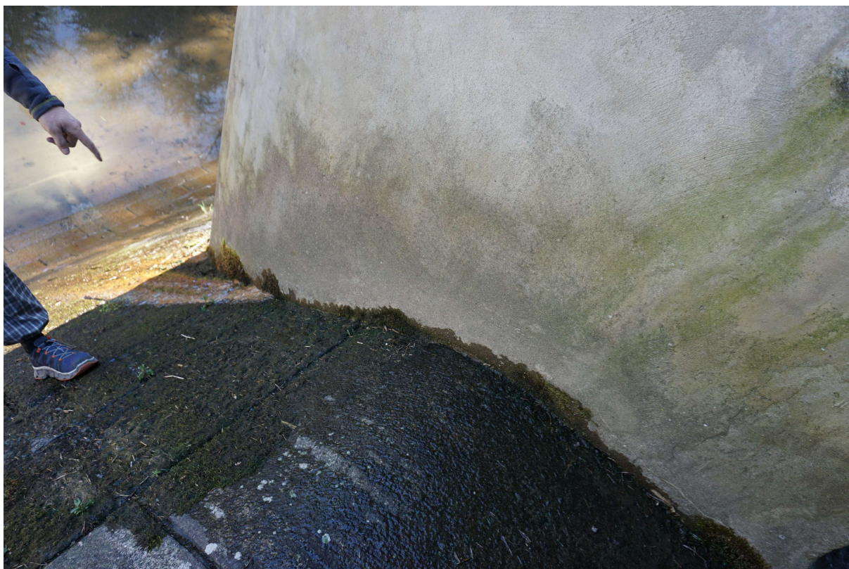
5. Pohled na spáru mezi středovým pilířem a přelivnou hranou
