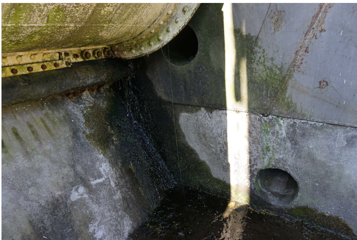
6. Průsaky na styku těsnění pohyblivé části a středového pilíře
