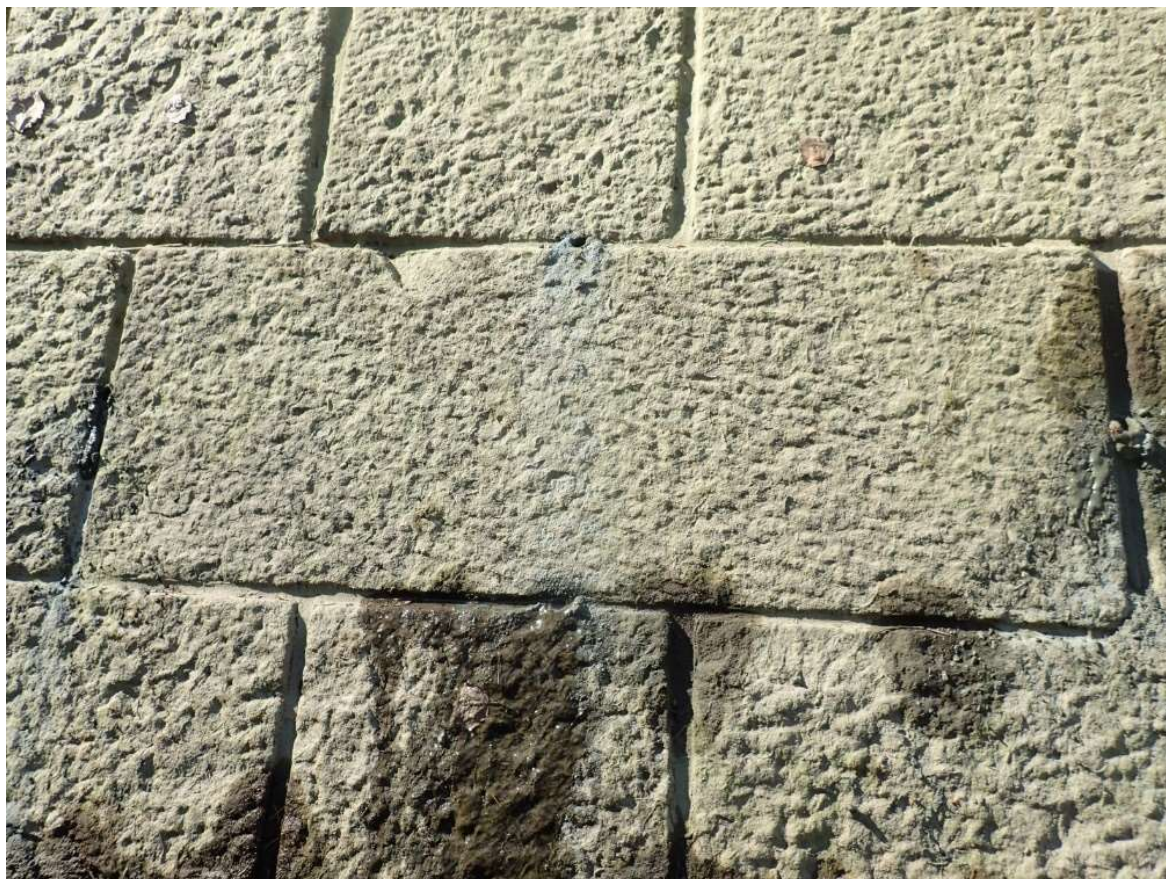
8. Detail kamenného obkladu přelivné hrany
