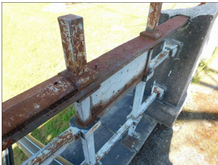
Silná koroze zábradlí na předmostí
