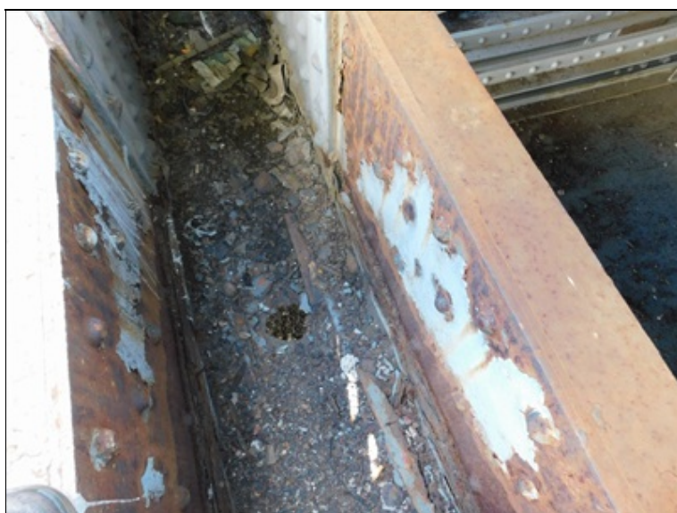
Pole 3 - levá strana, silná koroze plechů "U" profilu dolního nosníku
