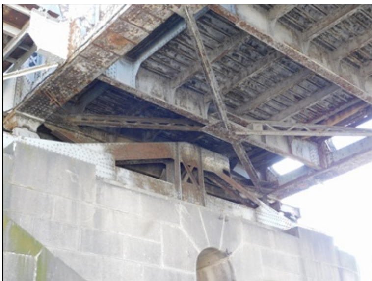
Pohled na kotevní mechanismus nosné konstrukce nad pilířem P3
