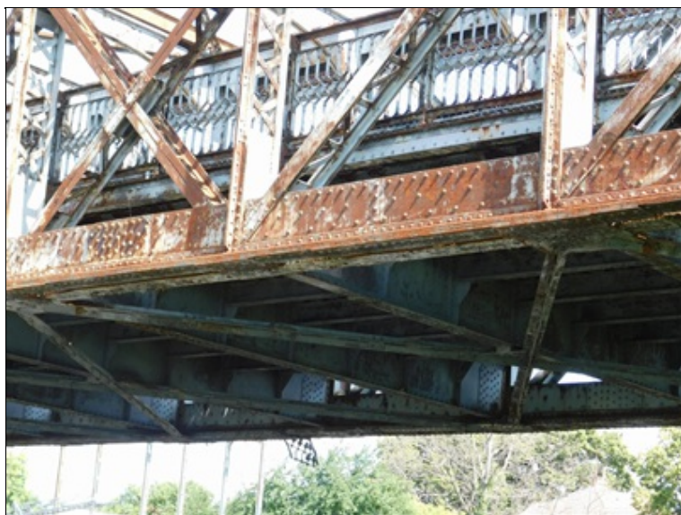
Pole 1 - pravá strana, koroze dolního nosníku
