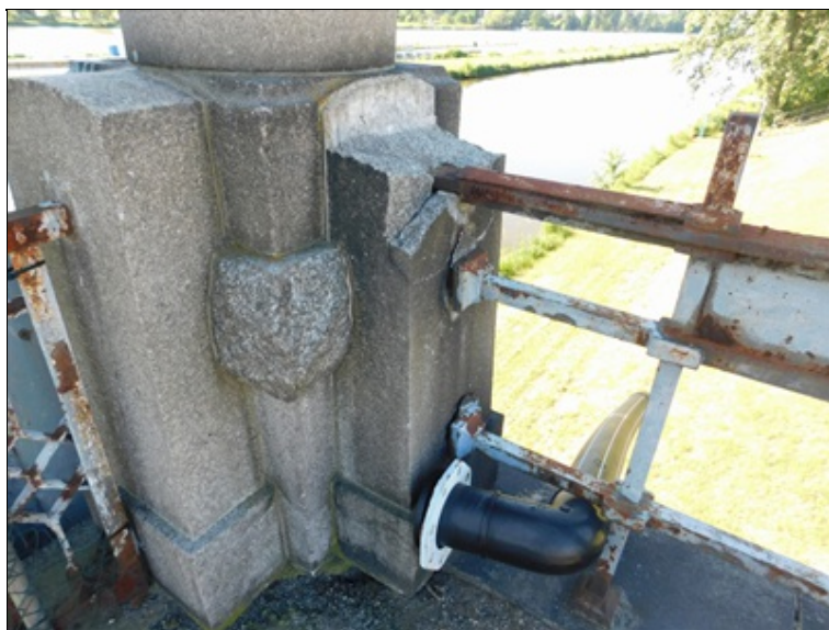
Ulomená horní hrana kamenného zábradlí, volně končící chránička inženýrské sítě na pravé straně nad opěrou OP1
