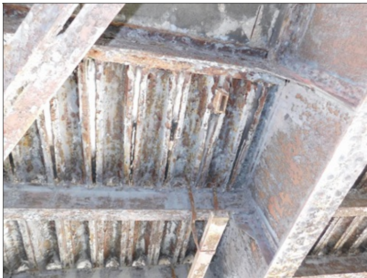
Silná koroze mostnic Zores
