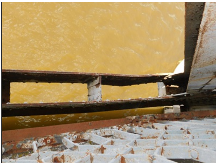
Pole 2 - pravá strana, nárazem poškozený dolní nosník
