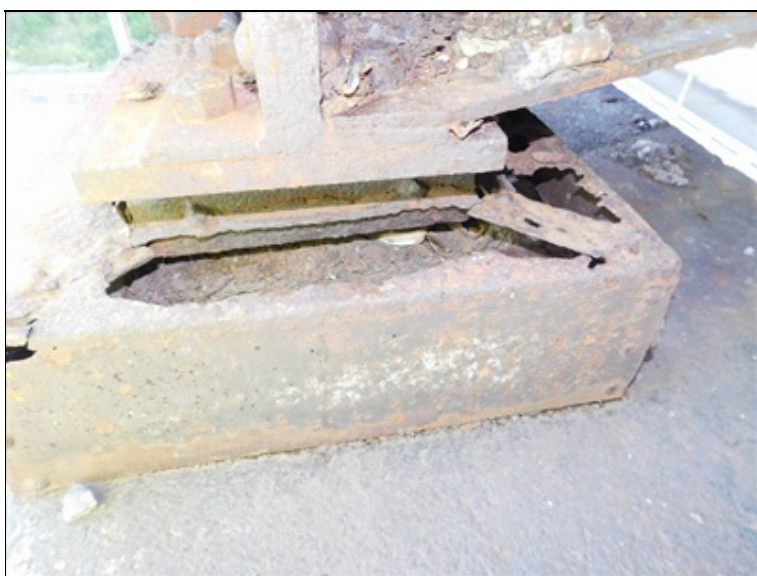
Levé ložisko pole 5 nad pilířem P5, silná koroze ochranného oplechování
