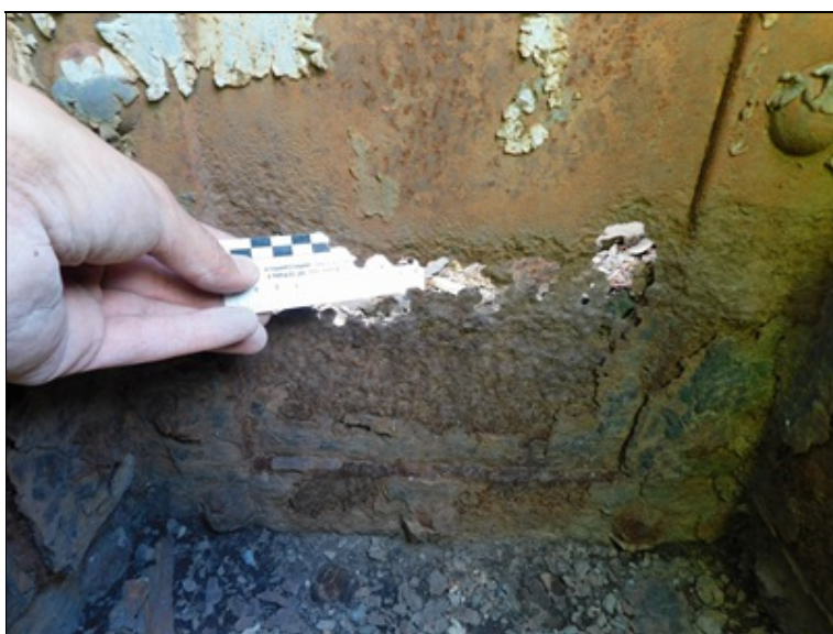
Pole 3 - prokorodovaný plech svislice dolního styčníku
