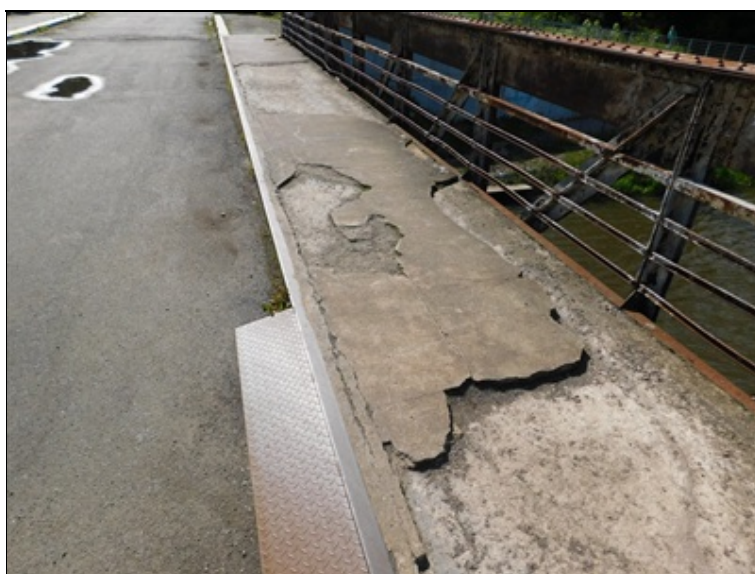
Rozpad betonového chodníku na pravé straně v poli 5, hloubka rozpadu 50 mm
