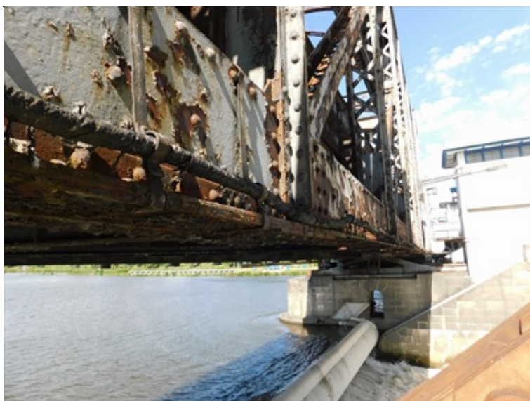
Pole 4 - silná koroze dolního pásu, levá strana
