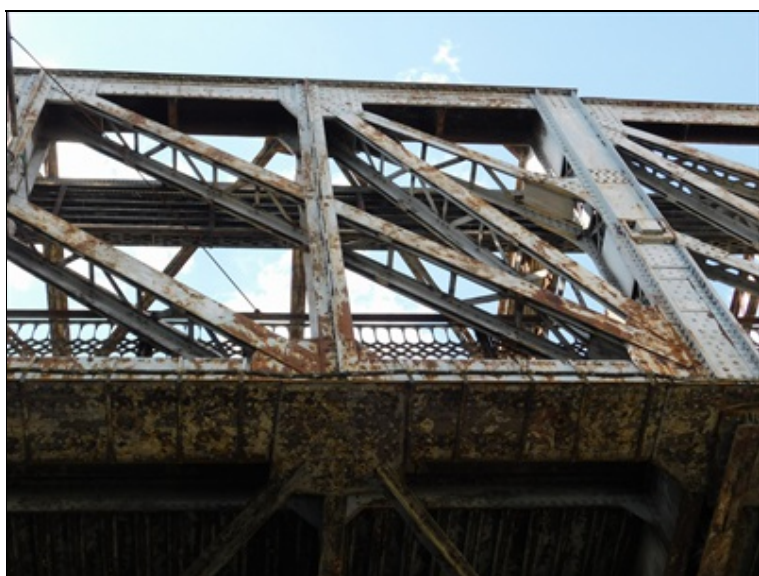
Pole 2 - levá strana, koroze dolního nosníku v místě konzoly z pole 3
