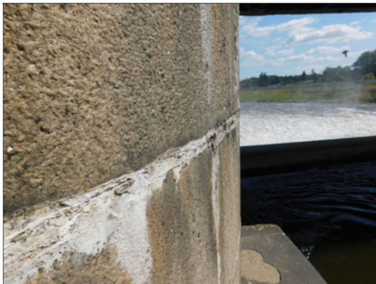
Lokální průsaky ve sparách zdiva pilíře P3
