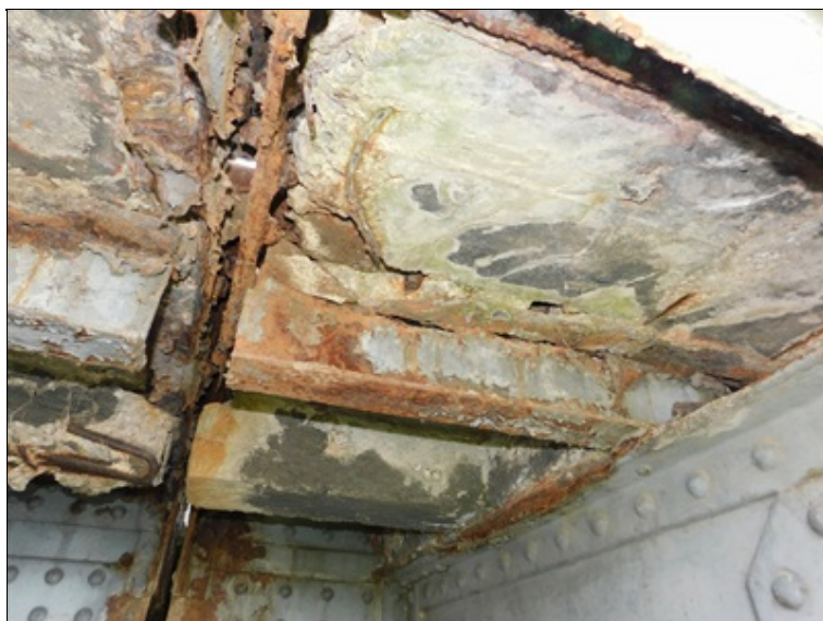
Spodní líc nosné konstrukce u mostního závěru nad pilířem P2 - silná koroze
