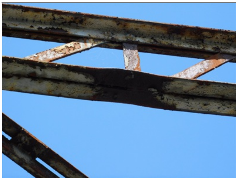
Pole 1 - nárazem poškozené horní ztužení, typická závada po celé délce mostu
