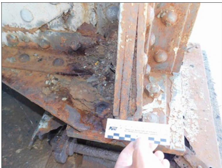
Pole 5 - koroze a vyhnutí nadložiskových plechů
