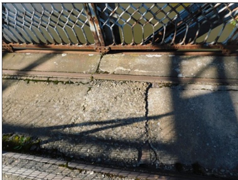
Rozpadající se betonový chodník na pravé straně, pole 1
