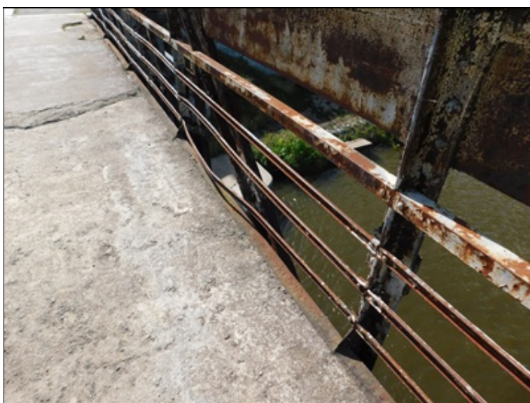
Deformace vodorovné výplně zábradlí v poli 5
