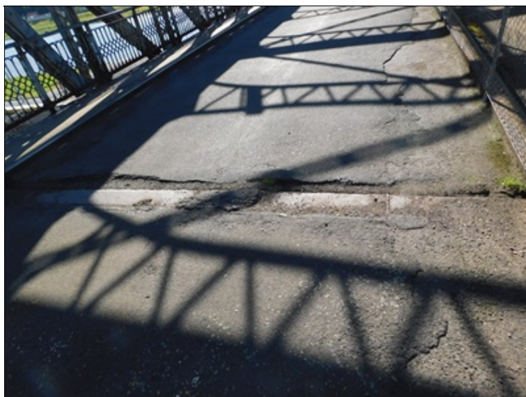
Poškozená vozovka v místě mostního závěru nad pilířem P2
