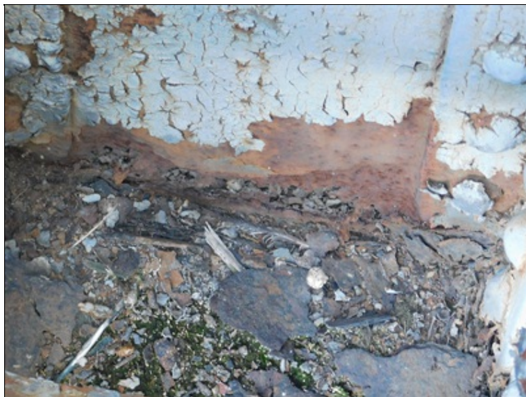
Pole 3 - prokorodovaný plech svislice dolního styčnicku
