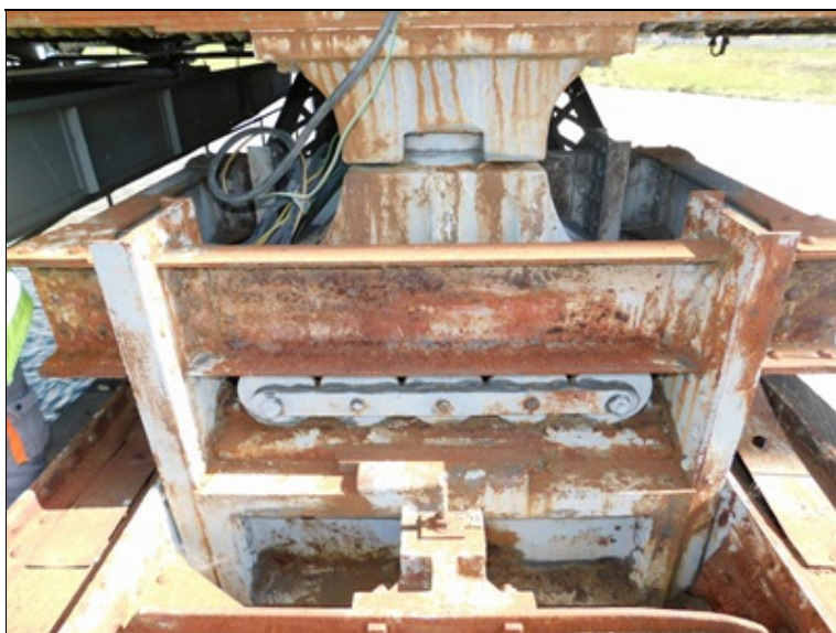
Pravé ložisko na pilíři P4
