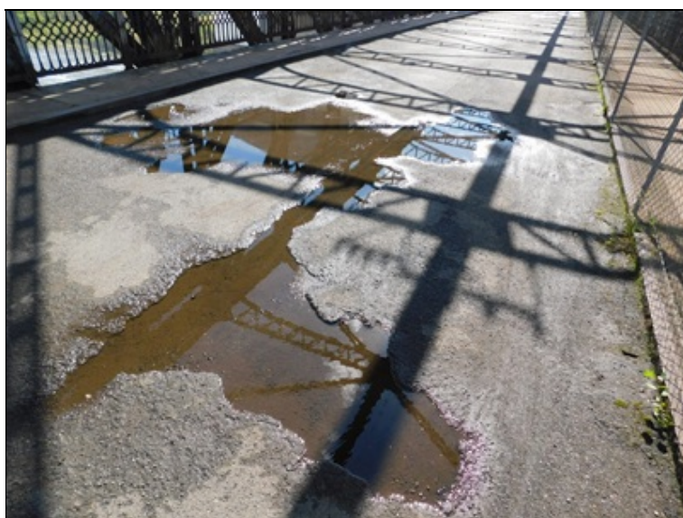
Vozovka na mostě je deformovaná, špatně odvodněná, kaluže s trvale stojící vodou
