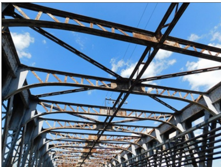
Pole 2 - detail povrchové koroze horního ztužení
