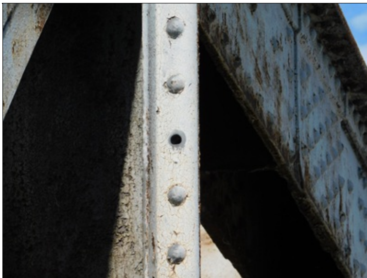
Pole 4 - lokálně chybějící nýt u svislice
