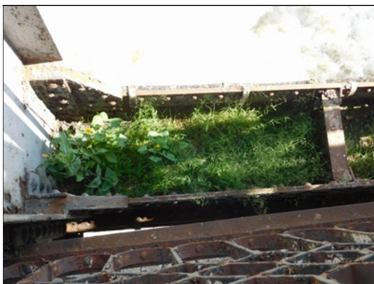
Pole 4 - nečistotami a vegetací vyplněný "U" profil dolního nosníku
