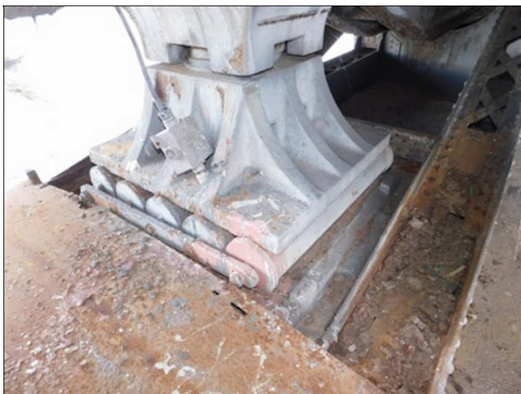
Levé ložisko na pilíři P4
