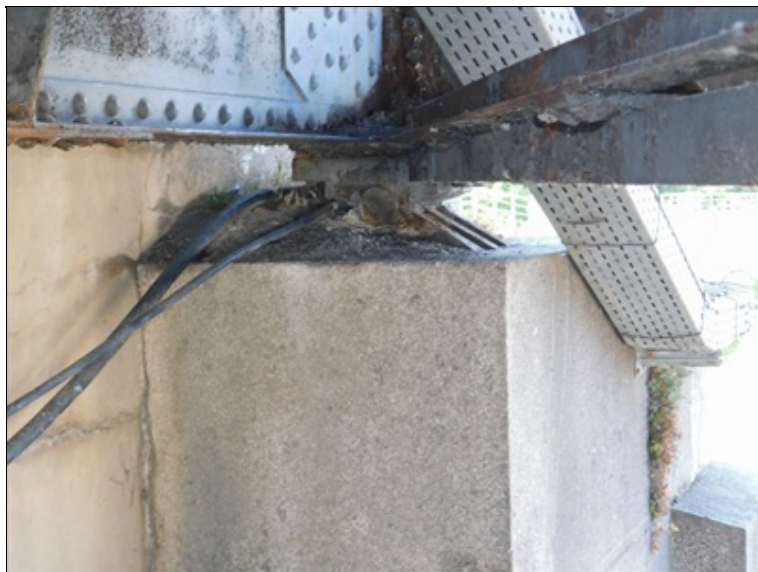
Pravé ložisko nad opěrou OP6, množství nečistot
