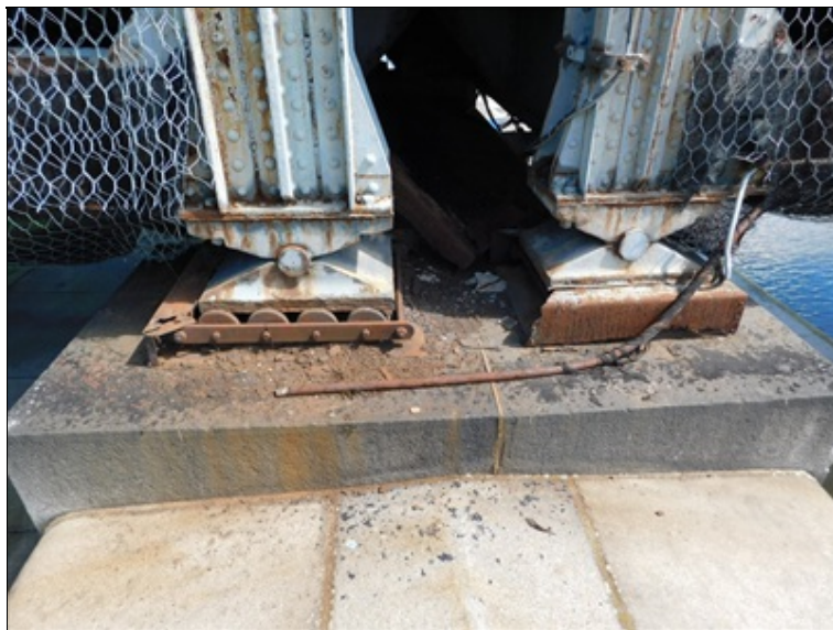
Pravá ložiska na pilíři P2 - silná koroze
