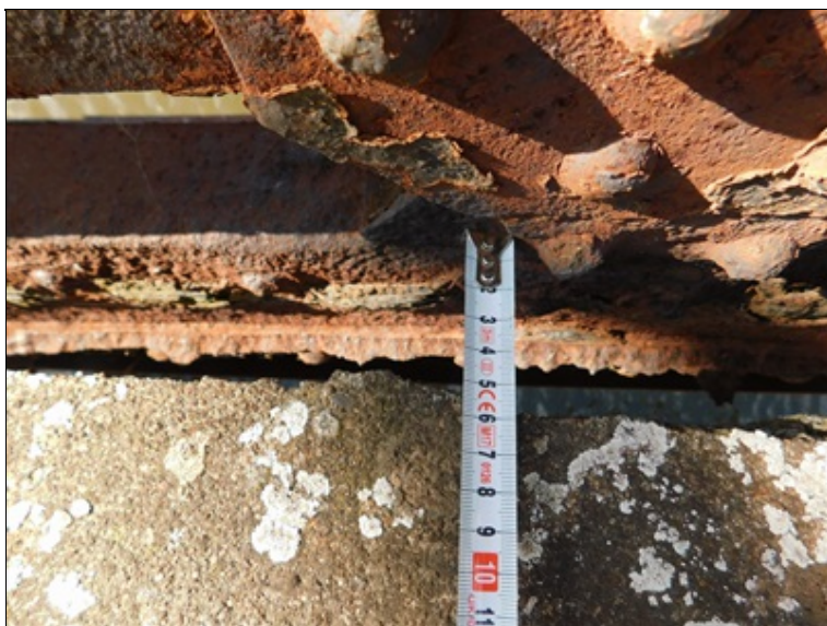
Vyhnuté zábradlí v poli 4, silná koroze spodního podélníku mostovky - typická závada
