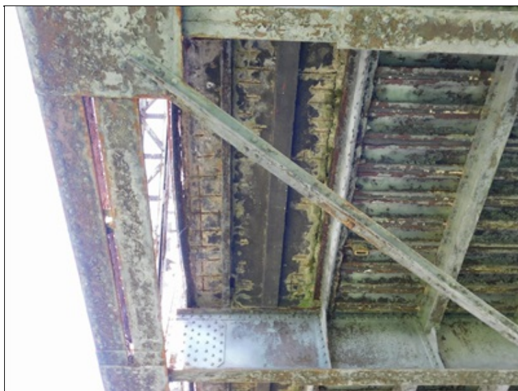
Havarijní stav betonového chodníku na pravé straně v poli 1
