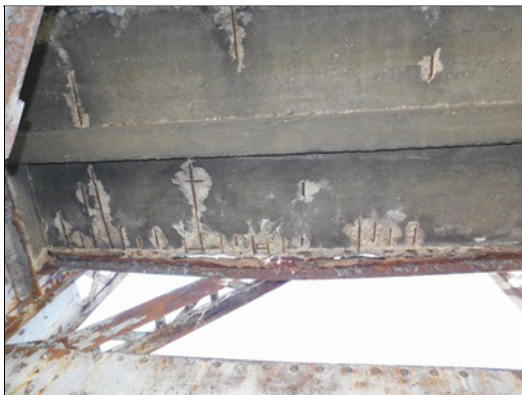
Poškozený chodník na pravé straně v poli 4
