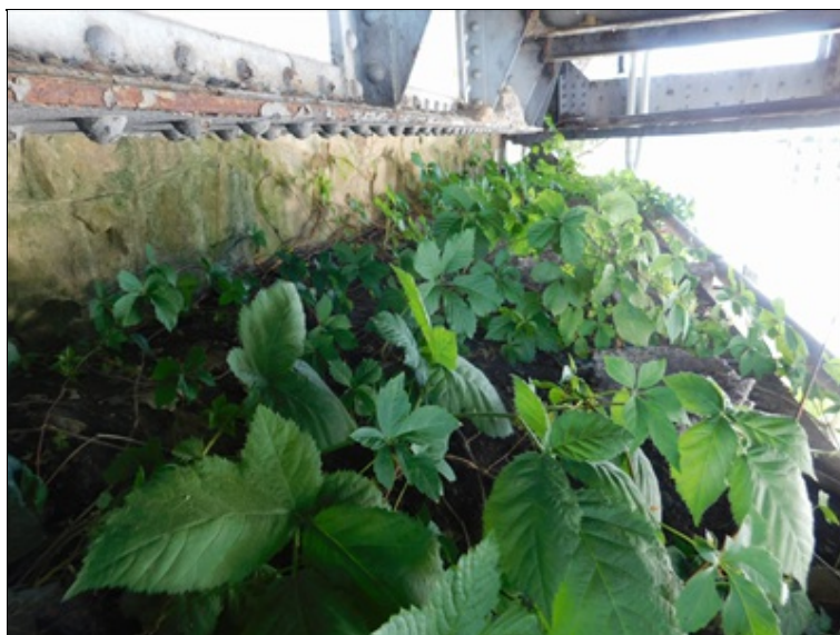
Množství nečistot a vegetace na úložném prahu opěry OP1
