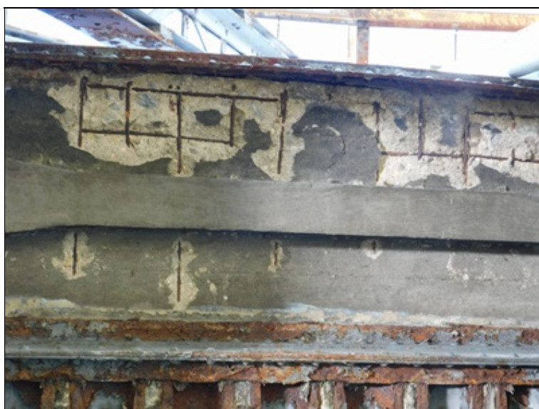
Poškozený spodní líc chodníku na levé straně v poli 1, degradace betonu, koroze výztuže
