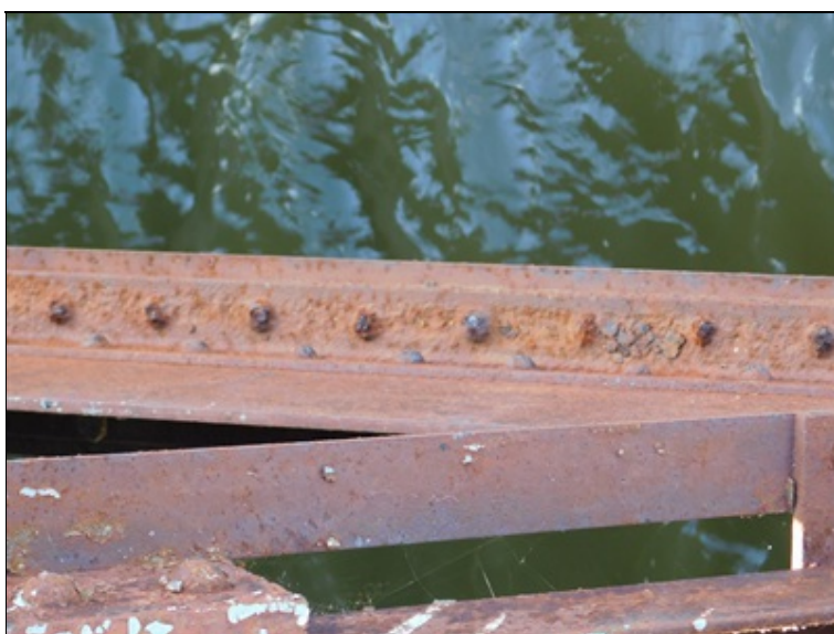
Pole 5 - silná koroze dolního pásu na pravé straně
