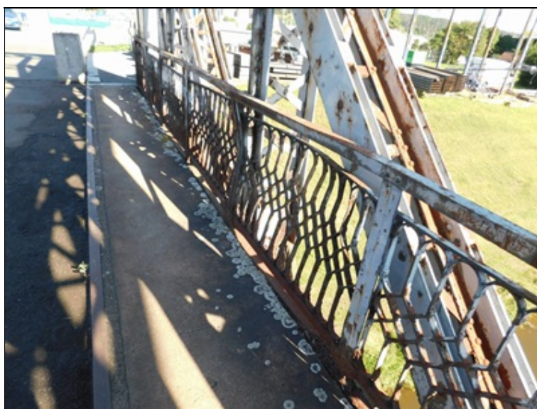
Deformované zábradlí od nárazu na levé straně v poli 1
