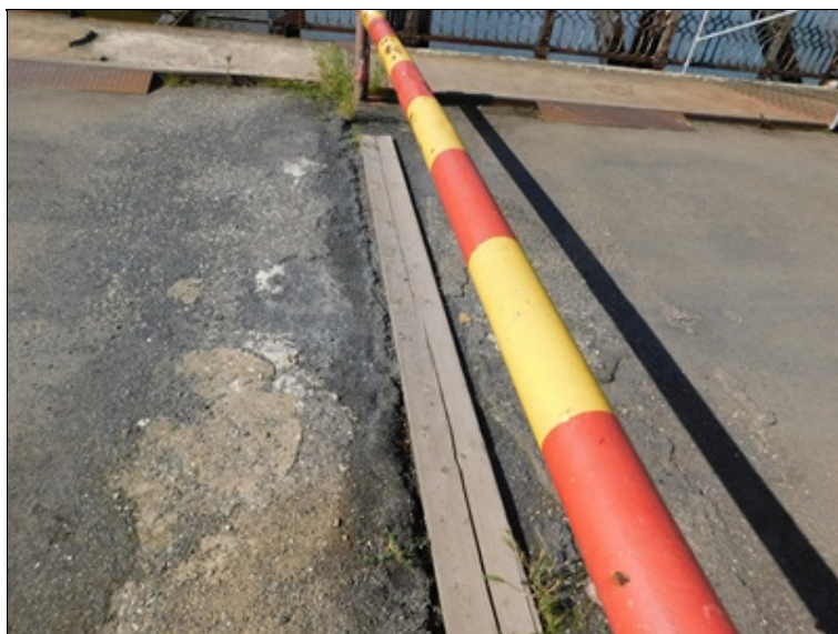
Poškozená vozovka nad mostním závěrem nad pilířem P5 provizorně překrytá dřevem
