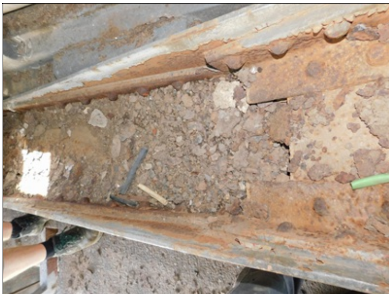
Korozní poškozený kotevní mechanismus kotvení nosné konstrukce do pilíře P4
