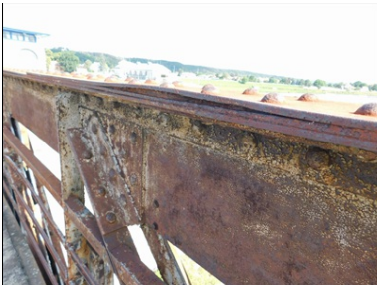
Pole 5 - silná koroze a vyhnutí plechu horního pásu
