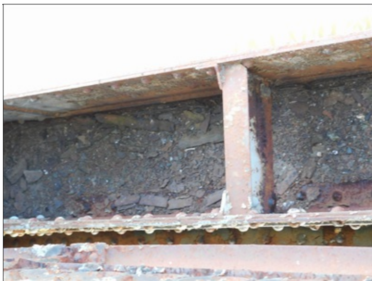
Pole 4 - množství korozních zplodin v "U" profilu dolního nosníku
