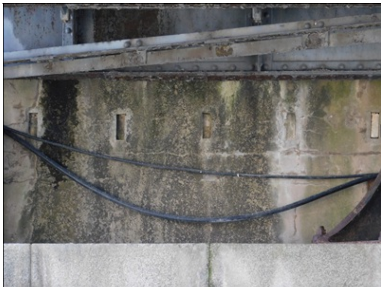
Silné průsaky dilatační sparou nad opěrou OP6 na líc opěry
