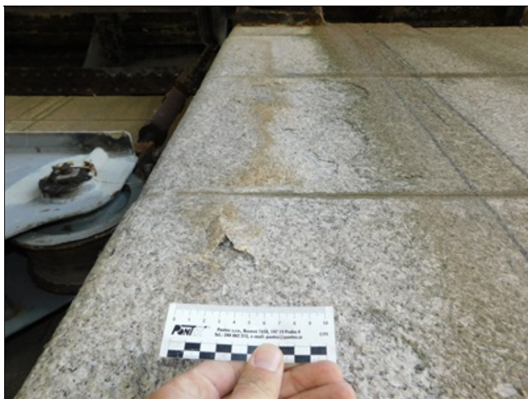
Povrchová degradace žuly pilíře P4
