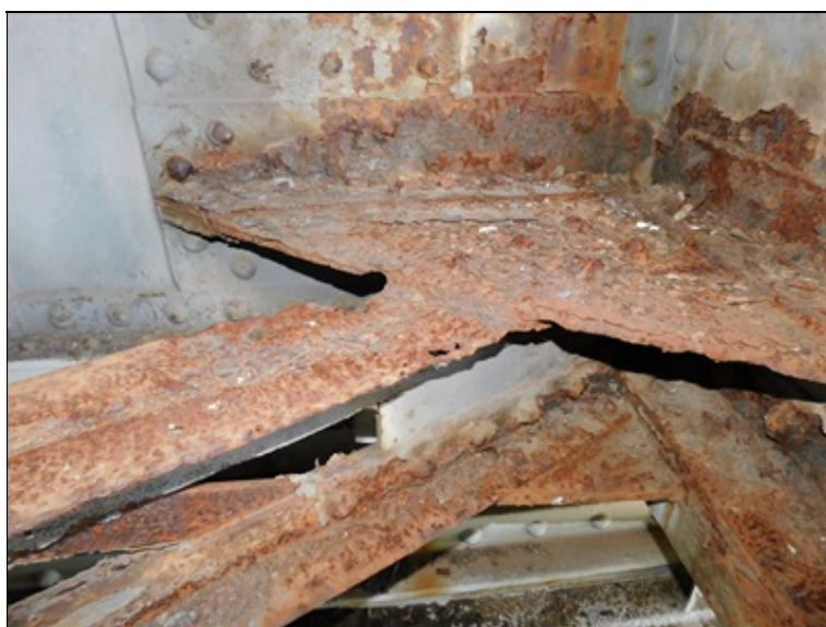
Pole 3 - silná koroze dolního ztužení v místě napojení na styčnickový plech dolního nosníku
