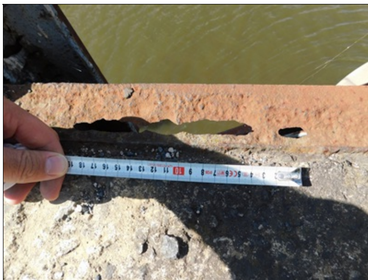
Prokorodovaný krajní dolní podélník chodníkové části mostovky
