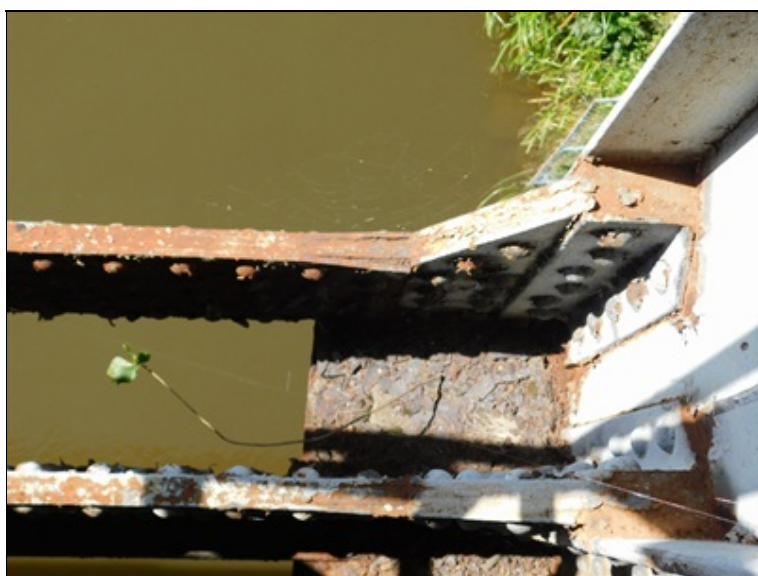
Pole 1 - detail koroze dolního nosníku v místě napojení do stýčnickového plechu
