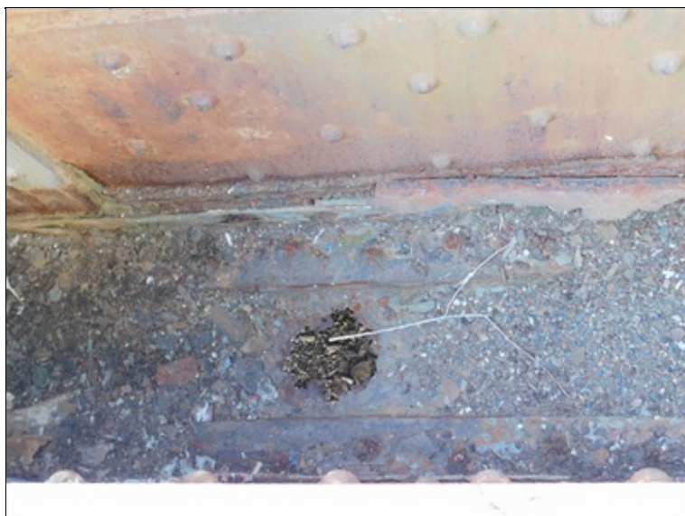
Pole 3 - levá strana, prokorodovaný plech "U" profilu dolního nosníku
