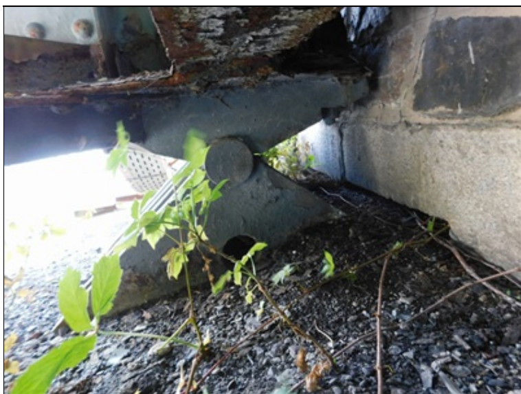
Zanesené ložisko na opěře OP1 vpravo
