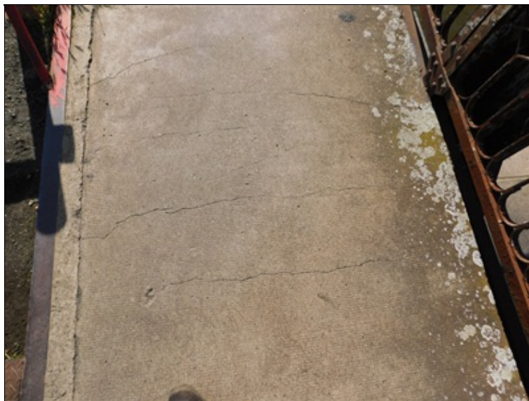
Příčné trhliny na horním líci betonového chodníku v poli 4
