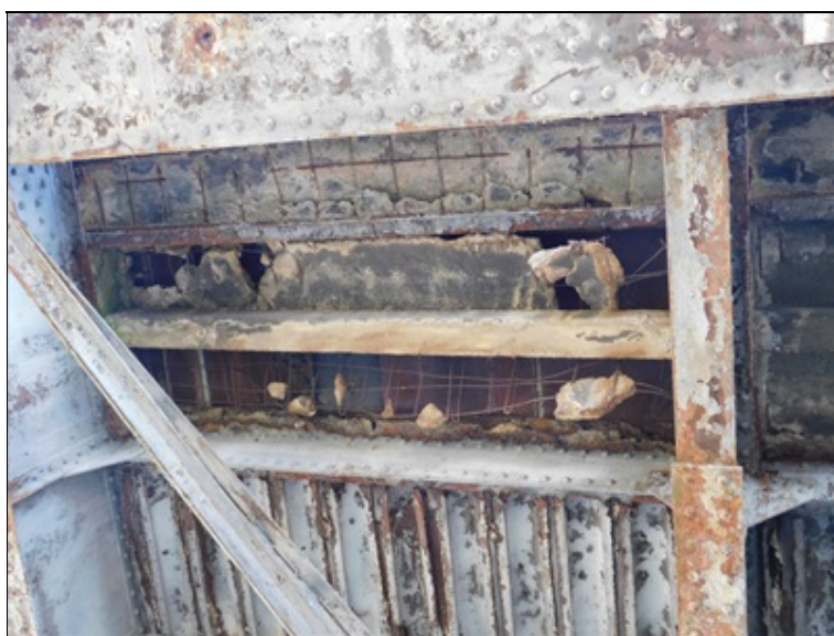
Havarijní stav betonového chodníku na pravé straně v poli 2
