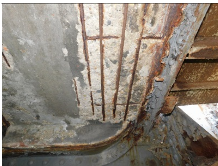
Degradace chodníku na levé straně nad pilířem P3
