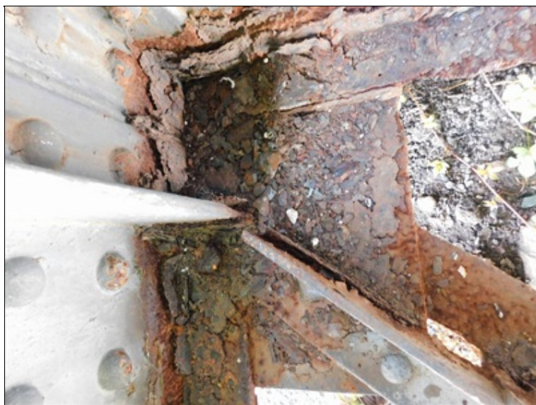
Pole 1 - detail koroze dolního stýčnickového plechu
