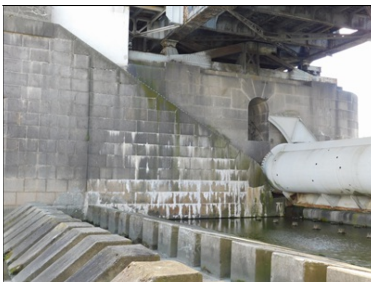
Silné výluhy pojiva ve sparách zdiva pilíře P3
