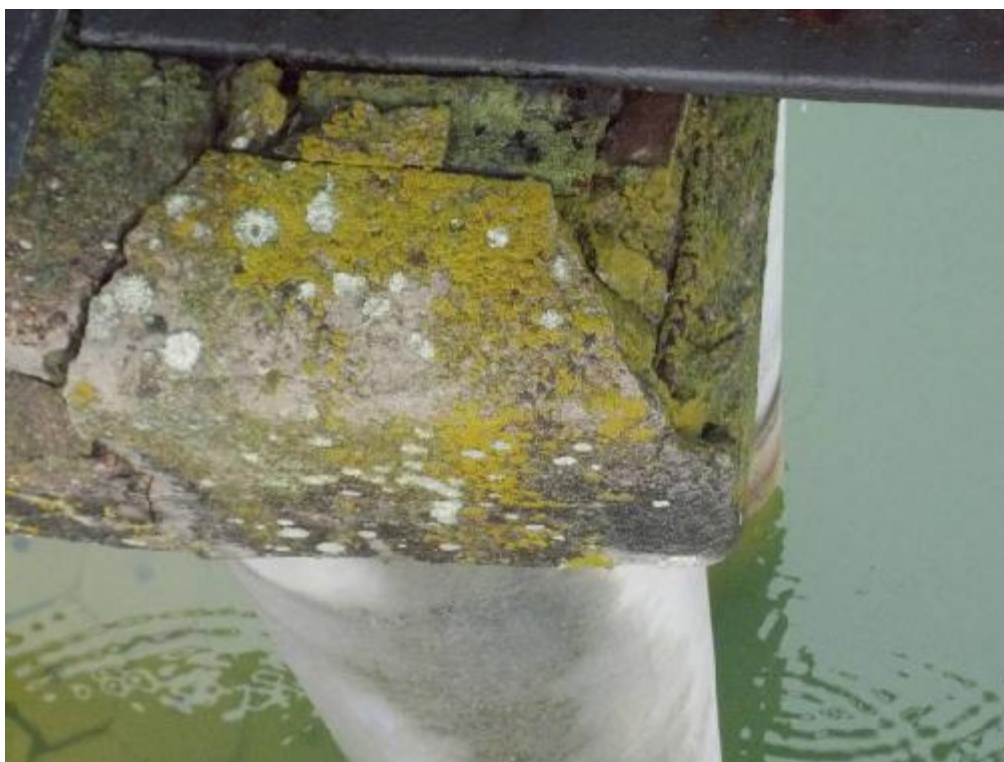
Detail poškození úložného prahu pilíře
