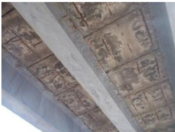
Poškození mostovky narušení tahového líce desek mostovky
