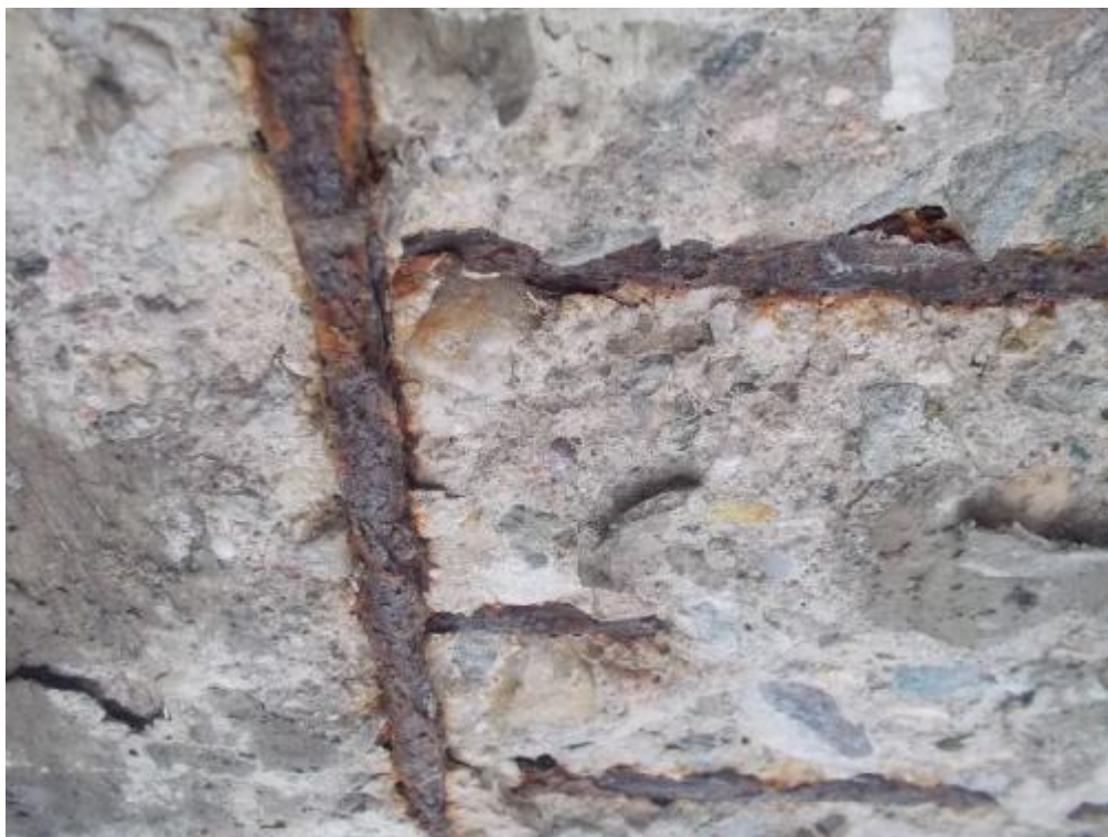
Detail poškození spodního líce betonových trámů mostovky
