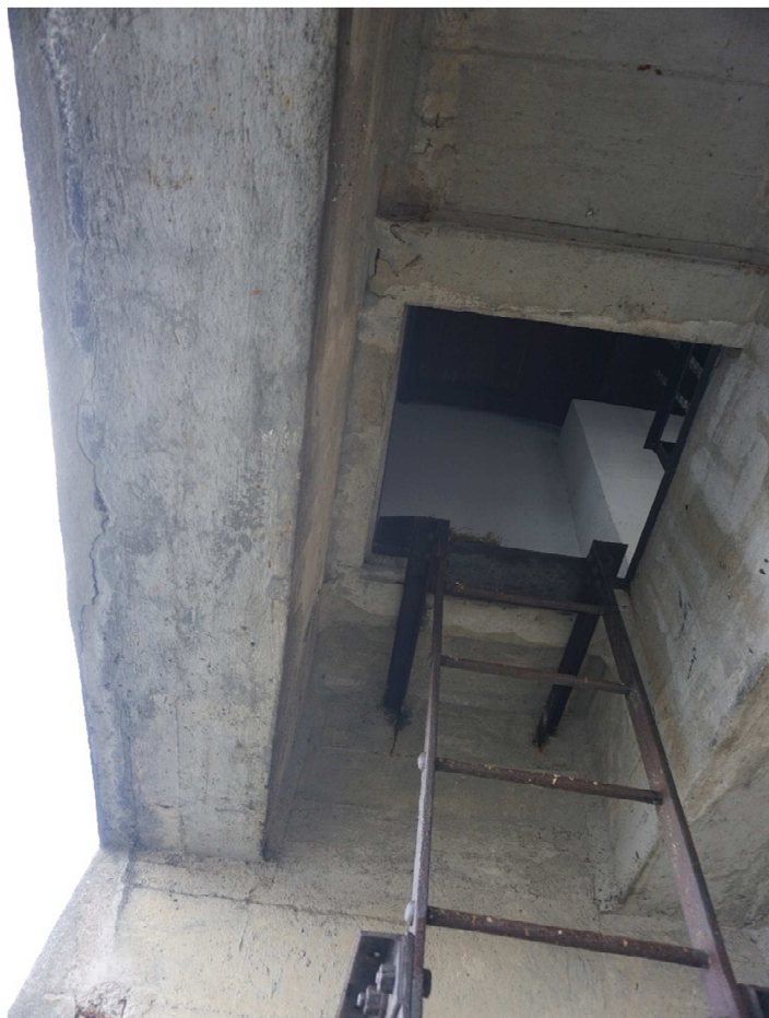
3. Strojovna – revizní otvor pro vstup na plošinu pod strojovnou
