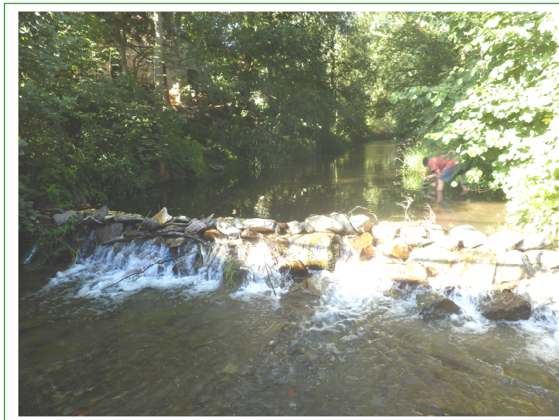
Foto 4: Náplav v důsledku nepovoleného živelného vzdutí u mostu nad SO 06
