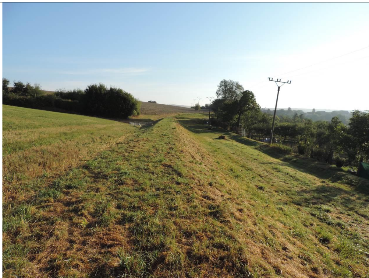
Mez s průlehem v k.ú. Letonice (foto Sweco Hydroprojekt a.s.)
