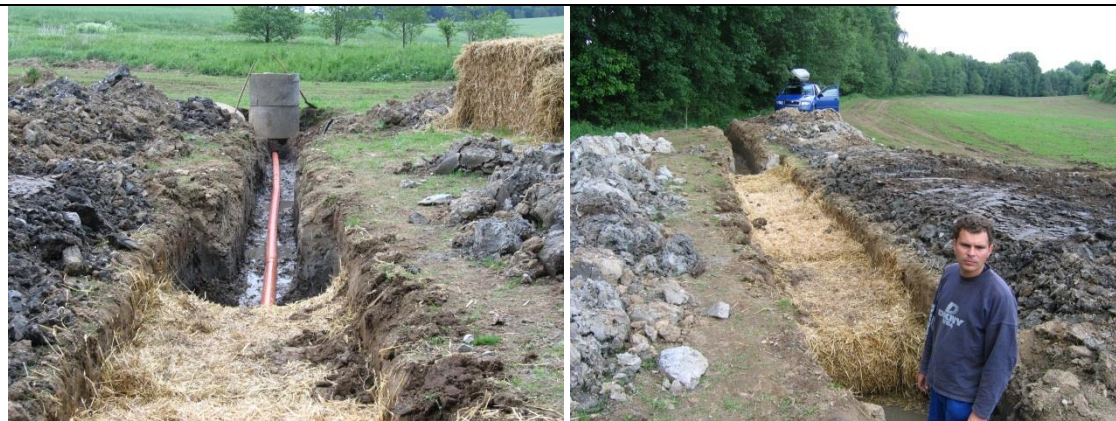
Obr. 2 Příklad realizace bioreaktoru s využitím náplně z obilné slámy (foto F. Doležal)
