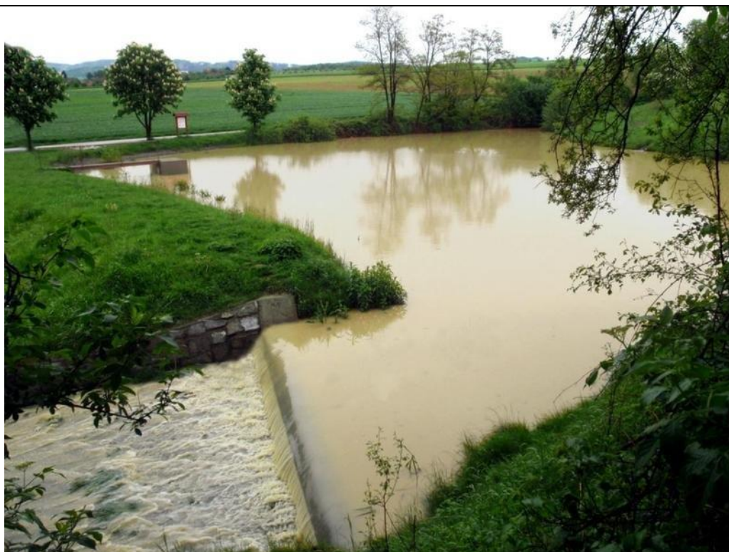
Protierozní sedimentační nádrž v k.ú. Štípa (Zdroj: http://soutezszr.spucr.cz )
