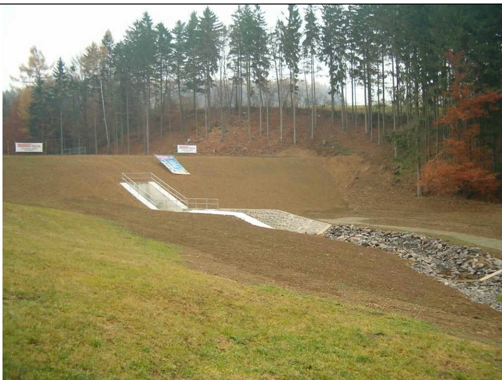
Suchá vodní nádrž Čermná II – koryto pod hrází (foto Sweco Hydroprojekt a.s.)
