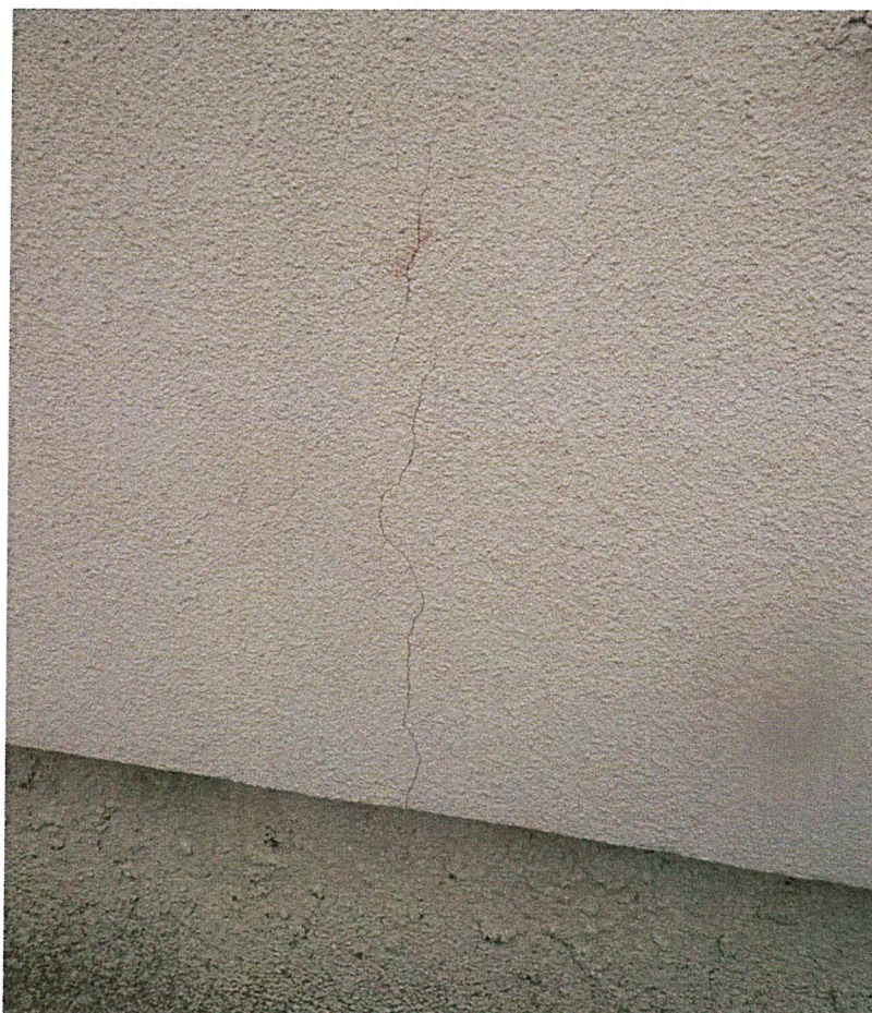
Trhlina mezi obvodovými panely
