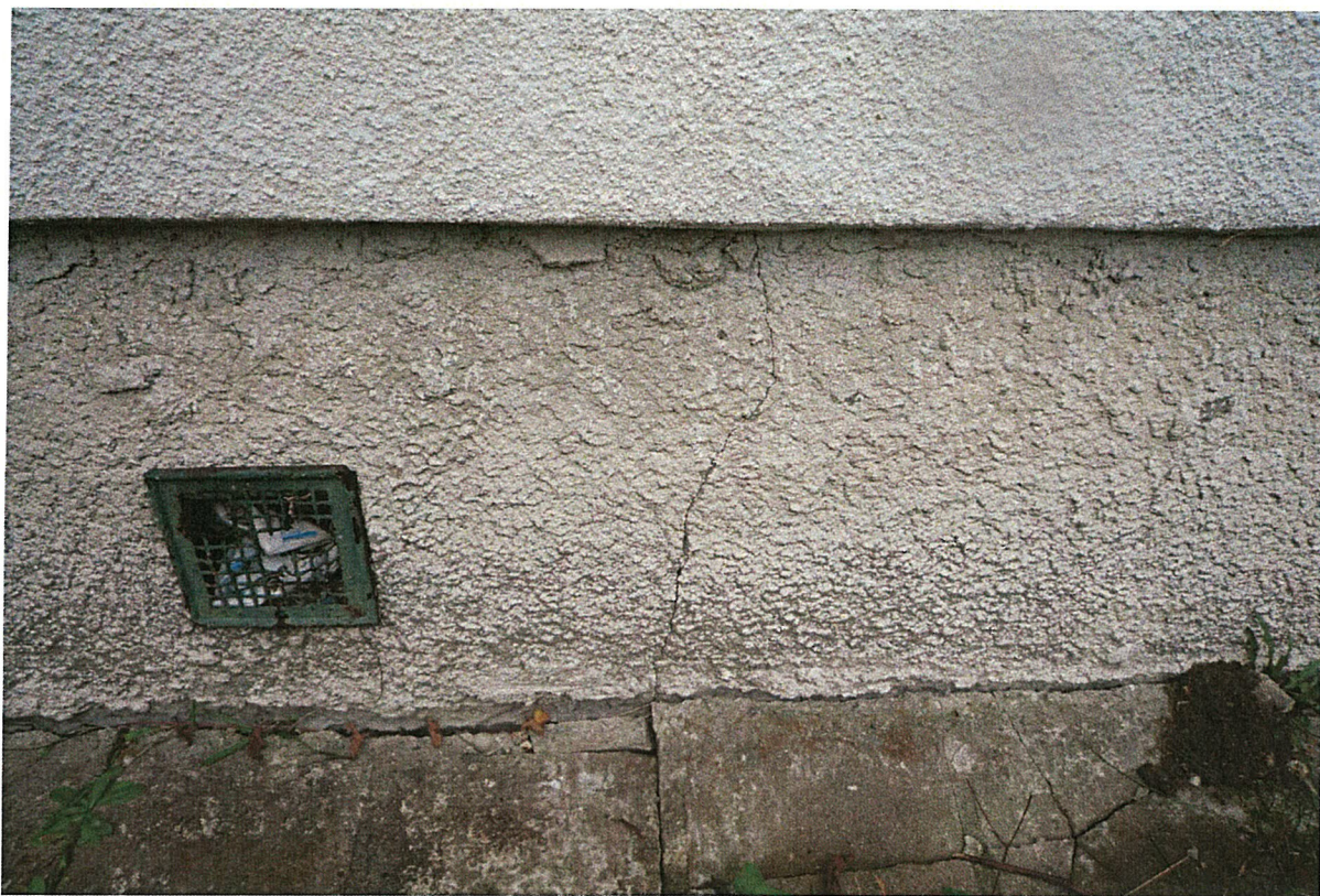
Trhlina mezi obvodovými panely
