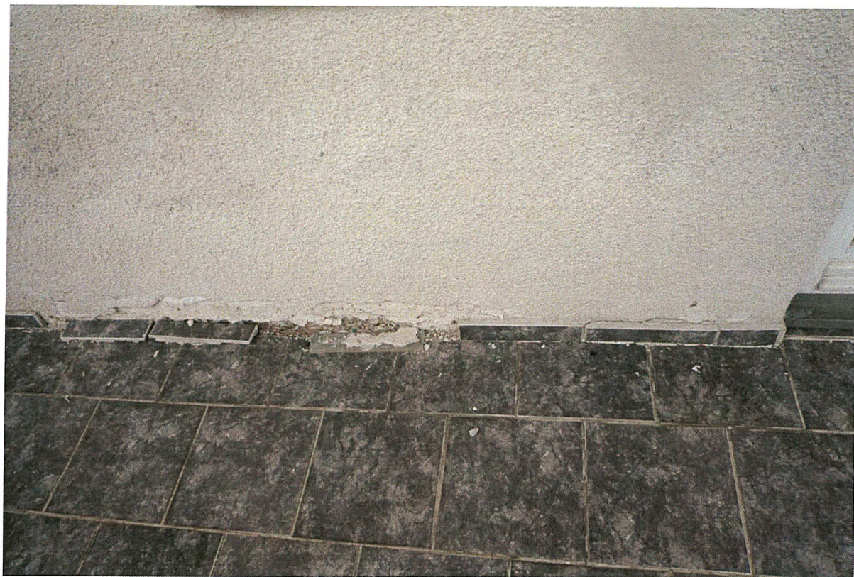
Zatékání do obvodové stěny v místě terasy
