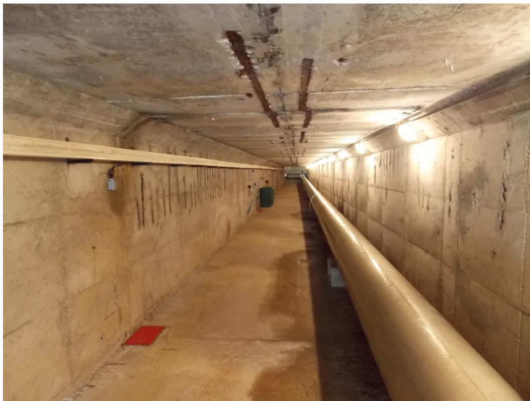
Obr.5 Komunikační chodba s odběrným potrubím – pohled proti vodě
