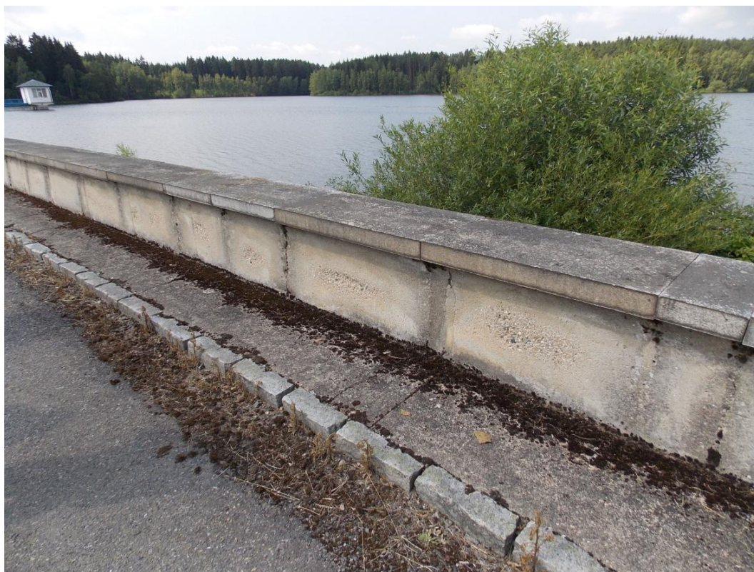
Obr.4 Vlnolam – porušení betonu ve středu dílců
