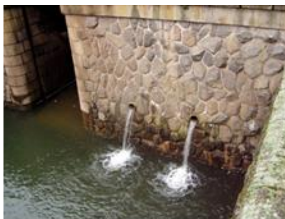
Průsaky vedle segmentového uzávěru
