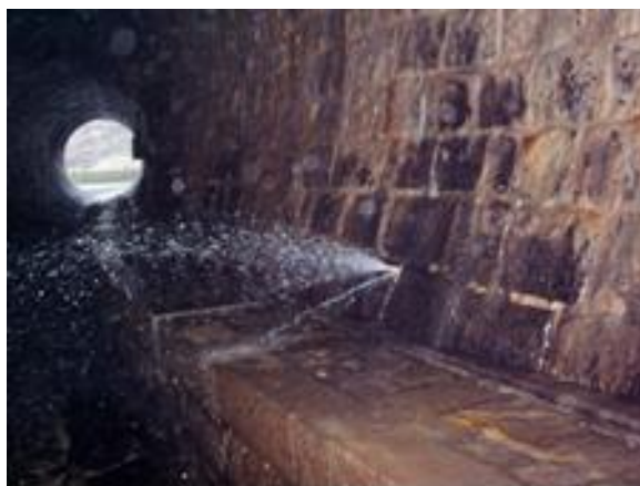
Vývěry v obezdívce levého tunelu
