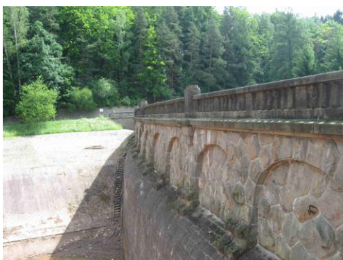
Pohled na římsové parapetní kvádry koruny hráze, návodní strana
