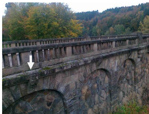
Profil vhodný pro sazení výškového bodu na koruně hráze, vzdušní strana
