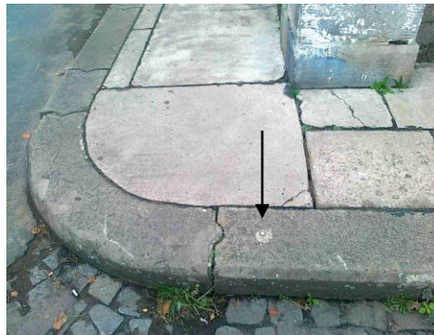
Výškový bod 1, vzdušná strana konec hráze, obrubník chodníku
