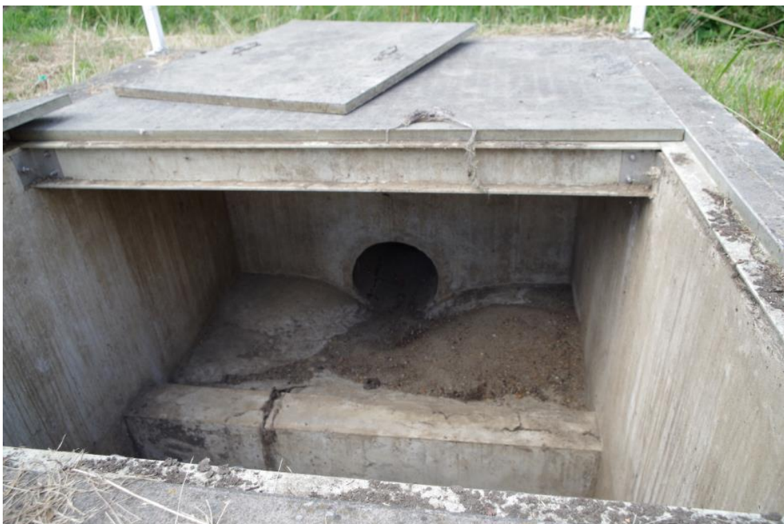
Obr. 12 Odlehčovací komora F-OK2 V – odlehčení
