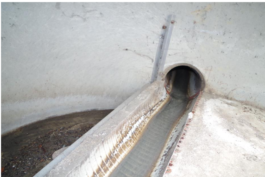
Obr. 5 Odlehčovací komora C-OK1 JIH - přítok
