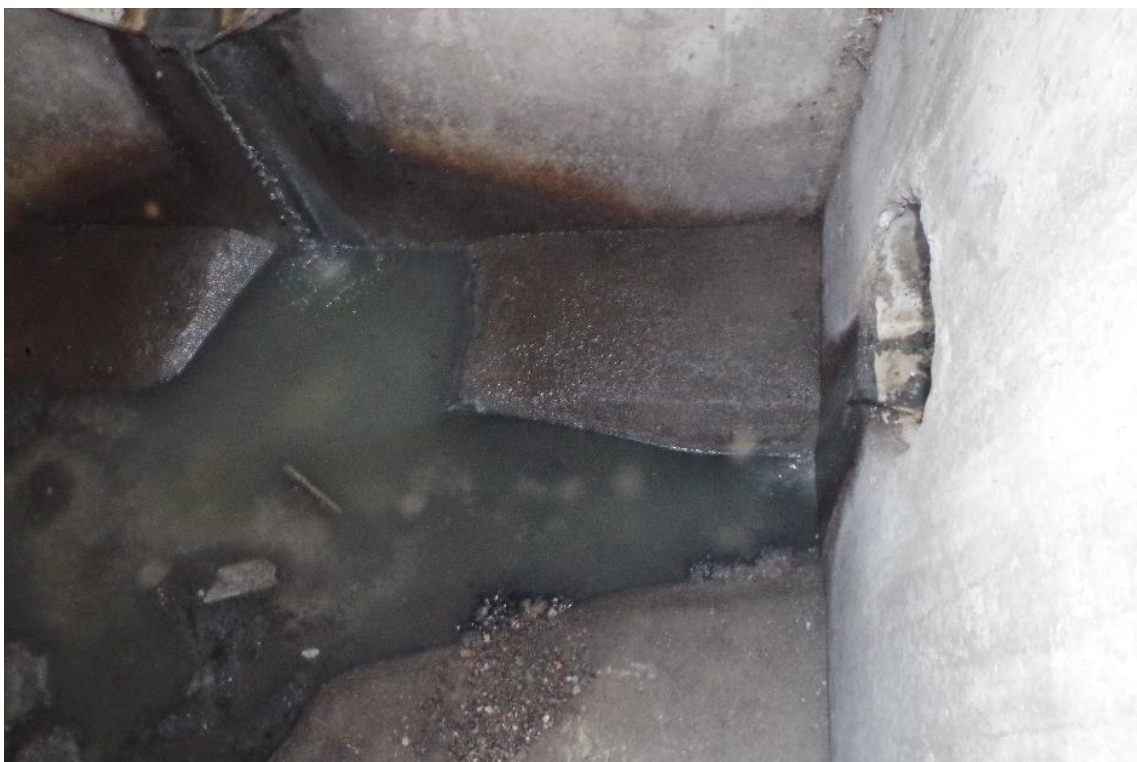
Obr. 8 Odlehčovací komora D-OK3 V – vlevo přítok DN 150
