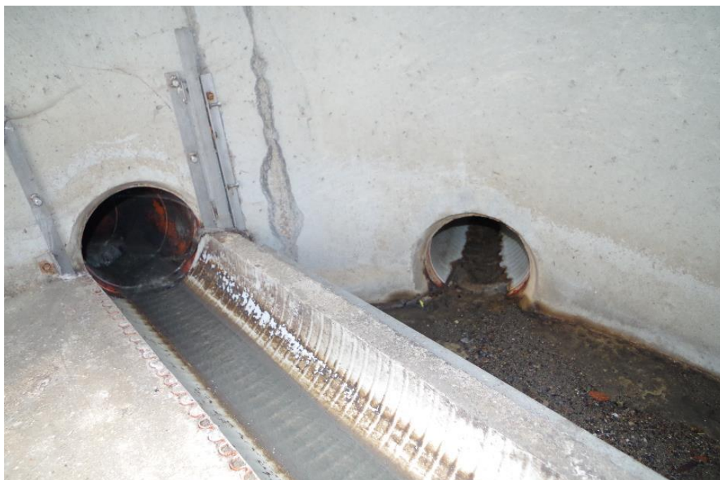
Obr. 4 Odlehčovací komora C-OK1 JIH - odtok
