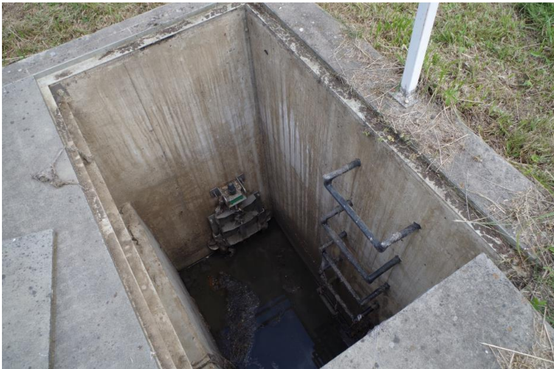
Obr. 11 Odlehčovací komora F-OK2 V – trubka DN 300 se šoupátkem regulující odtok
