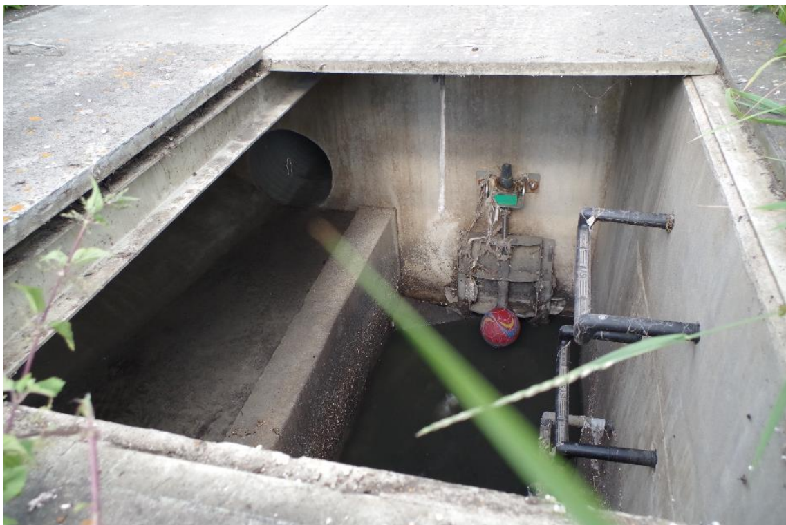
Obr. 14 Odlehčovací komora G-OK1 V – vlevo odlehčení DN 300, vpravo potrubí DN 300 se šoupátkem regulující odtok
