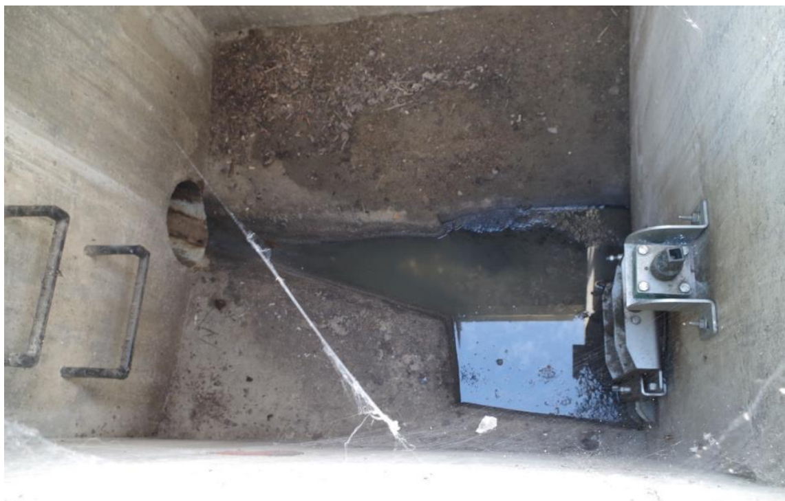
Obr. 9 Odlehčovací komora E-OK4 V – odlehčení DN 200
