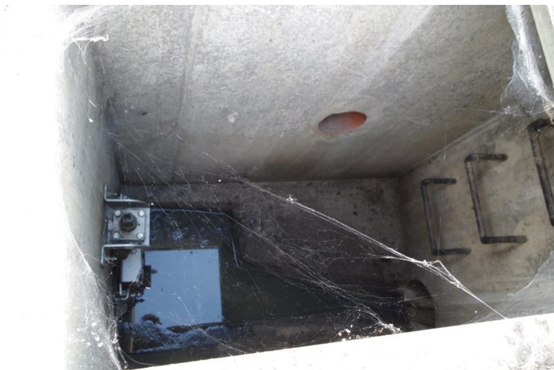
Obr. 9 Odlehčovací komora E-OK4 V – odlehčení DN 200
