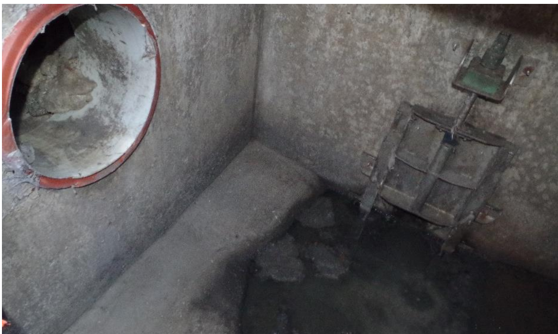
Obr. 7 Odlehčovací komora D-OK3 V – odlehčení vlevo DN 400, vpravo trubka DN 300 se šoupátkem regulujícím odtok
