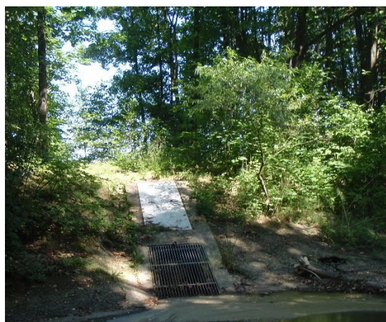
Obr. 2 Foto z pochůzky - skutečné provedení – vtokový objekt
