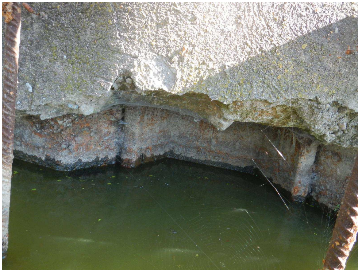
Obnažené ocelové štetovnice levého zavazovacího křídla
