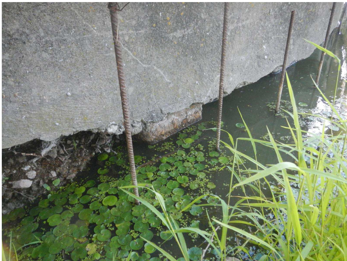
Obnažená pata konstrukce levého zavazovacího křídla
