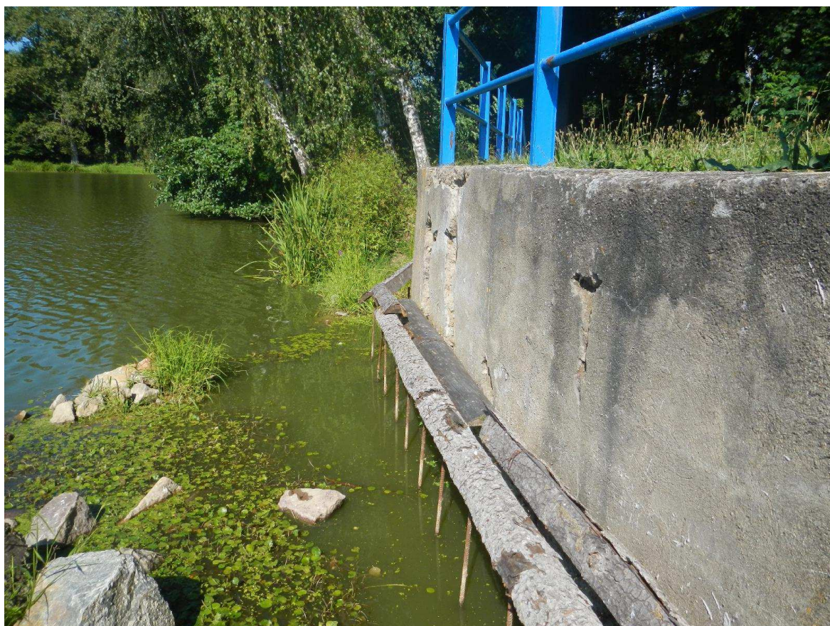
Ocelové roxory zabetonované v předzákladu konstrukce
