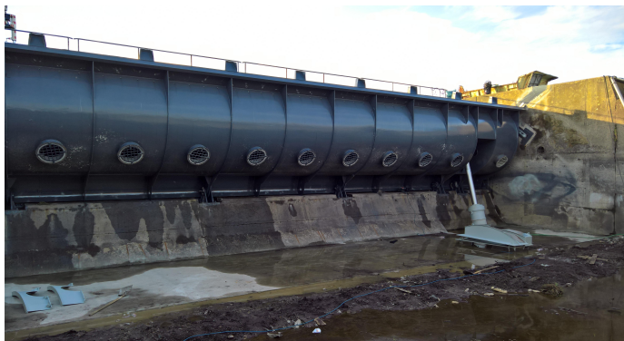
Foto č. 5 – Pohled na klapku při opravě – VD Modřany
