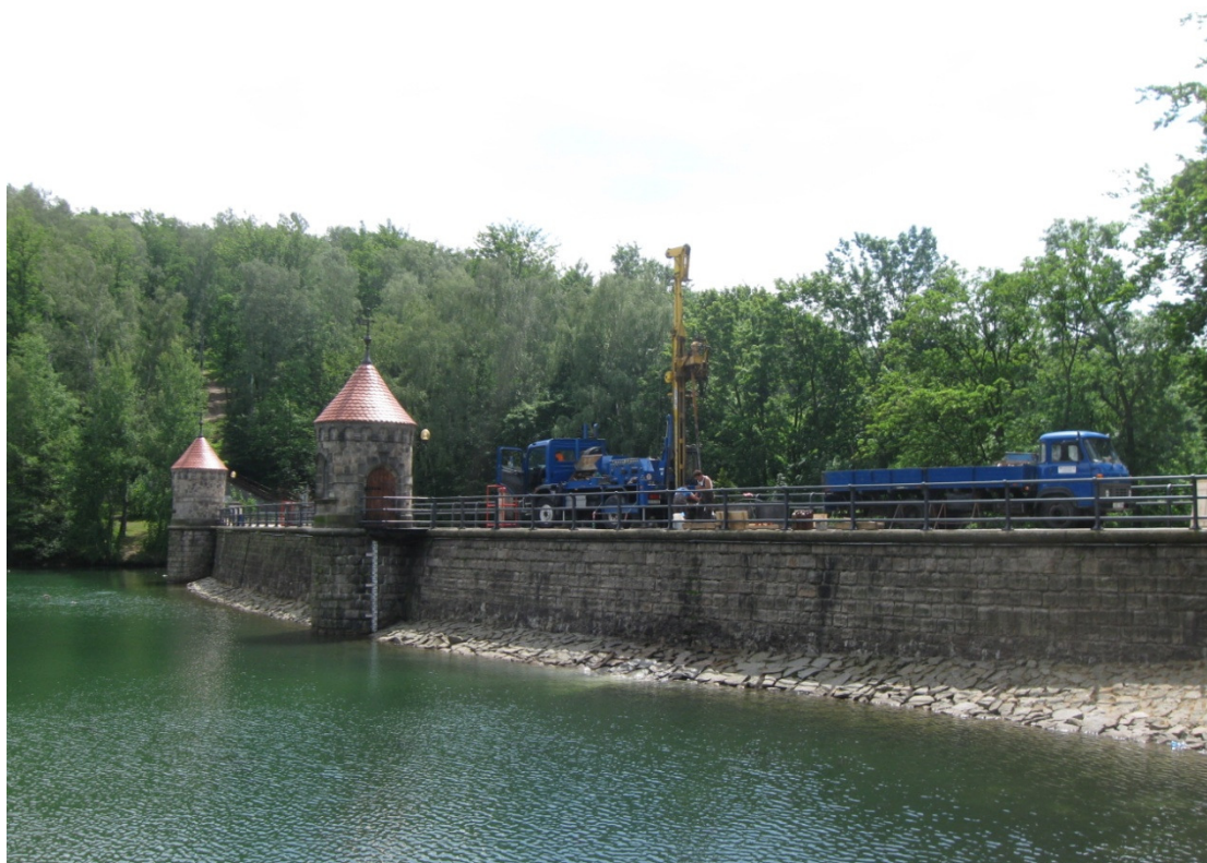
Obr. 4 Provádění vrtných prací na koruně hráze VD Harcov
