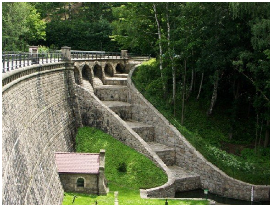
Obr. 1 Vodní dílo Harcov – pohled na levobřežné zavázání s bezpečnostním přelivem (zdroj www.pla.cz )
