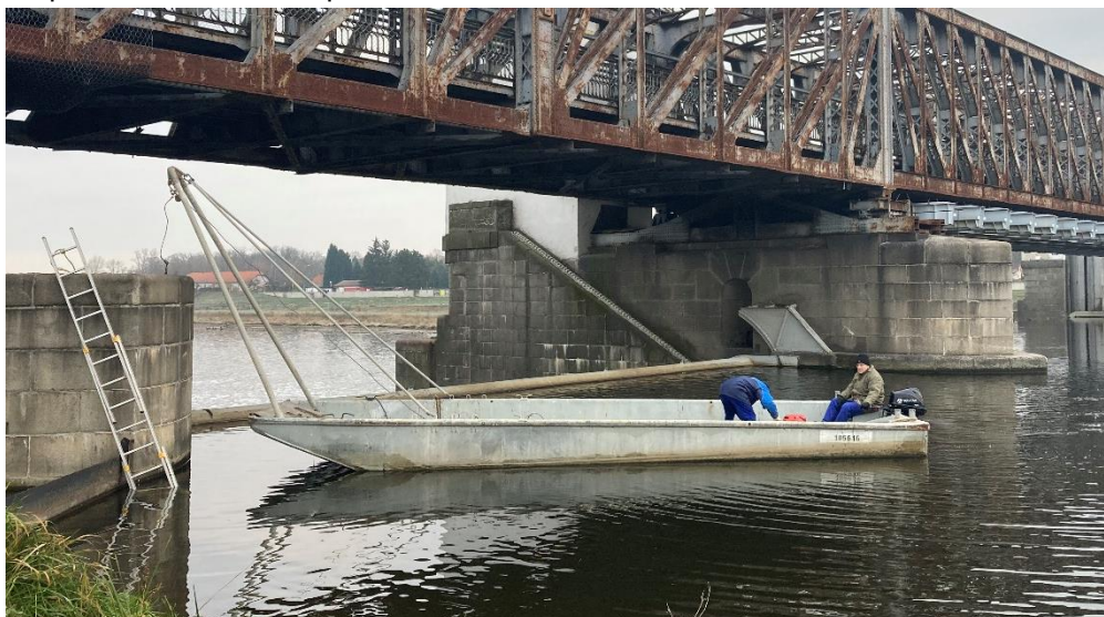
Přepravní ponton s jeřábovou kočkou
