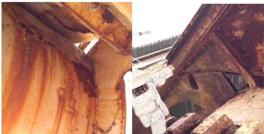
Poškození pláště a bočního hradícího štítu
