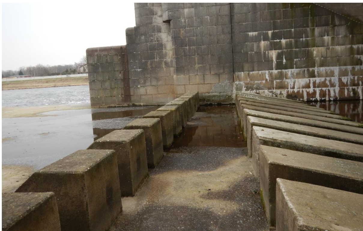
Betonové rozražeče ve vodohospodářském vývaru
