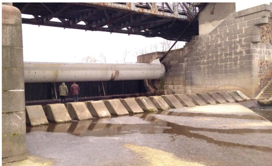
Betonové plato vývaru s rozřežci
