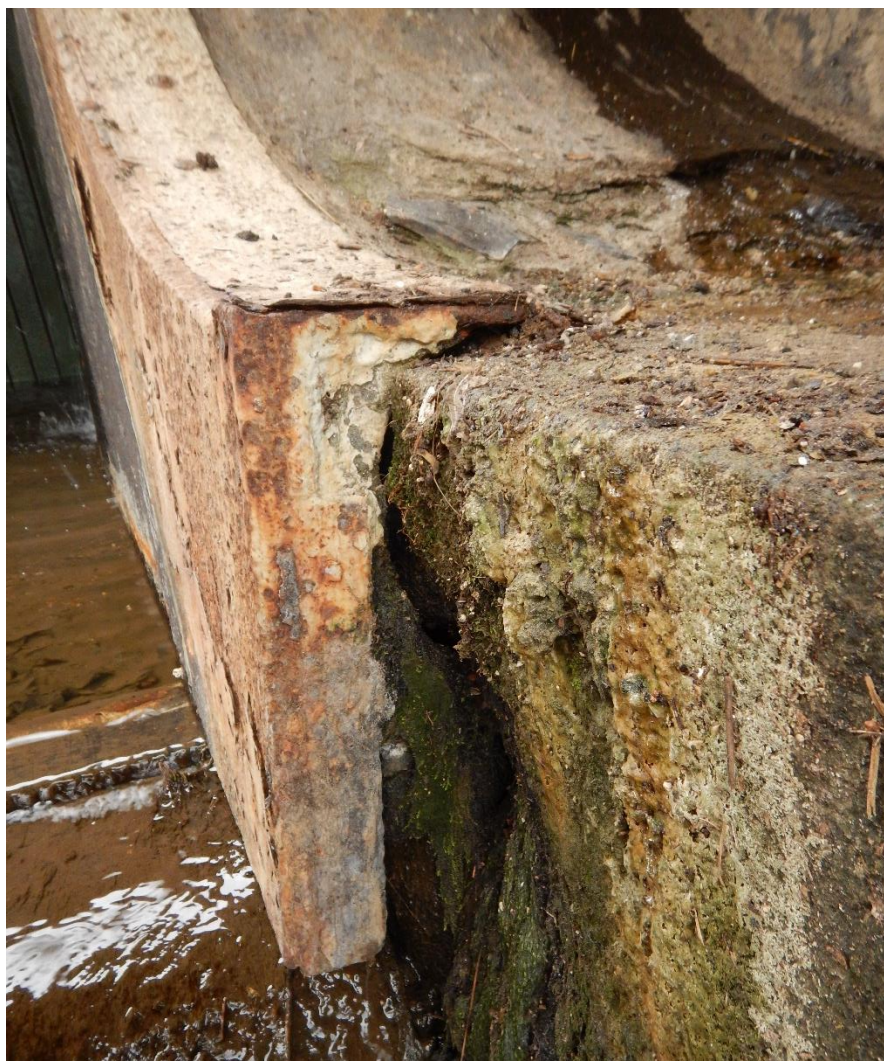
Kaverna opancérování dojezdu v pravém pilíři
