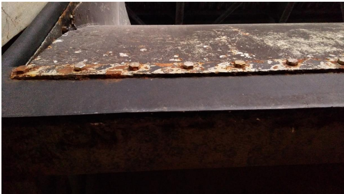
Přítlačná lišta a dosedací těsnění válcového uzávěru
