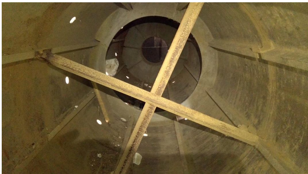
Ztužující kříž ve vnitřní části válce
