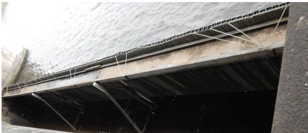
Provizorní hrazení prvního jezového pole
