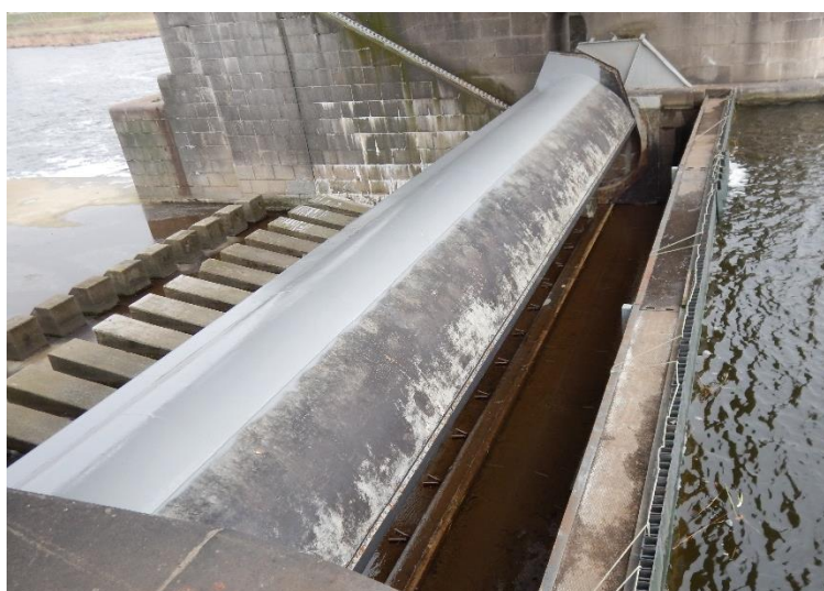
Válnový uzávěr po zahrazení a očištění
