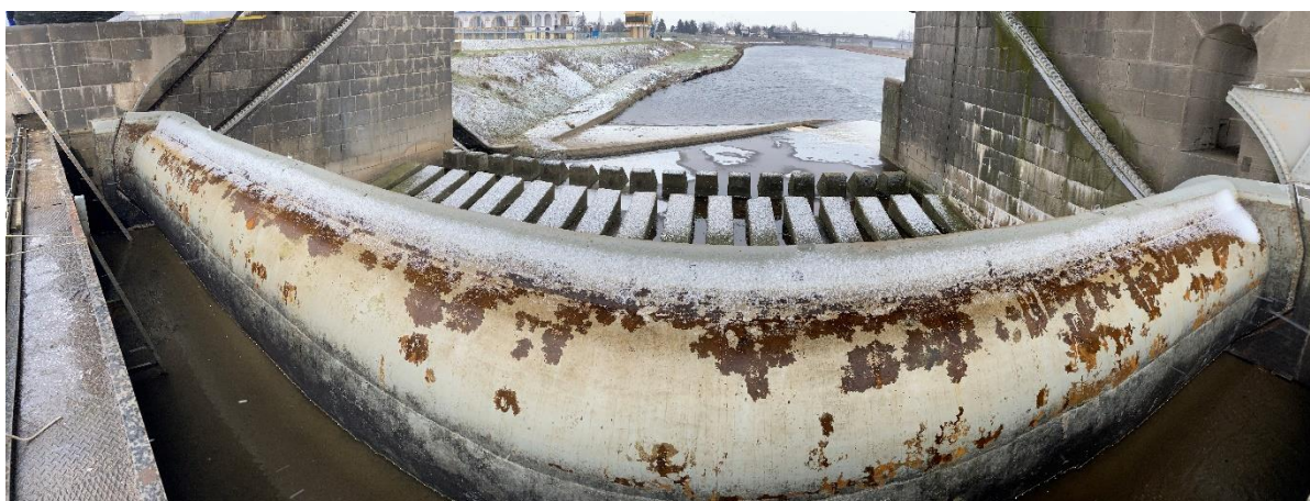
Válnový uzávěr po zahrazení a očištění
