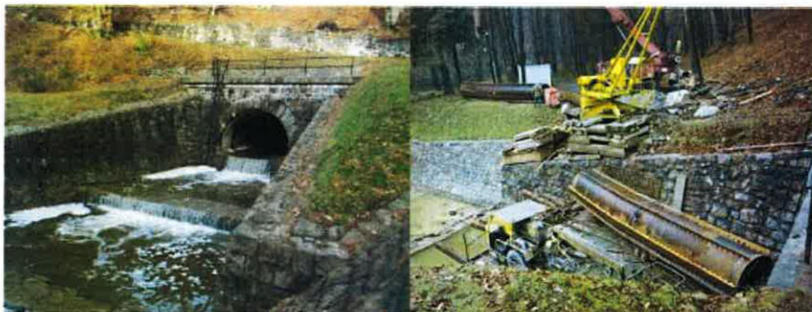
Výustní portál obtokové štoly
