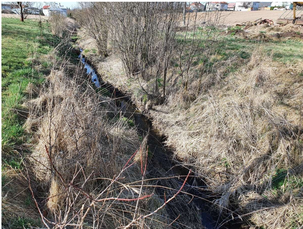
Obr. č.4 – Koryto potoka nad intravilánem obce – bude provedeno odstranění sedimentu, břehy budou opevněny rovnáninou z lomového kamene, odstranění náletových dřevin z průtočného profilu
