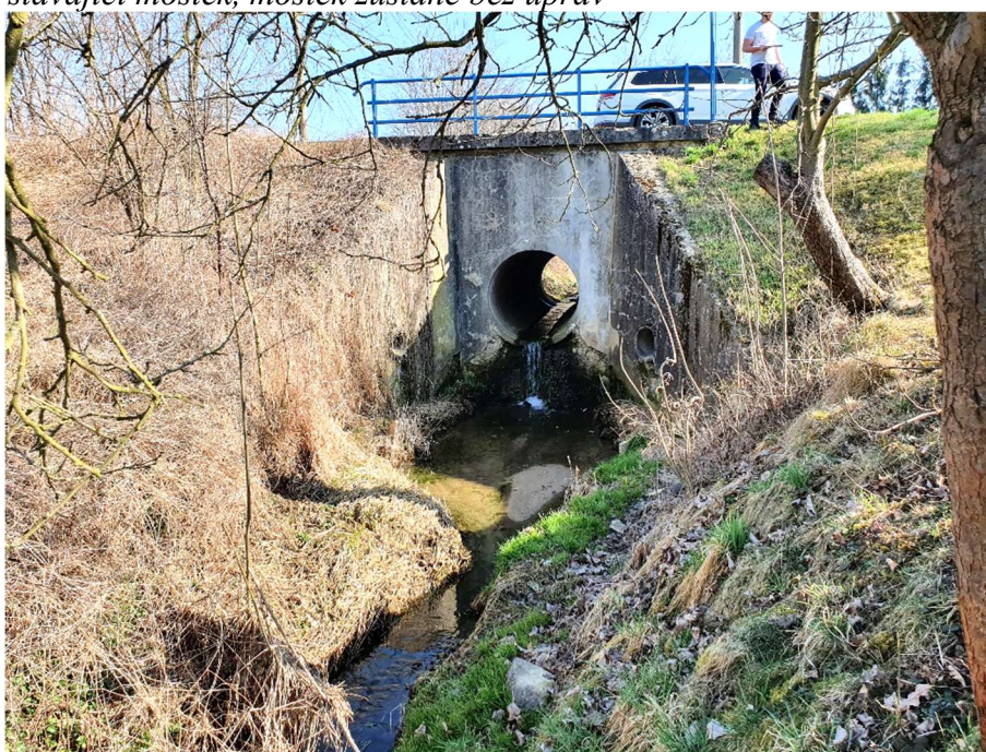
Obr. č.2 – Konec úseku – Oprava opevnění bude končit u mostku (p.č. 675/36), opevnění bude plynule navázáno ke stávajícímu mostku, mostek zůstane bez úprav
