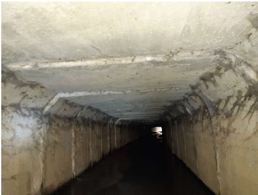
Obr. č.3 – V rámci projekčních prací byl proveden průzkum zaklenuté části potoka – zaklenutá část nejeví známky poškození, zůstane bez zásahu. V rámci stavby dojde pouze k odstranění sedimentu ze zaklenuté části
