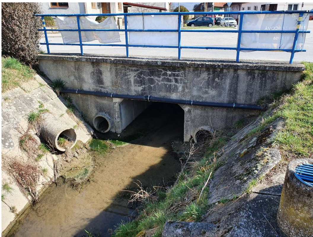
Obr. č.5 – Pohled na výtok ze zaklenuté části potoka – břehy potoka jsou za výtokem opevněny betonovými dlaždicemi – dlaždice budou odstraněny, nahrazení kamennou rovnaninou, opevnění bude plynule navázáno ke stávajícímu mostku
