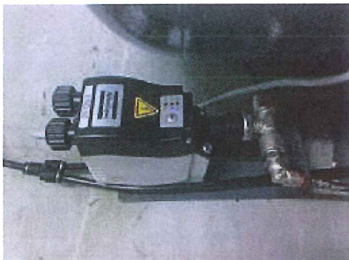
Obr. 18 Automatický odkalovač EWD 50 a odlučovače nečistot DD 32 a PD32.
