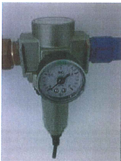
Obr. 20 Redukční ventil na potrubí tl. vzduchu
