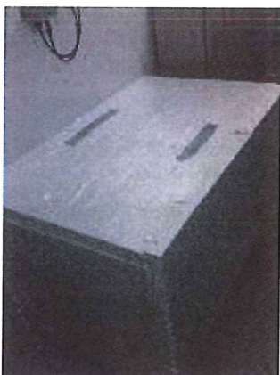
Obr. 31 Zateplení objektu pro sání vzduchu do kontejneru. Pro letní provoz se oddělá pouze přední polyst. deska
