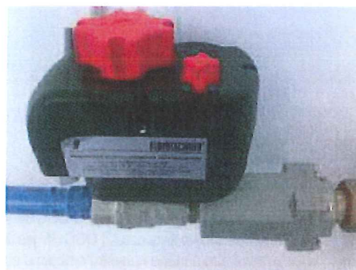
Obr. 21 zpětná klapka a elektromagnetická klapka
