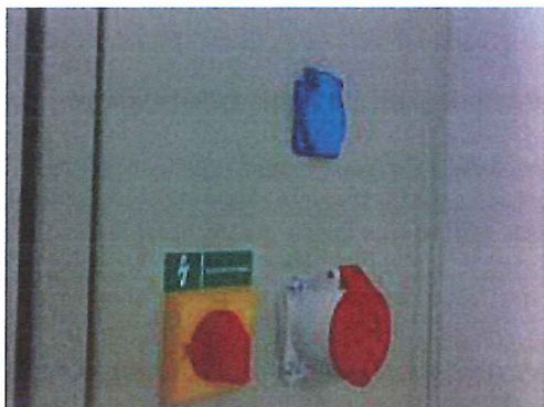
Obr. 28 Hlavní vypínač a zásuvky na 220 V a 380 V/16 A-6h na boku rozvaděče.
