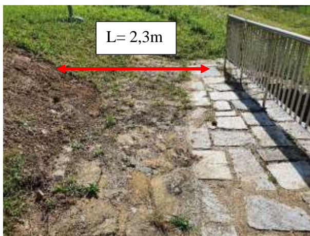
Obr. 2 Označení rozsahu délky zatékání nad štolou
