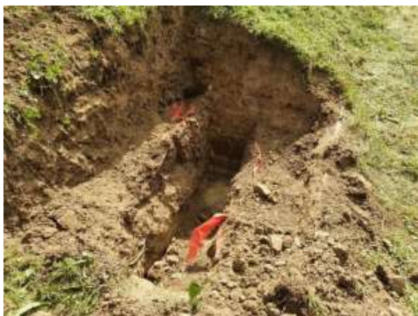
Obr. 3 Výkopová sonda nad štolou – patrné kabely osvětlení
