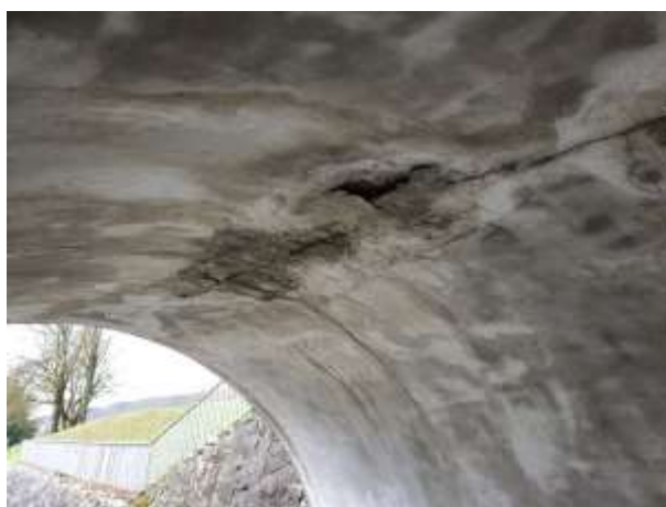
Obr. 1 Odpadávání betonu a zatékání do stropu odpadní štol
