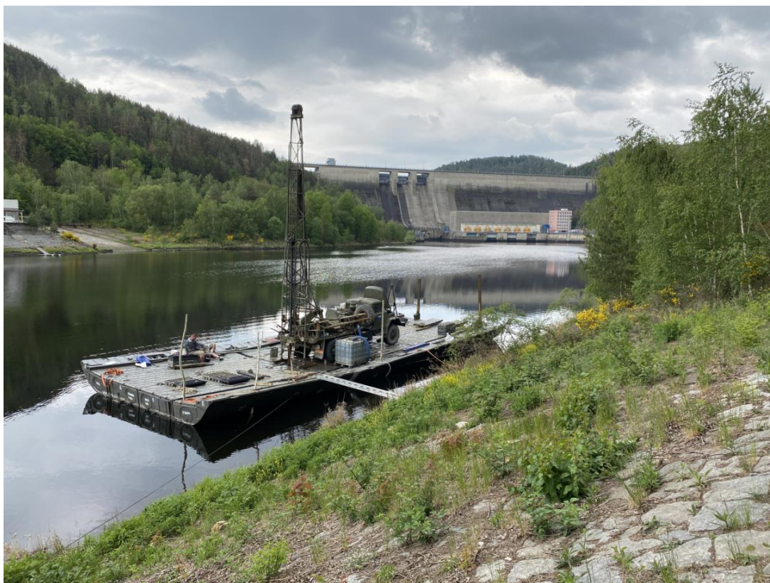
Obr. 3.4-1: Provádění vrtů J1, J4, J5, J8 a J10 z pontonového soulodí kolovou soupravou Zil UPR
