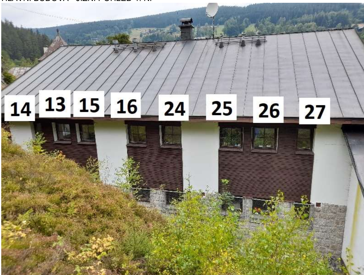
GARÁŽE, DÍLNY - SEVERNÍ POHLED
