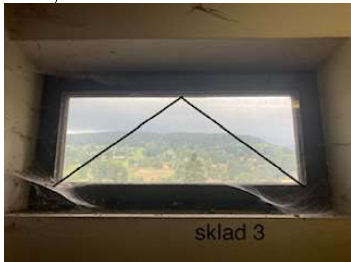
OBR. 32) SKLAD 3 - SEVERNÍ POHLED
