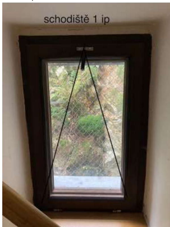
OBR. 11) SCHODIŠTĚ 1 IP - JIŽNÍ POHLED PŘÍZEMÍ
