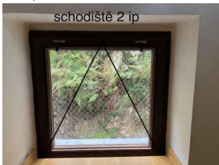
OBR. 12) SCHODIŠTĚ 2 IP - JIŽNÍ POHLED PŘÍZEMÍ
