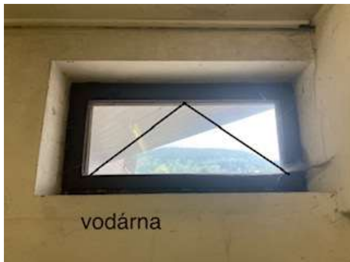
OBR. 31) VODÁRNA - SEVERNÍ POHLED
