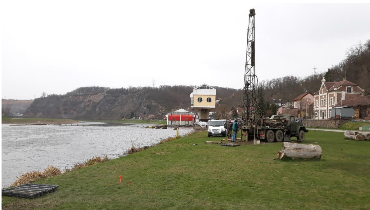
Foto 21 Hloubení pozorovacího vrtu PV-1
