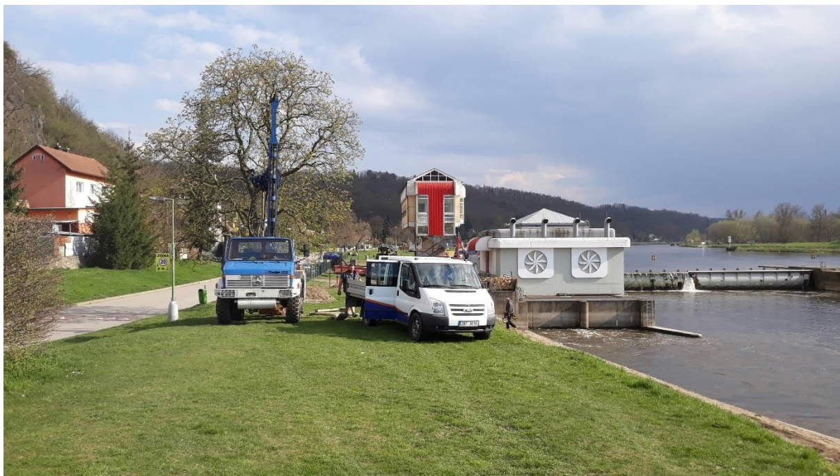
Foto 25 Hloubení pozorovacího vrtu PV-3
