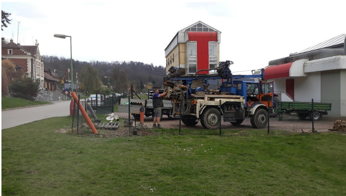
Foto 19 Hloubení hydrovrtu KHV-1
