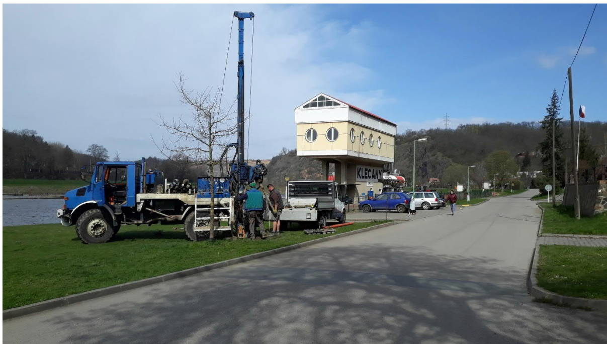
Foto 23 Hloubení pozorovacího vrtu PV-2
