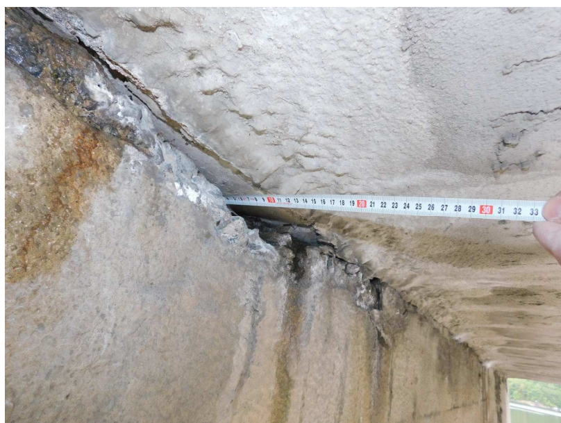
Obr. 2.48 – pole 13, kaverna v úložné spáře pilíře P14
