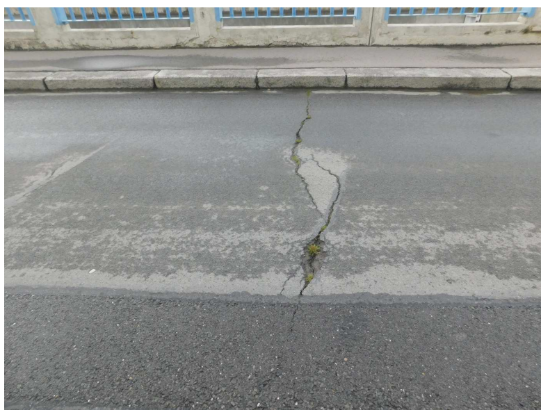
Obr. 2.115 – výtluk ve vozovce, uchycená vegetace
