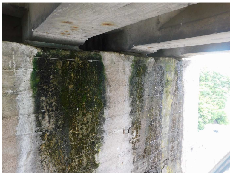
Obr. 2.66 – pole 8, silné průsaky na úložném prahu pilíře P8
