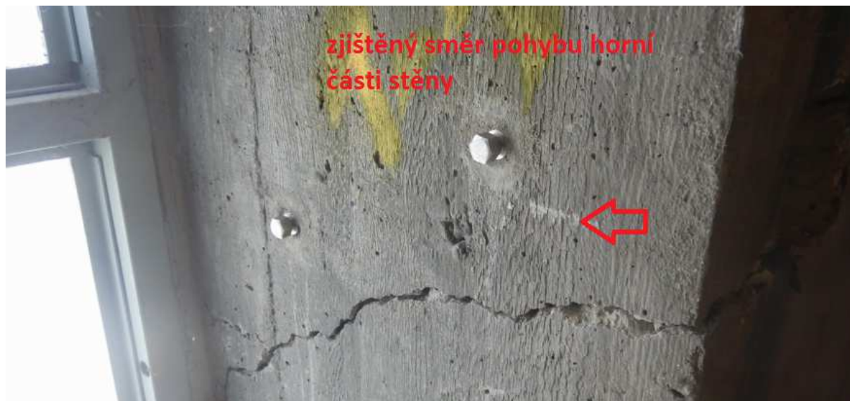
Obr. 2.71 – charakter usmyknutí levé stěny směrem k vzdušnému líci
