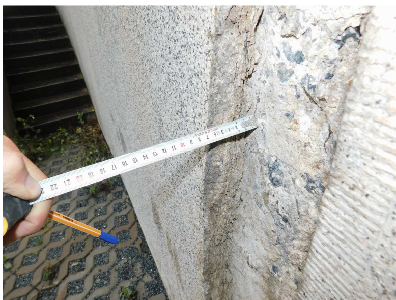
Obr. 2.16 – detail odpadlé omítky na líci pravého křídla opěry OP1 v místě dilatační spáry, omítka opadlá v celé šířce tj. 60 mm
