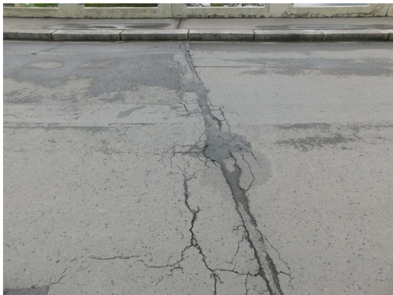
Obr. 2.117 – trhlinami poškozené těsnění dilatační spáry ve vozovce
