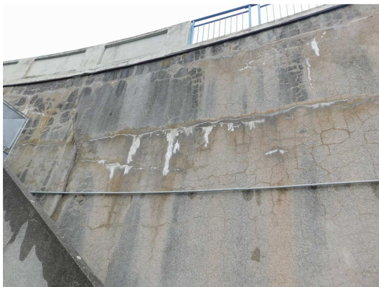
Obr. 2.15 – opěra OP1, pravé křídlo, vodorovné trhliny s průsaky a výluhy
