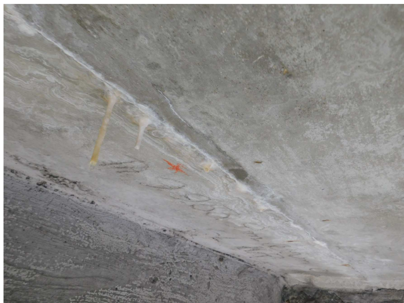
Obr. 2.47 – pole 13, detail průsaku ve spáře mezi nosníky J-115
