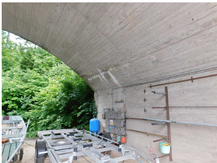
Obr. 2.85 – vodorovná trhlina s výluhem v patě klenby ve vetknutí do opěry OP18
