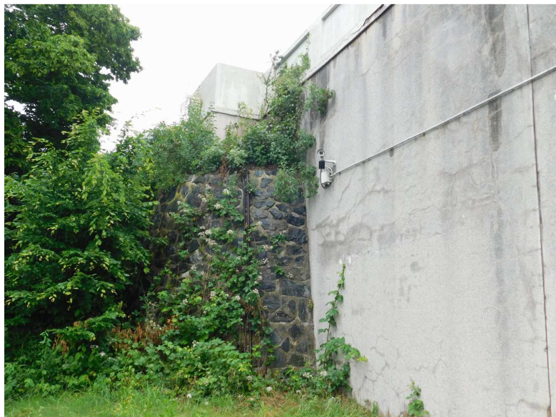
Obr. 2.7 – navazující kamenné křídlo na pravé straně opěry OP1, křídlo je zarostlé vegetací, plošně uchycena vegetace
