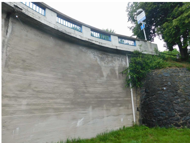
Obr. 2.5 – křídlo na levé straně opěry OP1, na konci křídla v horní části trhliny se silnějšími průsaky a výluhy pojiva, plošný rozpad horní římsy
