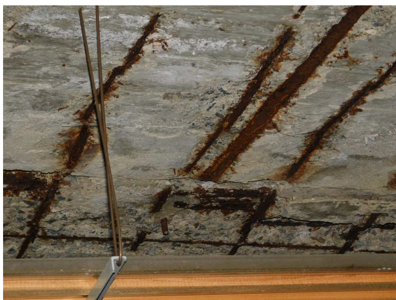
Obr. 2.30 – pole 16, velmi silná koroze betonářské výztuže v místě příčné dilatační spáry, detail
