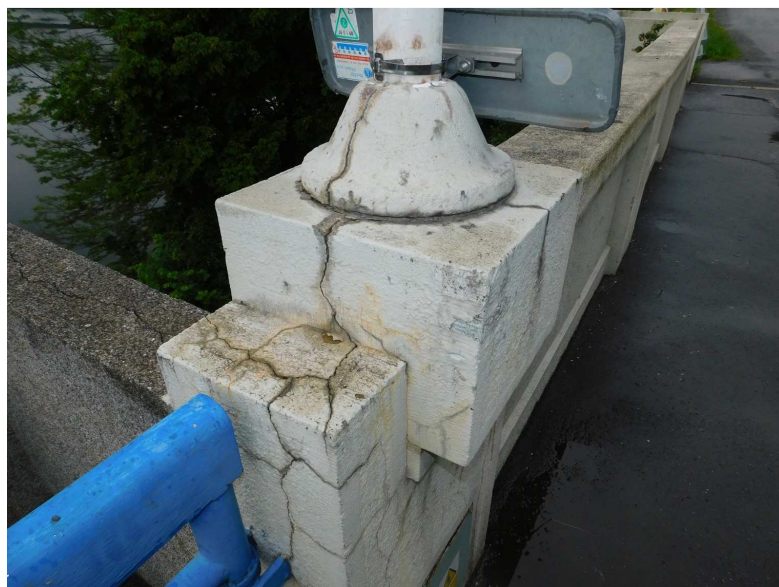
Obr. 2.119 – rozpad betonového zábradlí nad opěrou OP1 vpravo
