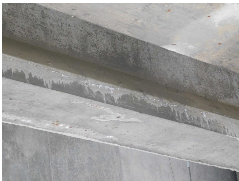
Obr. 2.77 – pole 10, výluhy pojiva v trhlíně kopírující trajektorii předpínací výztuže
