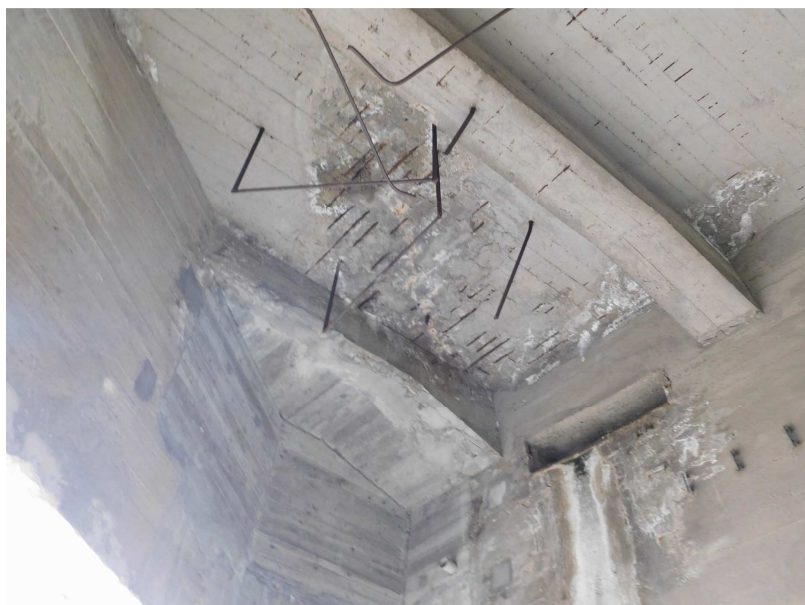
Obr. 2.12 – silné zatékání s výluhy, koroze betonářské výztuže na spodním líci nosné konstrukce, pravá strana u trámů T2-T3
