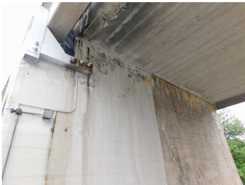
Obr. 2.36 – pole 3, pohled na pilíř, silné průsaky na úložný práh, výluhy pojiva, odpadá krycí vrstva, koroze výztuže
