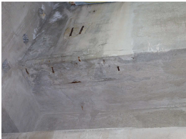
Obr. 2.101 – pole 10B, stopy po průsacích, koroze betonářské výztuže
