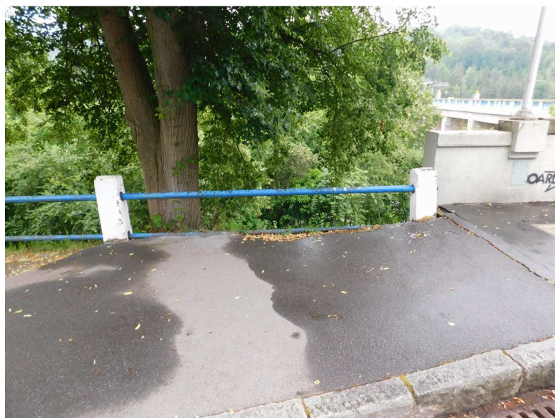
Obr. 2.120 – navazující zábradlí na levé straně nad opěrou OP1 je výškově nevhodně napojeno
