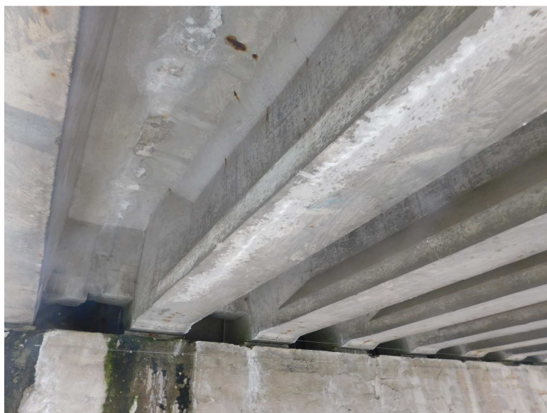
Obr. 2.65 – pole 7, trhlina s výluhem kopírující trajektorii předpínací výztuže
