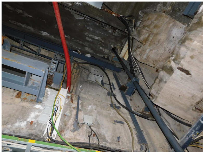
Obr. 2.108 – pole 11B, spodní líc stropu strojovny v pravé části, prokreslená korodující výztuž, silné průsaky a degradace v místě otvoru ve stropu strojovny
