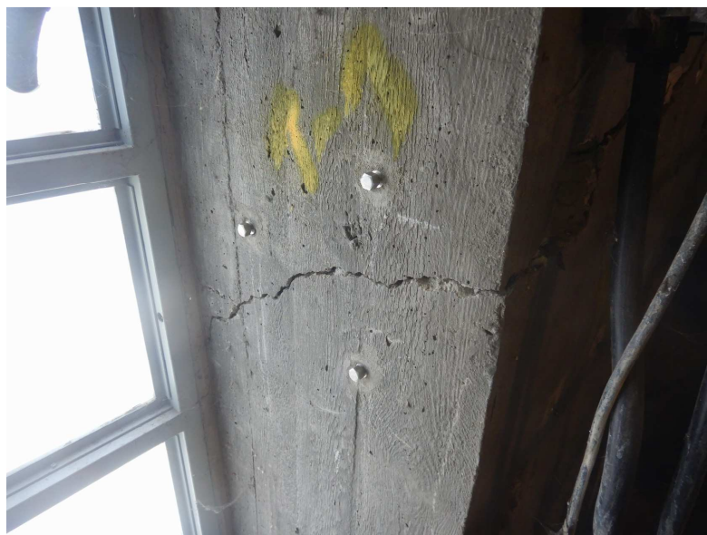
Obr. 2.105 – pole 11B, šikmá trhlina v levé stěně
