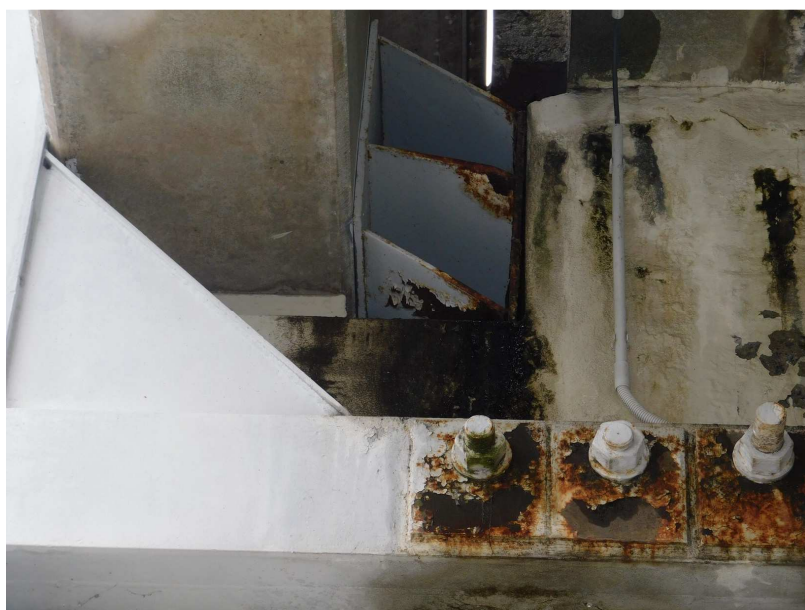
Obr. 2.37 – pole 3, koroze ocelového přípravku zajišťujícího stabilitu jeřábové dráhy na pilíři P3
