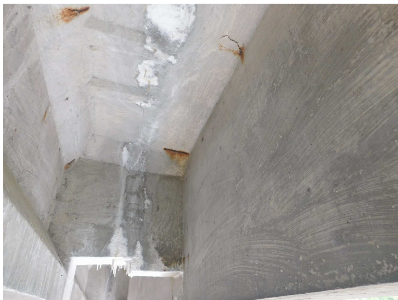
Obr. 2.67 – pole 8, průsaky se silnými výluhy ve spáře mezi nosníky
