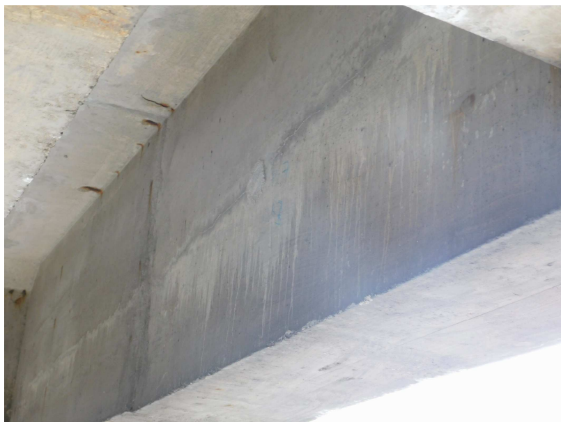
Obr. 2.71 – pole 10, trhliny kopírující předpínací výztuž na boku krajního levého trámu
