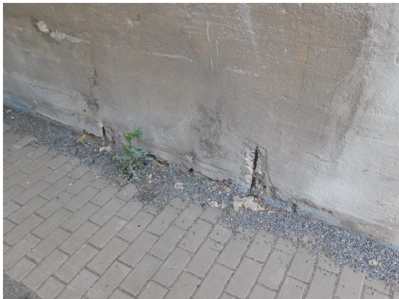
Obr. 2.11 – opěra OP1, pata, odstřelená krycí vrstva, silná koroze betonářské výztuže
