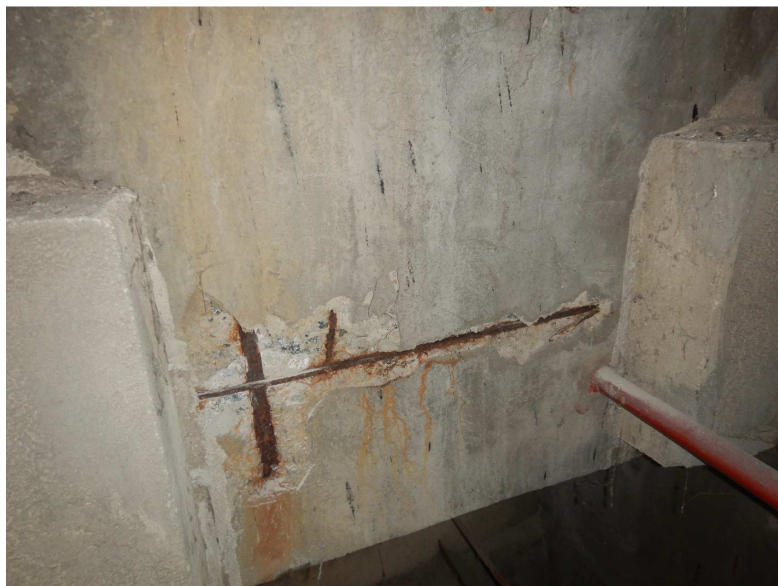
Obr. 2.103 – pole 11B, separace krycí vrstvy, koroze obnažené betonářské výztuže
