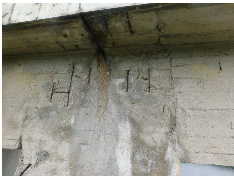
Obr. 2.42 – pole 11, levý bok, silné průsaky nad dilatační sparou pilíře P12, degradace betonu
