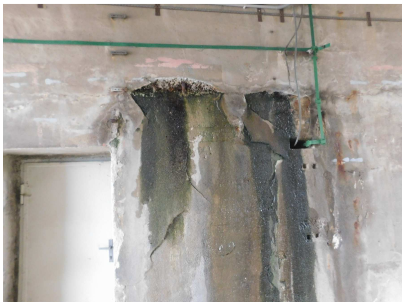
Obr. 2.10 – v navazujícím křídle u opěry OP1 jsou stopy po průsacích v pracovních sparách s výluhy pojiva
