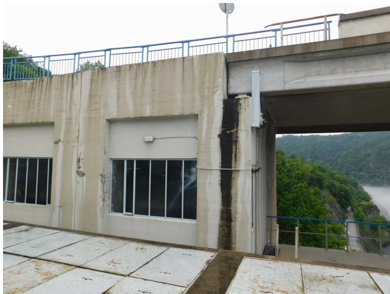
Obr. 2.28 – pole 2, zatékání na pravém vnějším boku rámových konstrukcí
