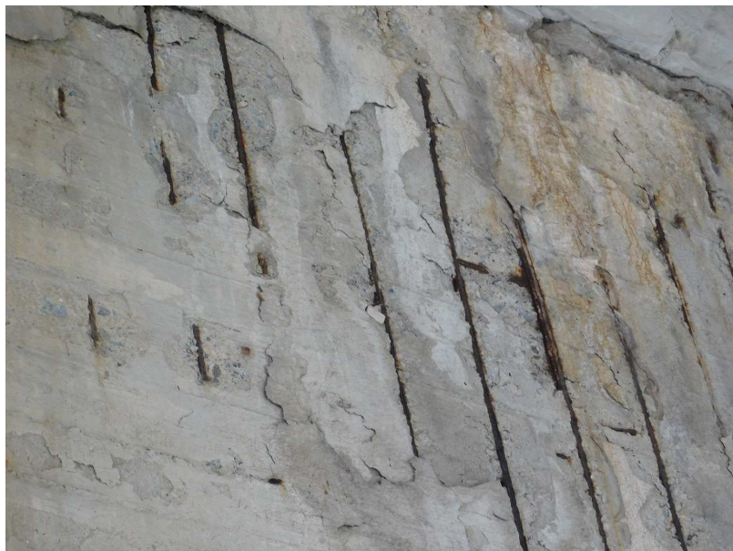
Obr. 2.59 – detail degradace úložného prahu a koroze svislé betonářské výztuže
