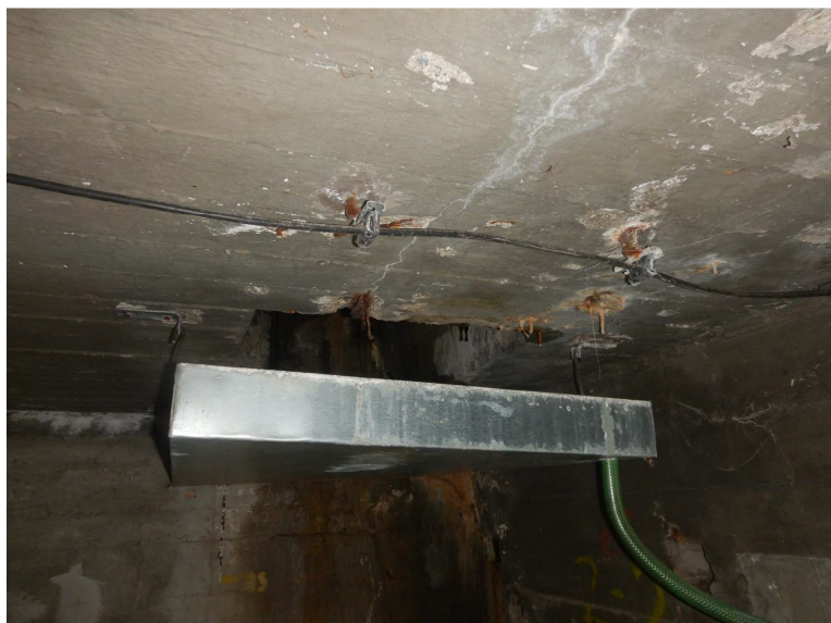
Obr. 2.94 – pole 7B, silné zatékání, průsaky a stopy po korozi betonářské výztuže u průchodu u stropu strojovny
