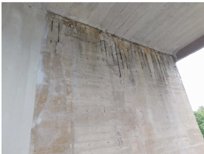
Obr. 2.58 – plošná separace krycí vrstvy betonu úložného prahu pilíře P3
