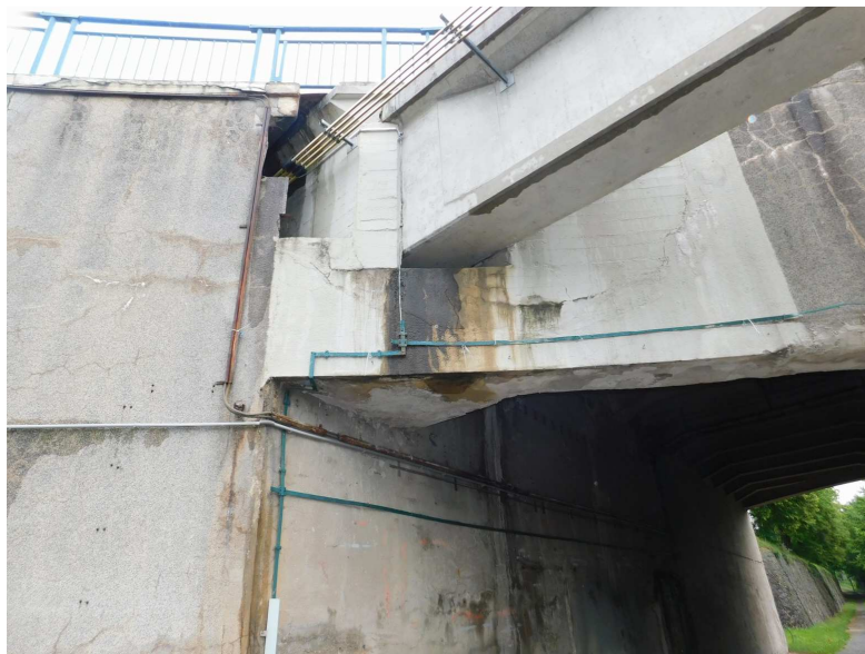
Obr. 2.14 – pravý bok nosné konstrukce, trám T1, silný průsak v místě průchodu nosníku jeřábové dráhy
