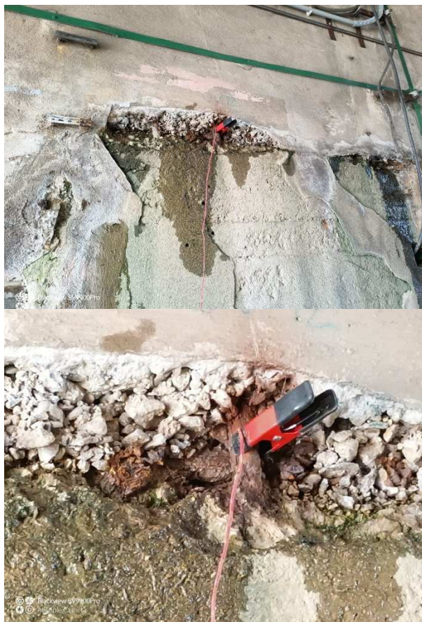
Korozně napadená výztuž v průjezdu hráze (korozní stav je potvrzen měřeným potenciálem)
