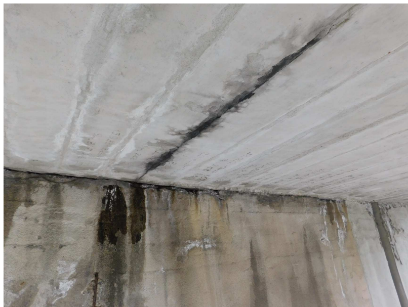
Obr. 2.46 – pole 13, průsaky ve spáře mezi nosníky J-115, průsaky na úložný práh
