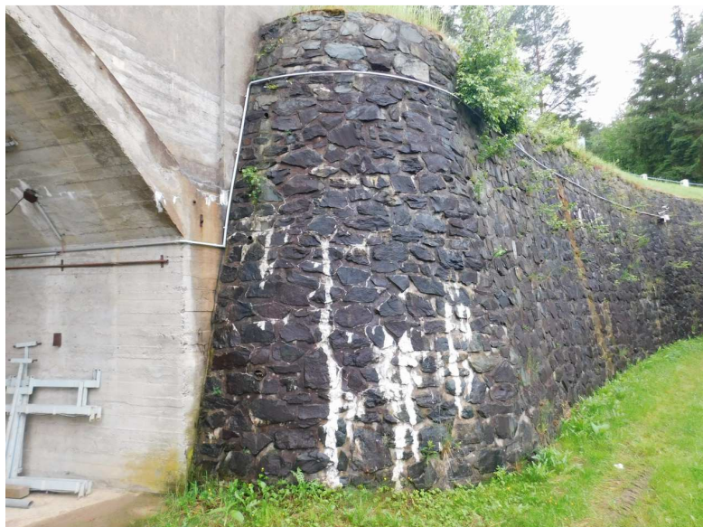
Obr. 2.89 – navazující kamenné křídlo u opěry OP18 na pravé straně, výluhy pojiva, ve sparách uchycena vegetace
