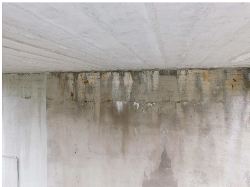
Obr. 2.55 – silné průsaky s výluhy na lici úložného prahu
