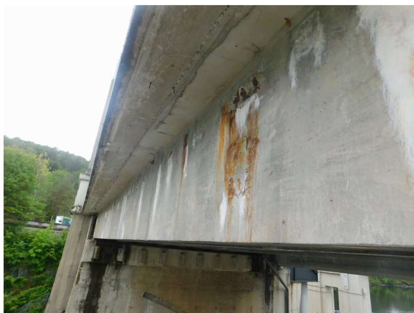
Obr. 2.69 – pole 10, výluhy na levém boku nosné konstrukce
