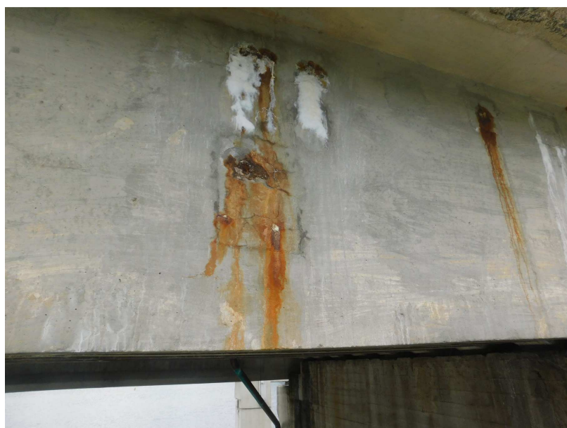
Obr. 2.68 – pole 8, výluhy a koroze v místě kotvy příčného předpětí
