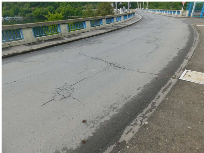
Obr. 2.116 – trhliny ve vozovce nad polem 17
