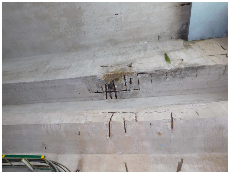
Obr. 2.96 – pole 8B, průsaky, separace krycí vrstvy, koroze obnažené betonářské výztuže
