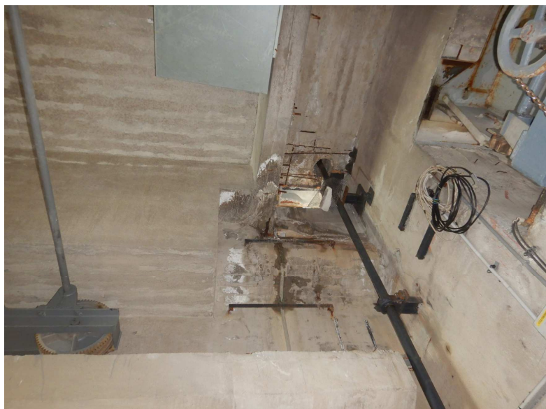
Obr. 2.100 – pole 10B, spodní líc stropu strojovny v pravé části, prokreslená korodující výztuž, silné průsaky a degradace v místě otvoru ve stropu strojovny
