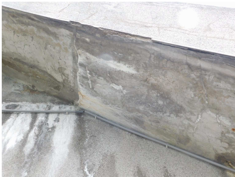
Obr. 2.8 – detail poškozeného schodiště u pravého křídla opěry OP1, trhlina se silnými průsaky, beton schodiště se rozpadá
