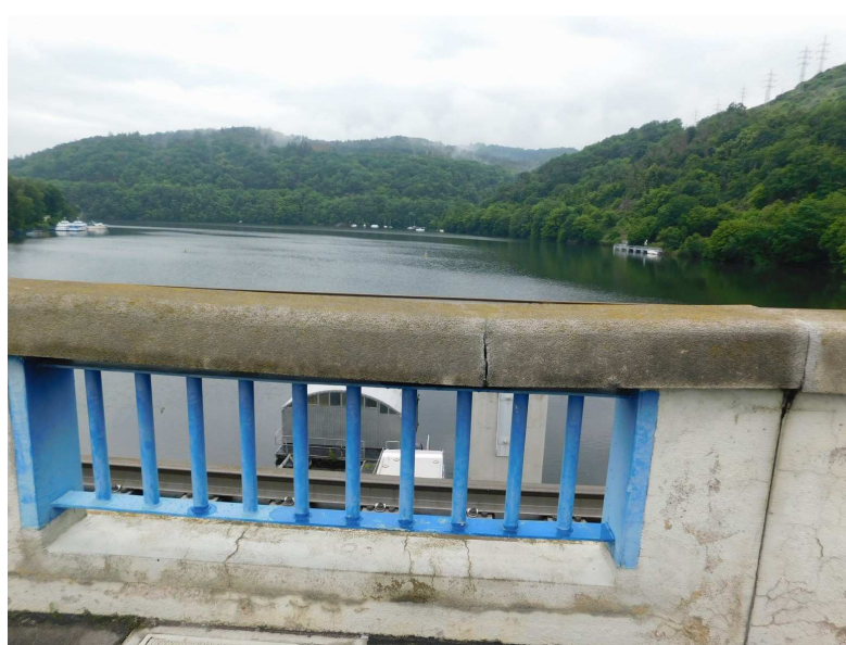
Obr. 2.121 – rozlomené madlo zábradlí na pravé straně
