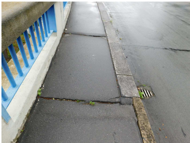
Obr. 2.114 – otevřené spáry v živičném krytu chodníku
