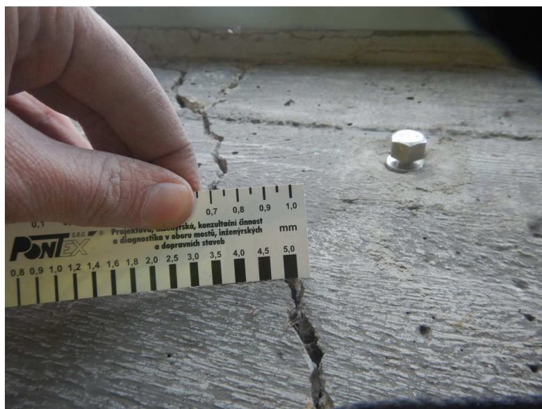
Obr. 2.106 – pole 11B, detail trhliny v levé stěně šířky 5 mm
