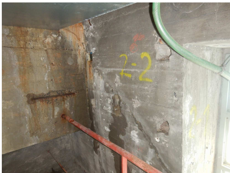
Obr. 2.93 – pole 7B, šikmá trhлина v levé stěně
