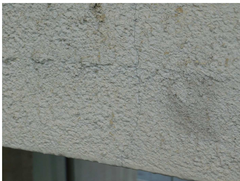
Obr. 2.54 – typická závada, svislá trhlina v plentovací zídce
