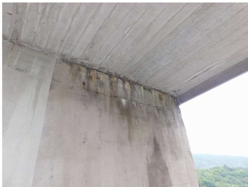
Obr. 2.45 – pole 13, průsaky v úložné spáře pilíře, degradace betonu
