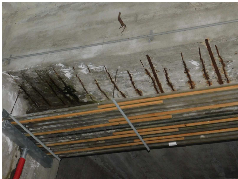
Obr. 2.29 – pole 16, velmi silná koroze betonářské výztuže v místě příčné dilatační spáry
