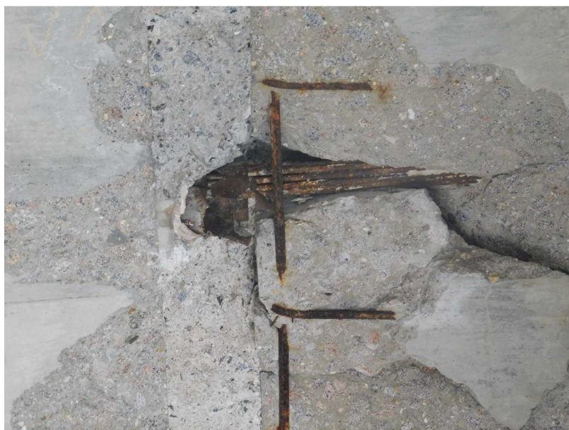
Obr. 2.72 – pole 10, koroze příčného předpětí nosné konstrukce, plošně odpadá krycí vrstva
