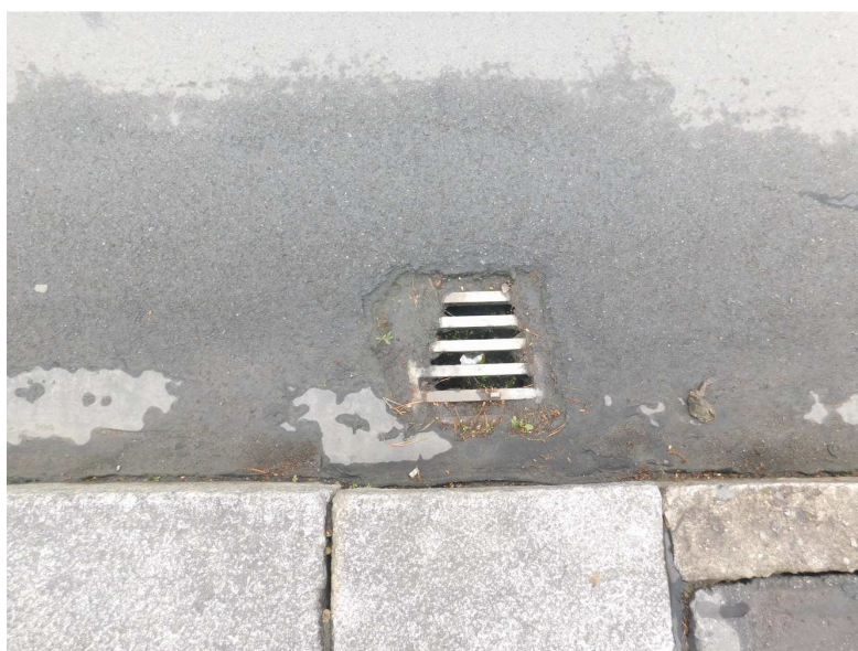
Obr. 2.118 – částečně zanesený mostní odvodňovač
