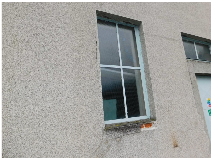
Obr. 2.51 – pole 15, degradace u okenního otvoru, pravá strana
