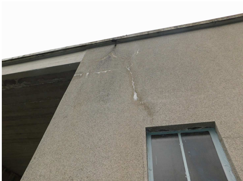
Obr. 2.52 – pole 15, trhliny s výluhy na líci omítky na boku rámového pole
