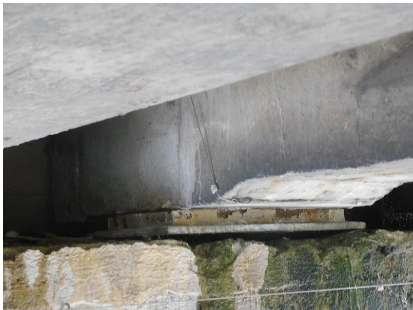
Obr. 2.73 – pole 10, koroze ocelových ložisek
