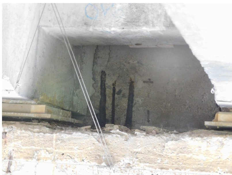
Obr. 2.78 – pole 10, degradace betonů úložného prahu, silná koroze výztuže
