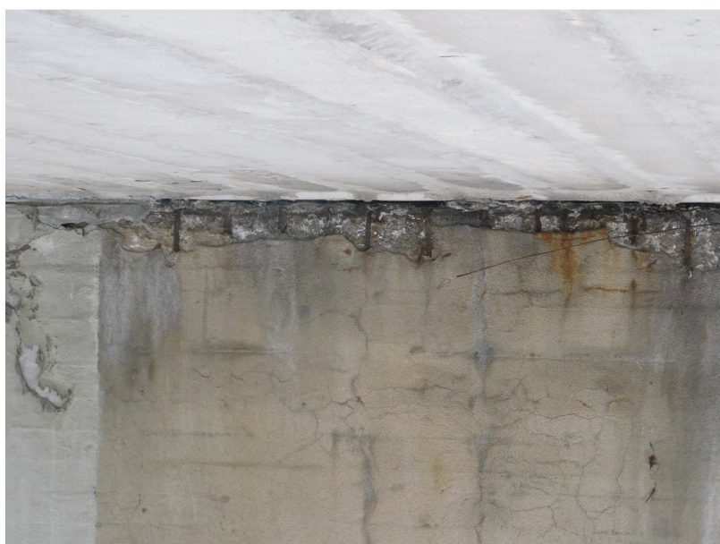
Obr. 2.40 – pole 11, odpadlá omítka na úložném prahu, odpadlá krycí vrstva, koroze obnažené betonářské výztuže
