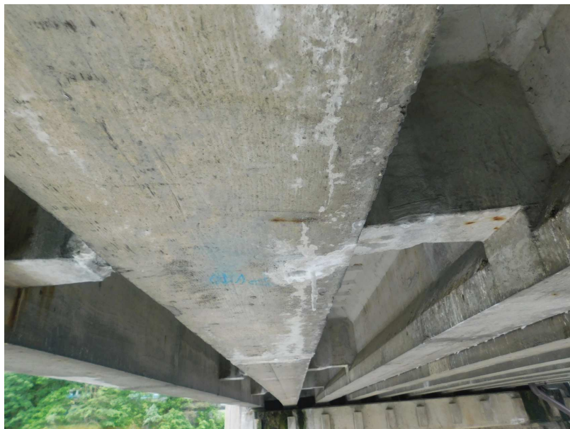
Obr. 2.79 – pole 9, výluhy pojiva v trhlině kopírující trajektorii předpínací výztuže
