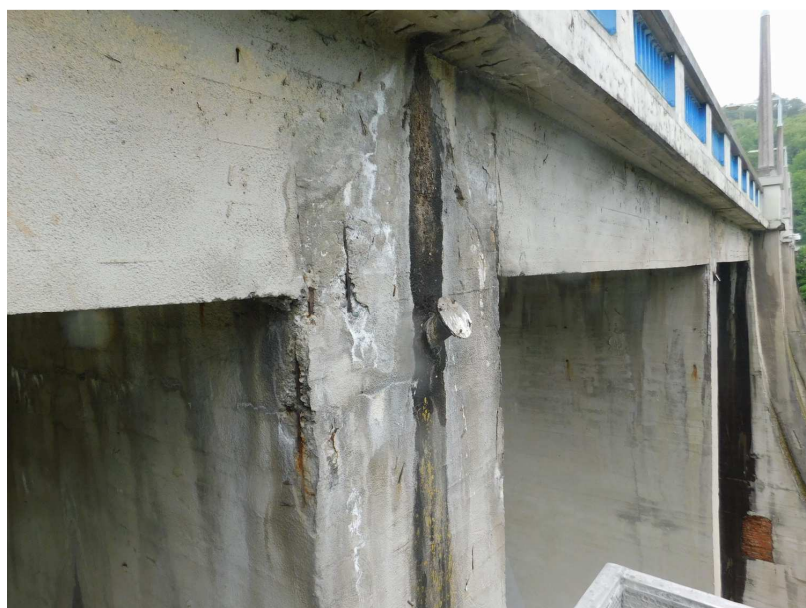
Obr. 2.43 – pole 12, levý bok, silné průsaky nad dilatační sparou pilíře P13, degradace betonu
