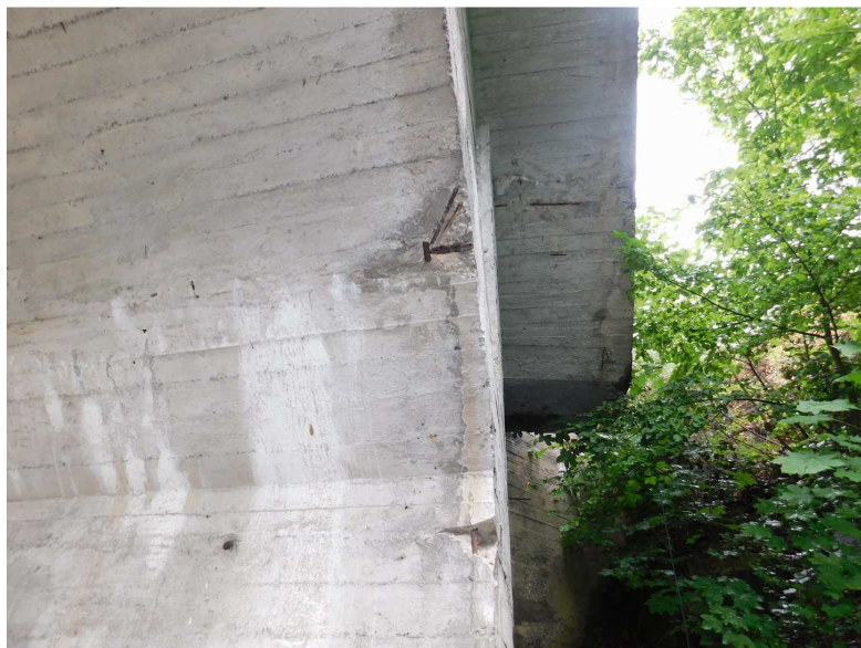
Obr. 2.87 – degradace betonu v místě průsaku s výluhy na levé straně v blízkosti vetknutí klenby do opěry OP17, odpadá krycí vrstva, koroze betonářské výztuže
