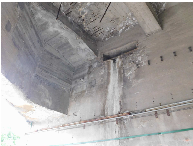
Obr. 2.13 – silné zatékání otvorem v opěře OP1 na pravé straně
