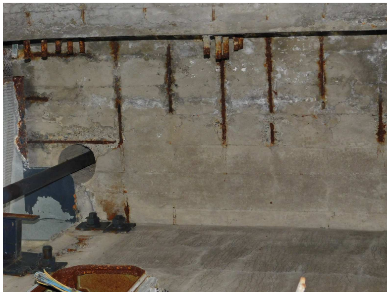
Obr. 2.99 – pole 9B, spodní líc stropu strojovny v pravé části, prokreslená korodující výztuž
