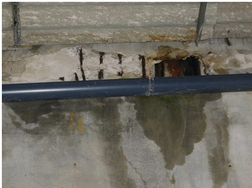
Obr. 2.50 – pole 15, degradace betonu úložného prahu pilíře P16
