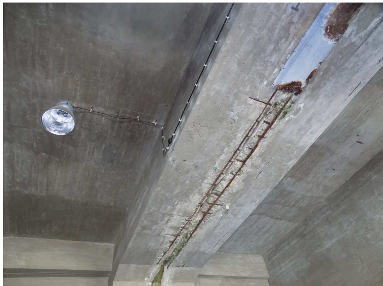
Obr. 2.26 – pole 2, dilatační spára mezi 5. příčným trámem (zdvojeným), v dilatační spáře stopy po silném zatékání, separace krycí vrstvy, silná koroze betonářské výztuže
