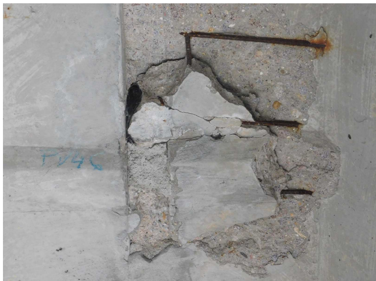
Obr. 2.64 – pole 7, detail separace krycí vrstvy, koroze betonářské výztuže spodního líc horní desky
