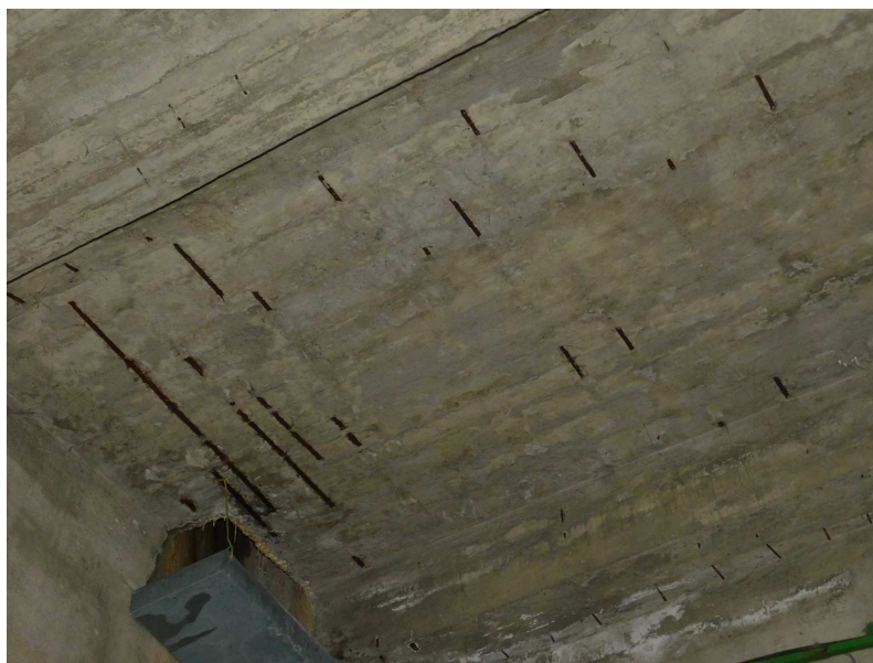
Obr. 2.31 – pole 16, prokreslená korodující výztuž na spodním líci horní desky
