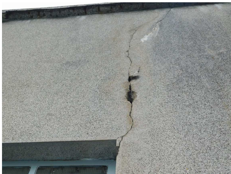
Obr. 2.53 – pole 15, svislá trhlina šířky 5 mm v omítce nad okenním otvorem na boku rámového pole
