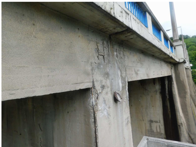
Obr. 2.57 – detail levého boku pilíře P12, degradace betonu, koroze betonářské výztuže
