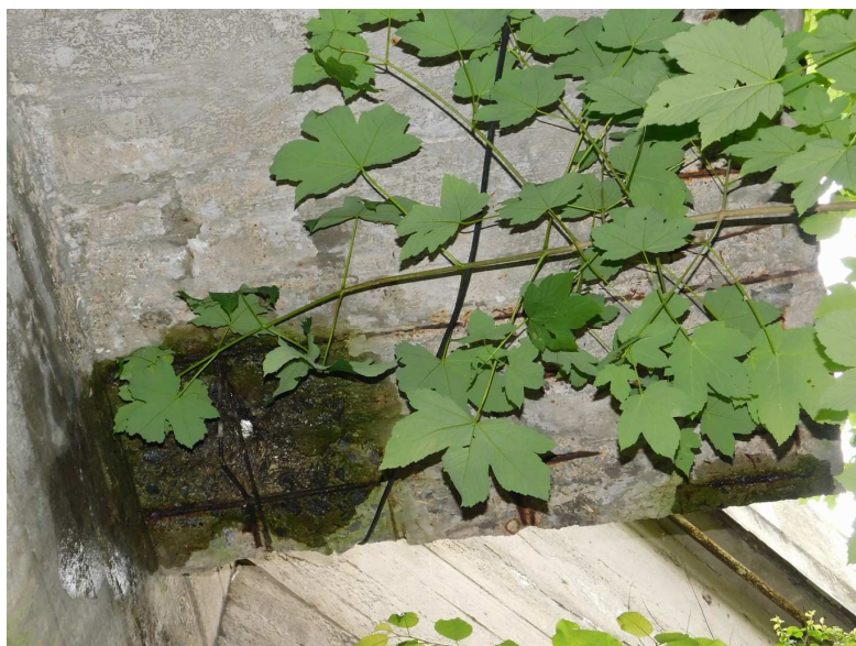
Obr. 2.88 – spodní líc schodiště na levé straně, degradace betonu, koroze výztuže
