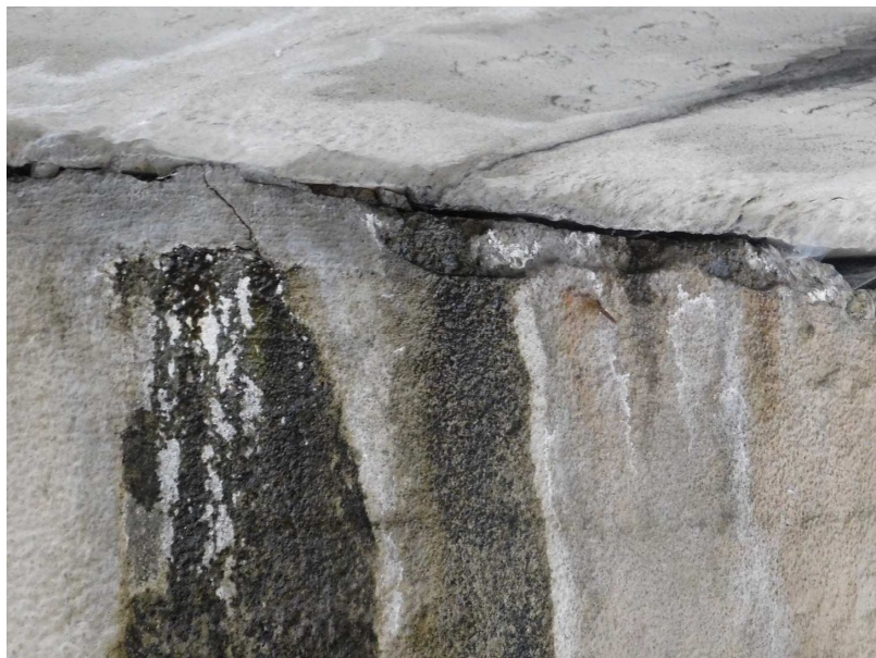
Obr. 2.56 – detail hrany úložného prahu
