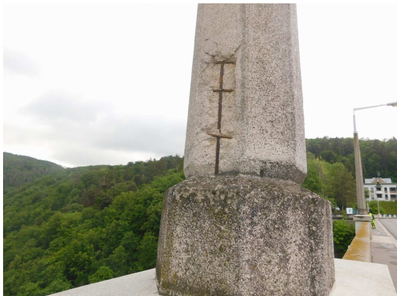
Obr. 2.123 – degradace betonu stožáru osvětlení
