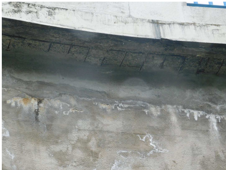
Obr. 2.111 – detail degradace betonu římsy na spodním lici, plošná separace krycí vrstvy, koroze betonářské výztuže
