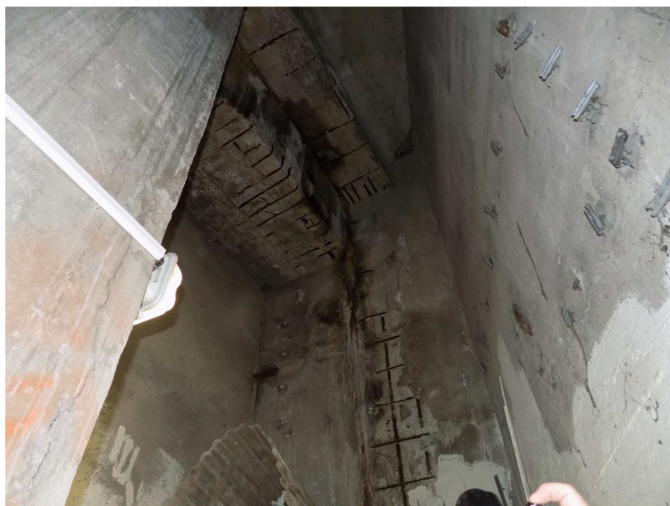
Obr. 2.27 – pole 2, stopy po průsacích s výluhy podélnou dilatační spárou mezi prvním a druhým příčným trámem na pravé straně v místě průchodu nosníku jeřábové dráhy
