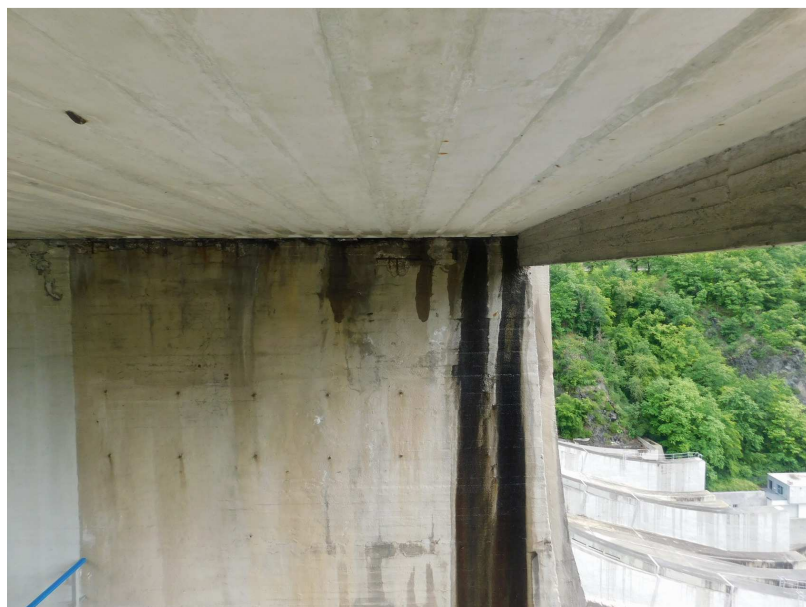
Obr. 2.41 – pole 11, silné průsaky úložným prahem pilíře P11, levá strana
