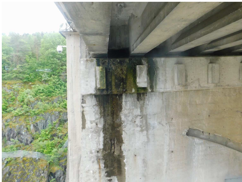
Obr. 2.70 – pole 10, silné zatékání na levé straně, pilíř P11
