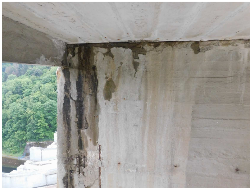
Obr. 2.38 – pole 3, silné zatékání u stěnového pilíře P6 na levé straně
