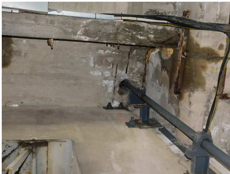
Obr. 2.102 – pole 10B, spodní líc stropu strojovny v pravé části, prokreslená korodující výztuž, silné průsaky a degradace v místě otvoru ve stropu strojovny
