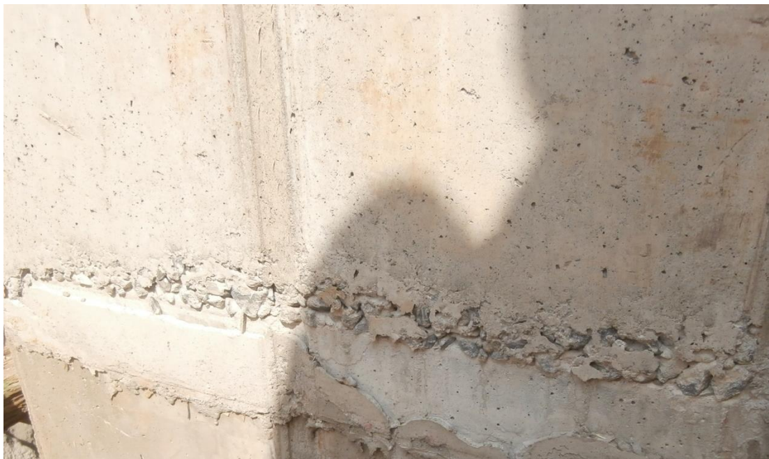
Obr. 10. Chybně provedená ŽB konstrukce - nedostatečné utěsnění bednění v úrovni PS, vyteklo cementové mléko, štěrkové hnízdo.
