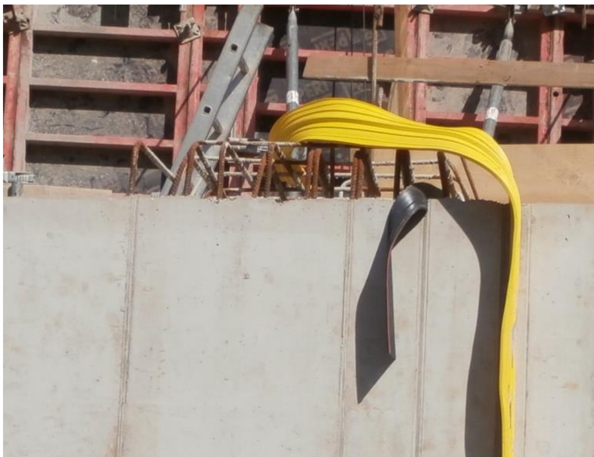
Obr. 6. Chybné uložení těsnicího pásu PS - nenavazuje na těsnicí pás DS.
