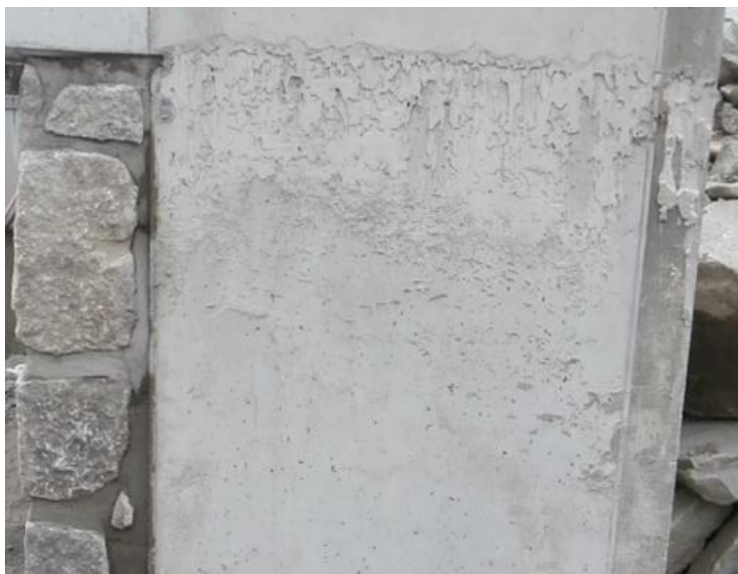
Obr. 13. Chybně provedené kamenné obkladní zdivo - nepřípustná tloušťka betonu mezi rubem kamene a ŽB konstrukcí.
