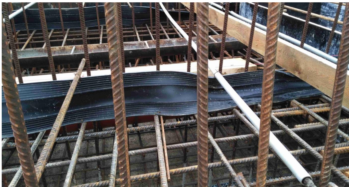
Obr. 5. Chybné uložení těsnicího pásu PS v místě křížení se spojovacím táhlem bednění. Zabetonovávaná část pásu má být vyrovnaná a volná část pásu (nad úrovní PS) dočasně ohnutá.
