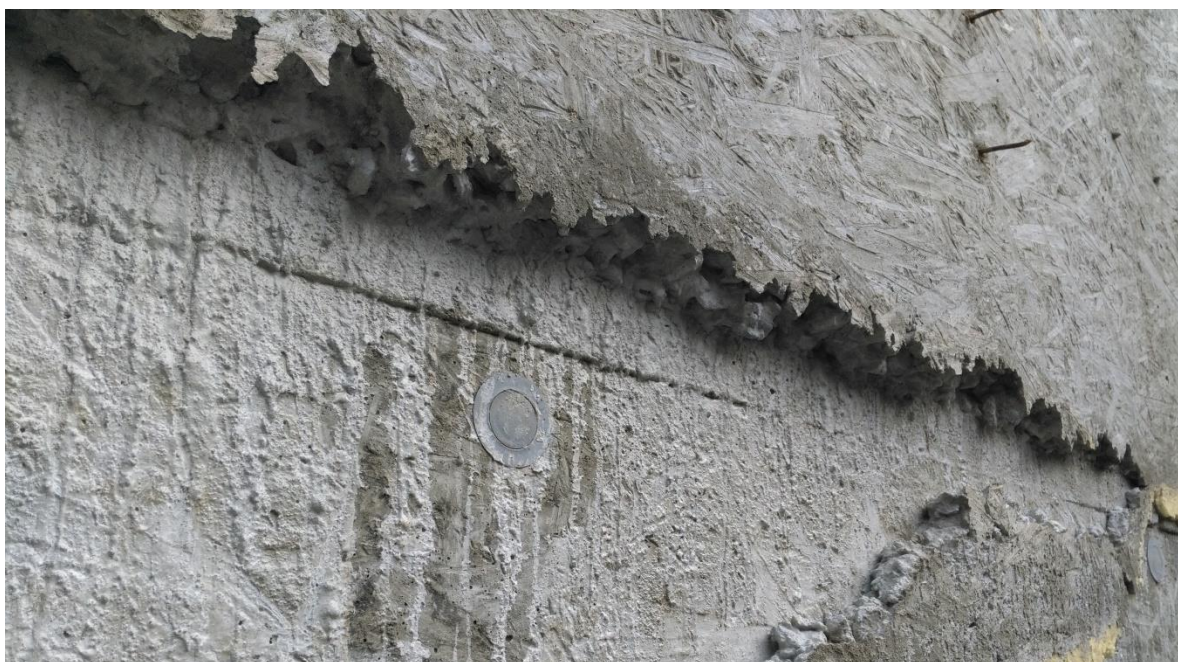
Obr. 12. Chybně provedená ŽB konstrukce - nedostatečná tuhost a hladkost bednění z OSB desky, úvaz bednění procházející lícem ŽB konstrukce, vyteklé cementové mléko, štěrkové hnízdo.
