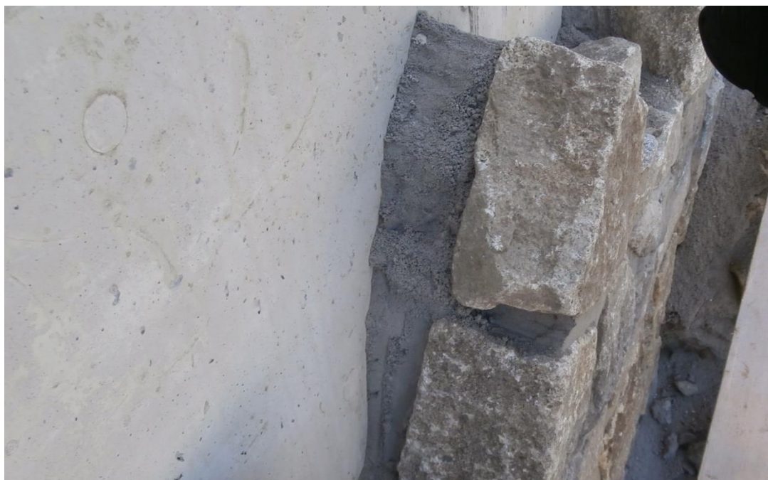
Obr. 13. Chybně provedené kamenné obkladní zdivo - nepřípustná tloušťka betonu mezi rubem kamene a ŽB konstrukcí.
