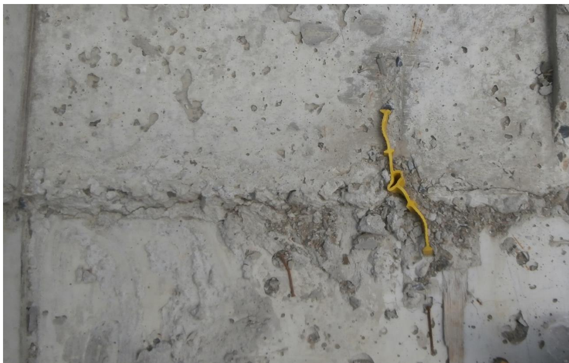
Obr. 7. Chybné provedení PS - povrch spáry není rovinný.
