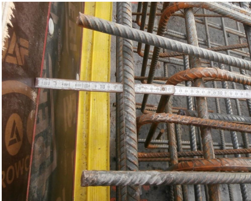
Obr. 1. Chybně uložená výztuž - není splněn požadavek krytí výztuže max. 50 mm.
