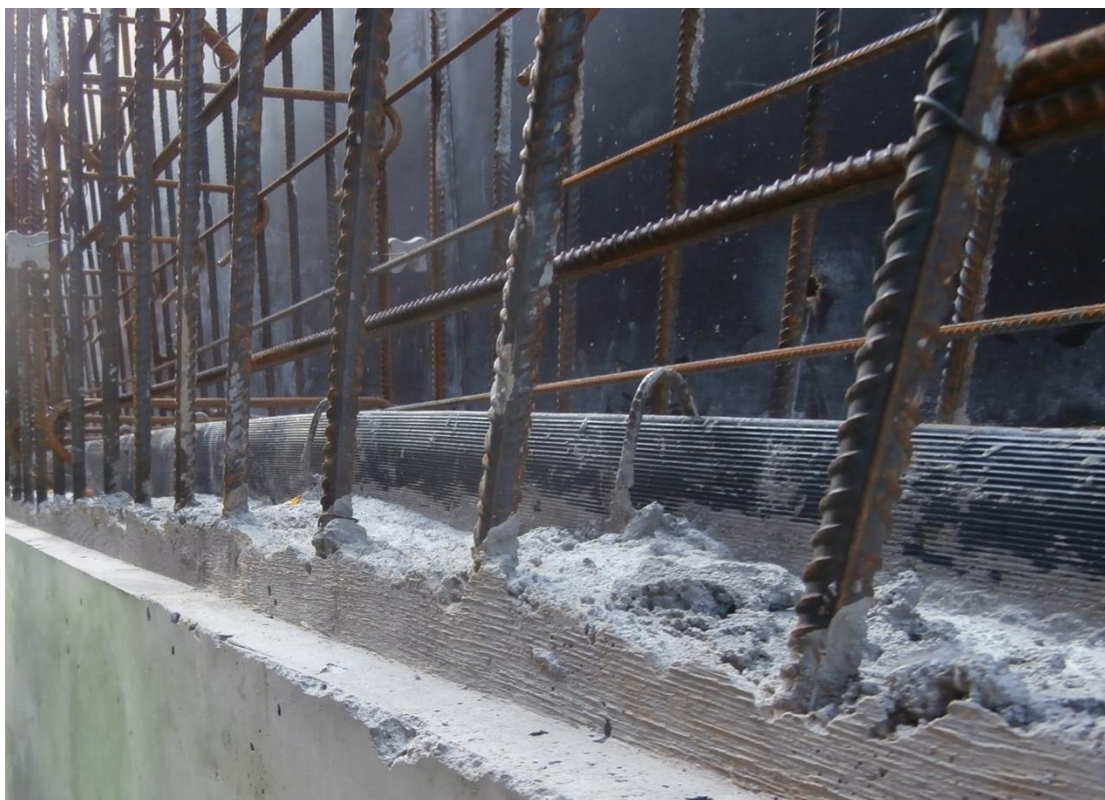
Obr. 7. Chybné provedení PS - povrch spáry není rovinný.
