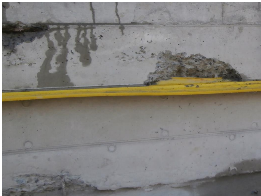
Obr. 1. Chybně uložená výztuž - není splněn požadavek krytí výztuže max. 50 mm.
