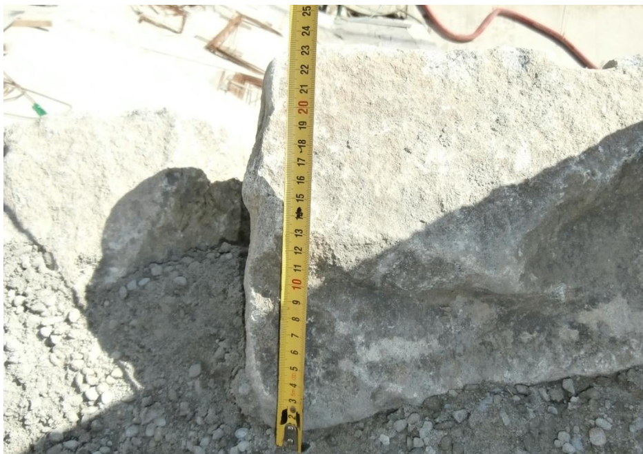
Obr. 9. Kamenná dlažba tl. 0,30 m - nevyhovující tl. kamene.
