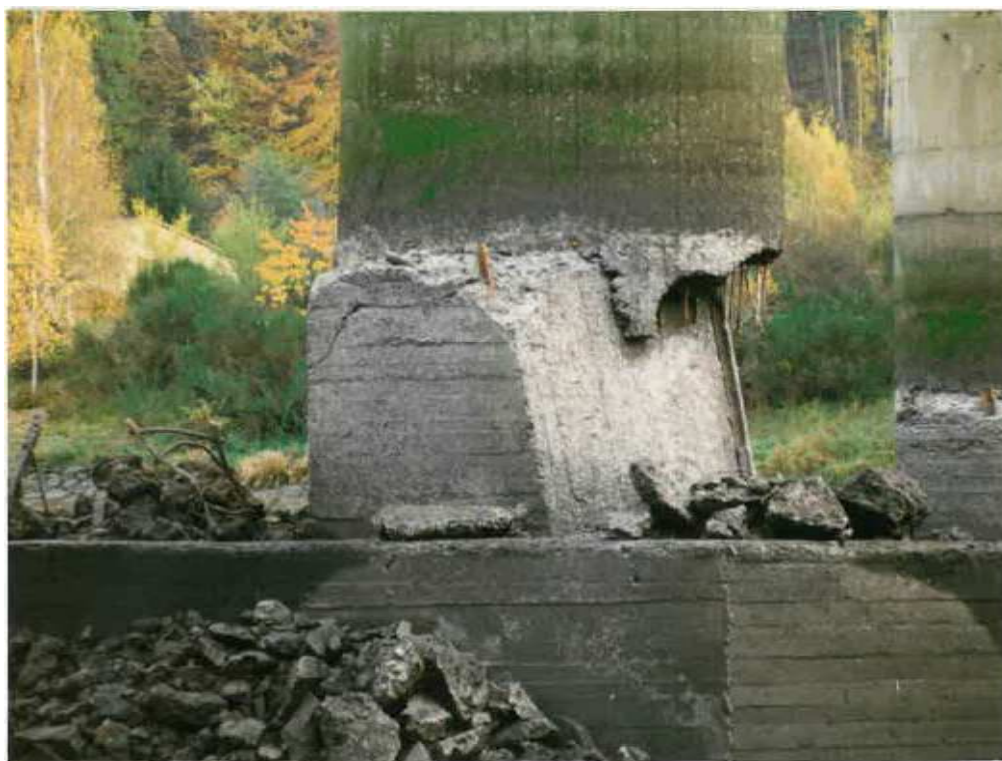
Hlavní prohlídka mostu 1996 - pohled na pilíře nabetonované na původní části ledolamu
