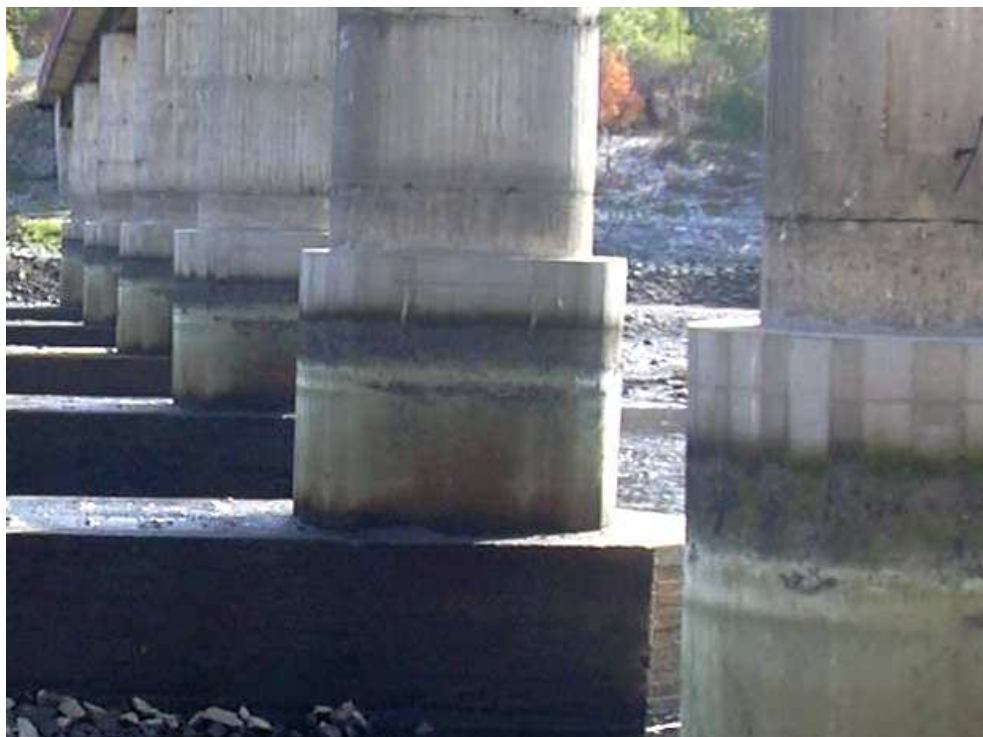
Zesilující obetonování pat pilířů z r. 2001
