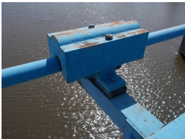
Podkladky ložisek transmise
