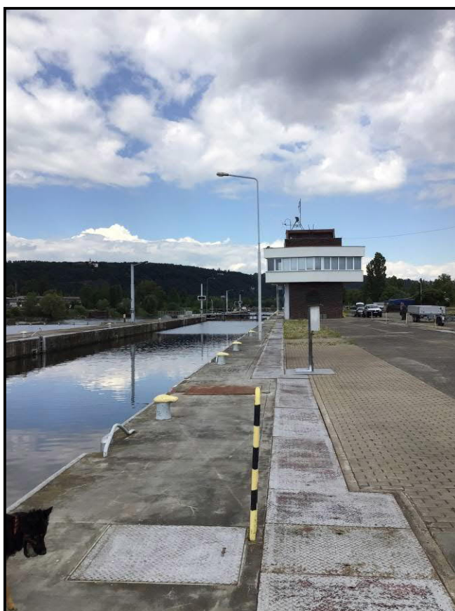
Vystrojení pravostranné zdi plavební komory s kabelovými rozvody.
