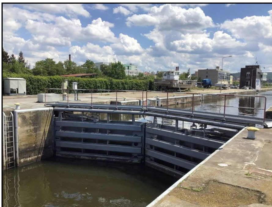
Dolní vzpěrná vrata plavební komory Modřany.
