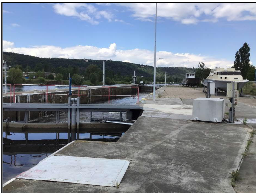
Střední ohlaví plavební komory se vzpěrnými vraty a hydraulickým agregátem.
