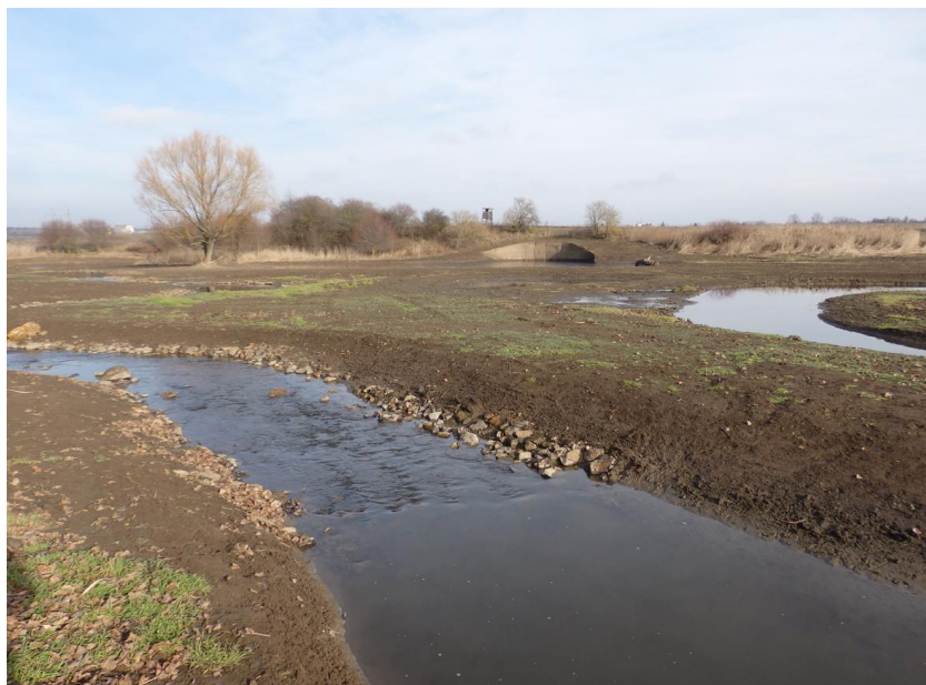
Obr. Zatlačený kámen do dna toku – přechodový úsek mezi oblouky
