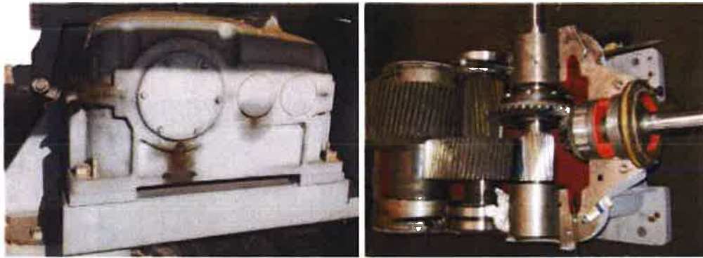
Pohled na převodovku (průsaky těsněním) a její vnitřní ustrojení
