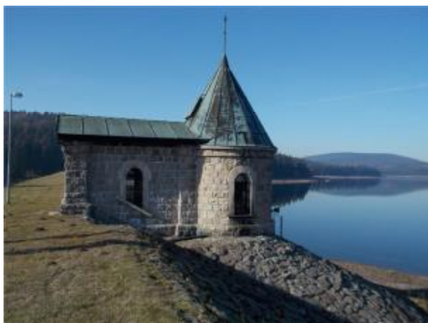
Manipulační šachta, přístup k šoupatům DN1000
