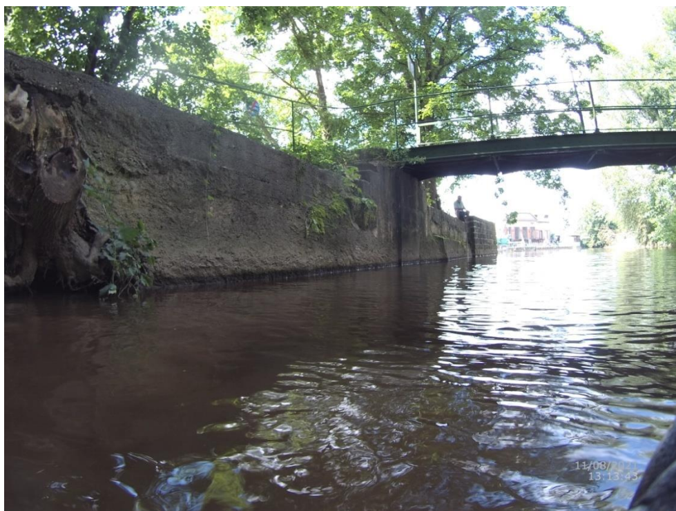
Foto: VD Ptýrov – levobřežní pilíř jezu s navazující betonovou zdí
