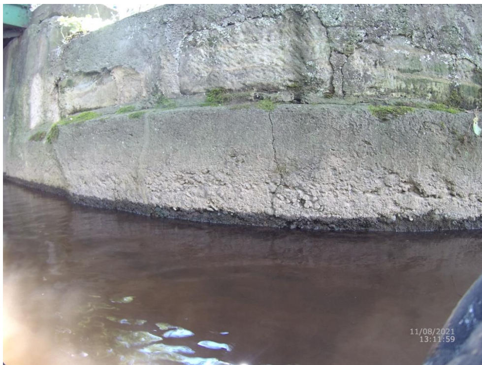
Foto: VD Ptýrov – svislá prasklina
