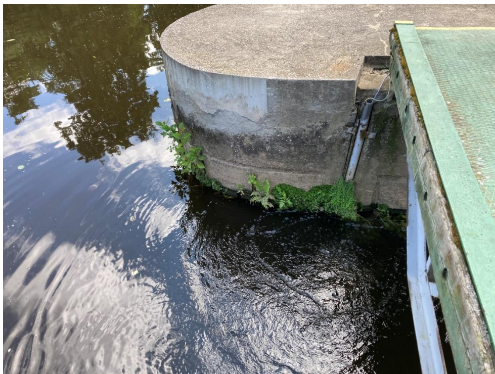
Foto: VD Ptýrov – vegetace ve vodorovné spáře
