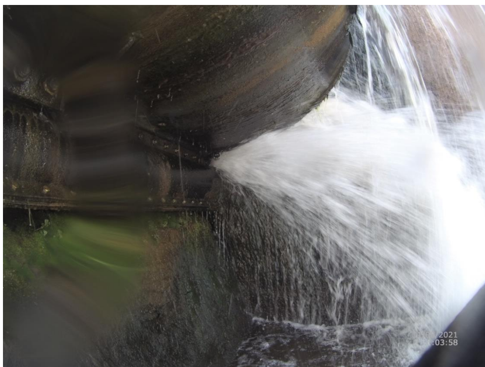
Foto: VD Ptýrov – poškozená těsnící guma
