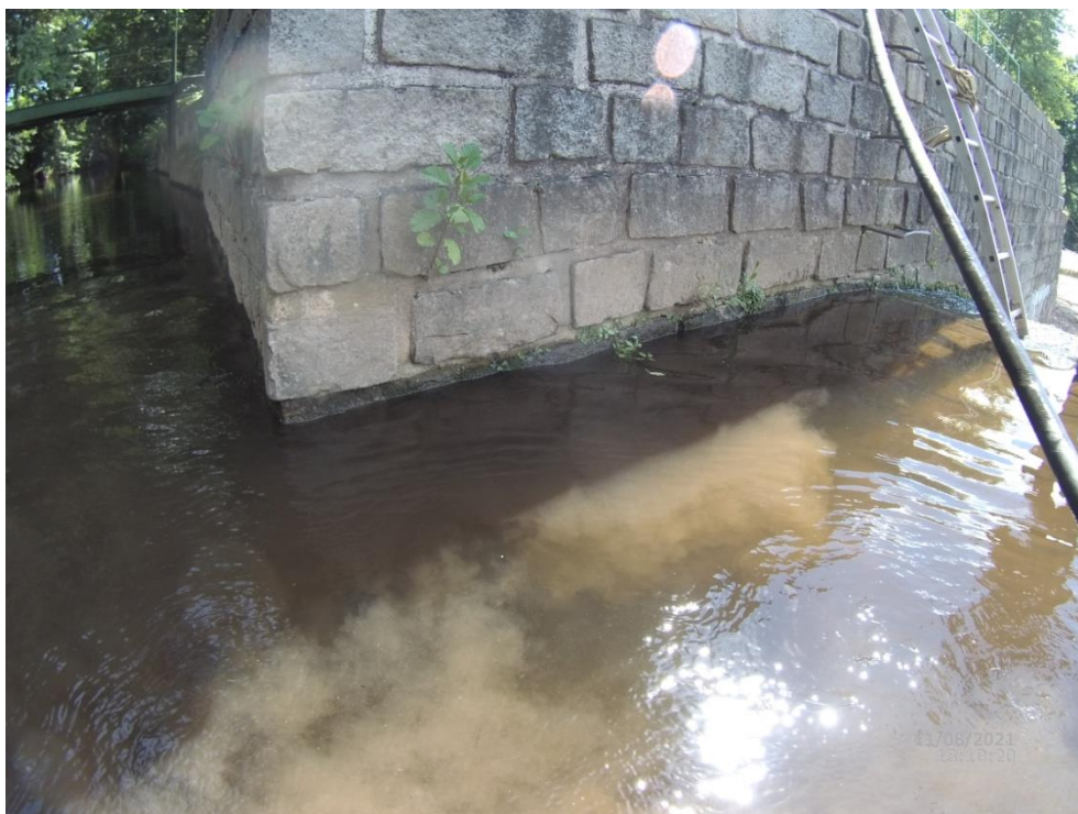
Foto: VD Ptýrov – vegetace ve spárování
