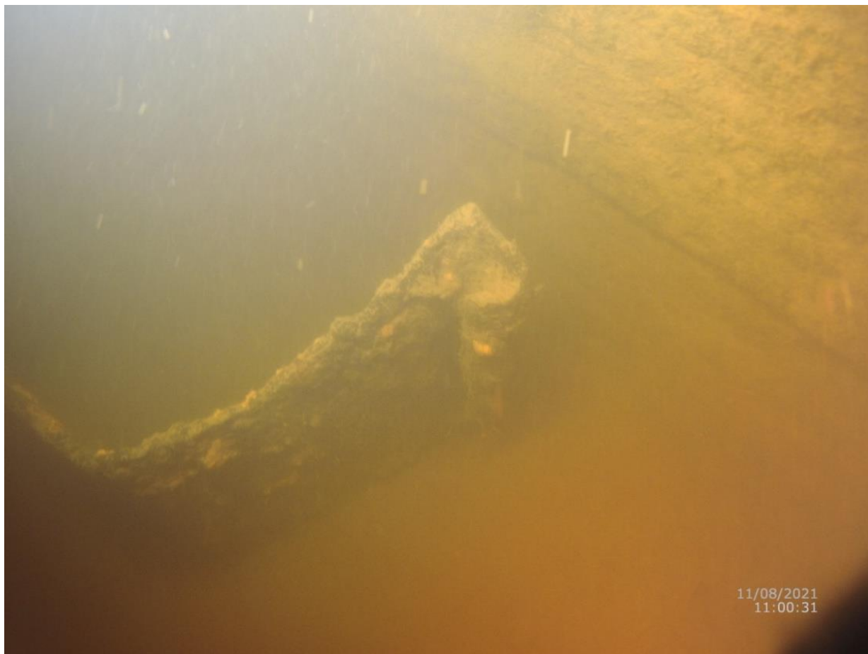
Foto: VD Ptýrov – vyčnívající štětovnice
