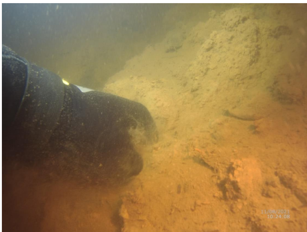
Foto: VD Ptýrov – náletek betonu před pilířem
