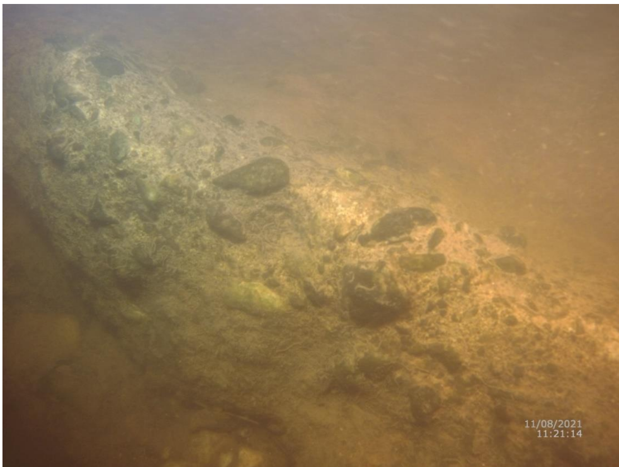
Foto: VD Ptýrov – kaverna v šikmině pod klapkou
