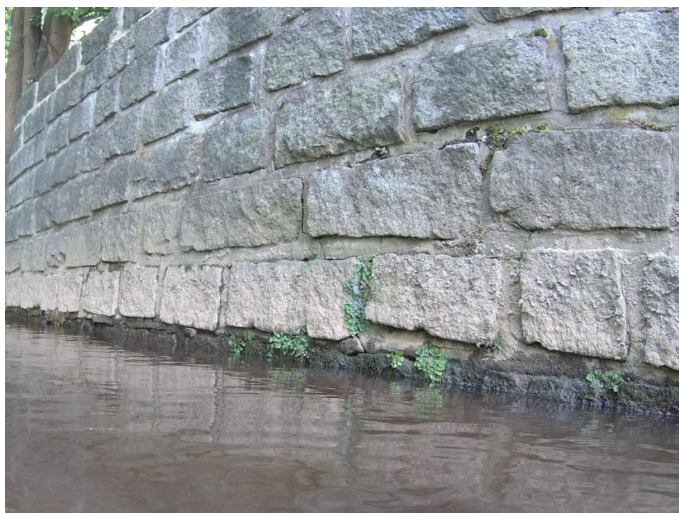
Foto: VD Ptýrov – praskliny ve zdivu
