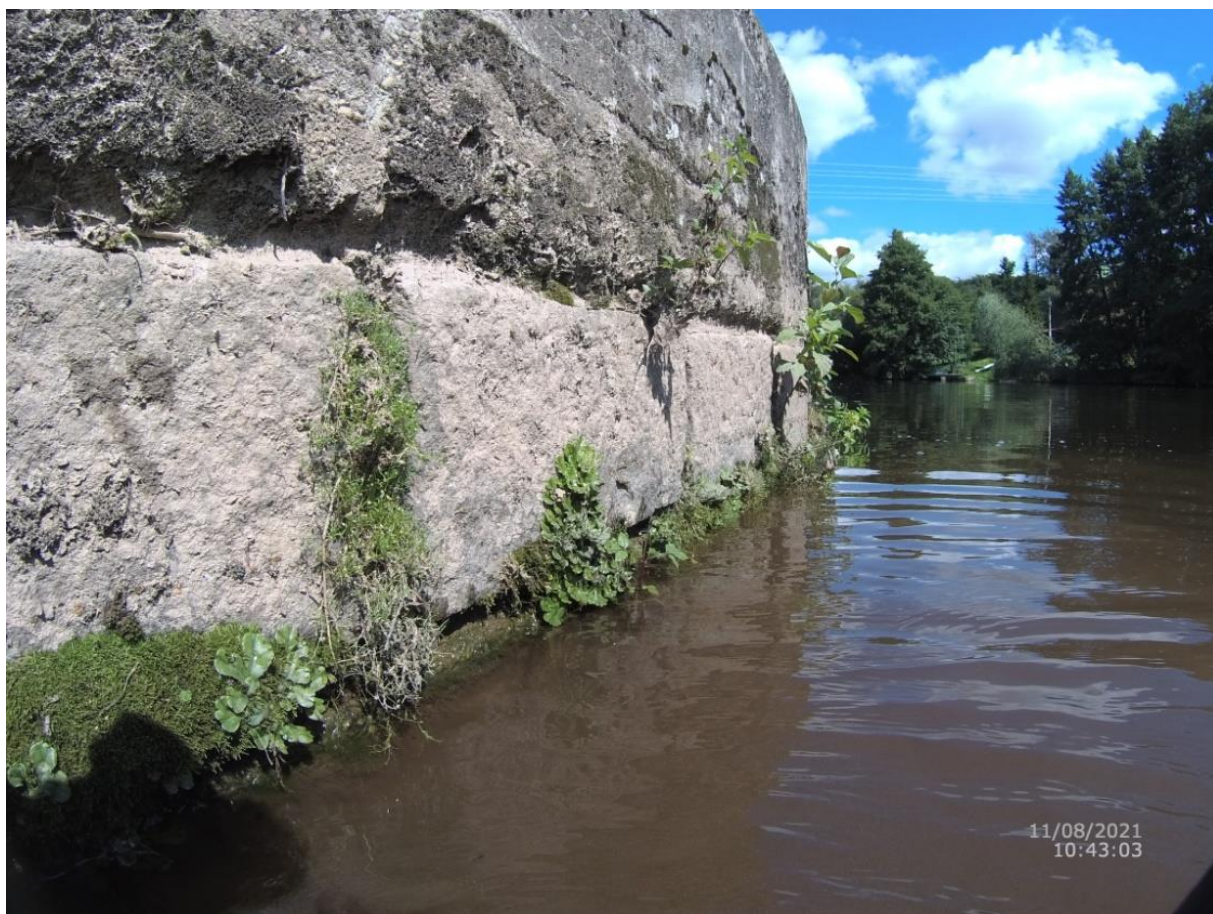
Foto: VD Ptýrov – vegetace ve vodorovné spáře
