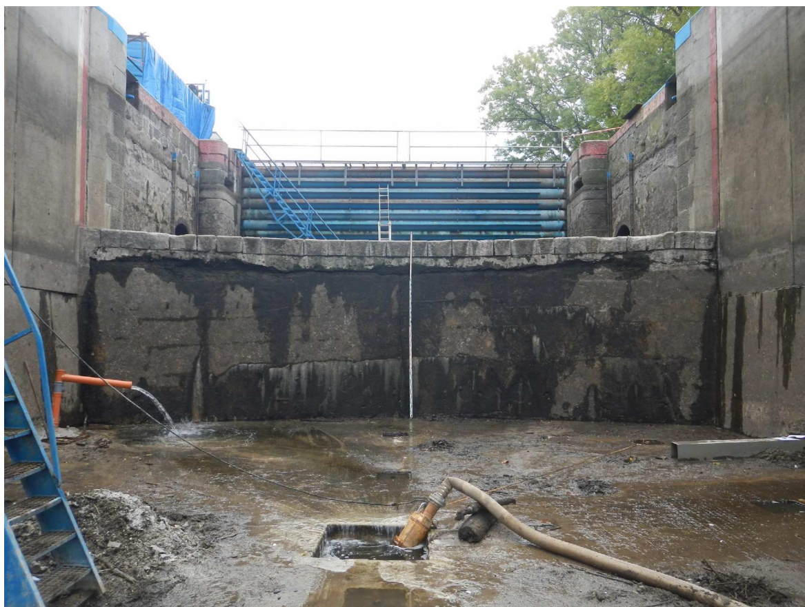
Spadiště horního ohlaví PK Brandýs nad Labem
