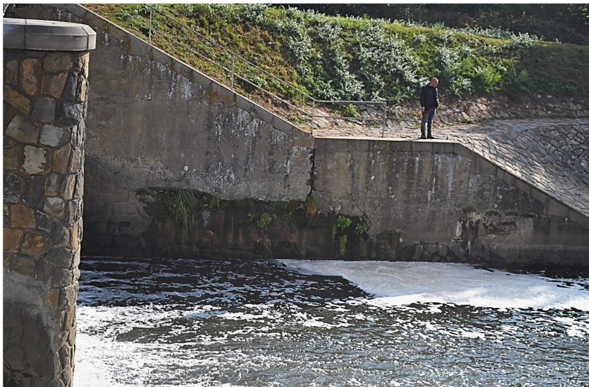
Obr.: Pohled na levou nábrežní zeď v podjezí vývaru a rozsah poškození výrony vody.
