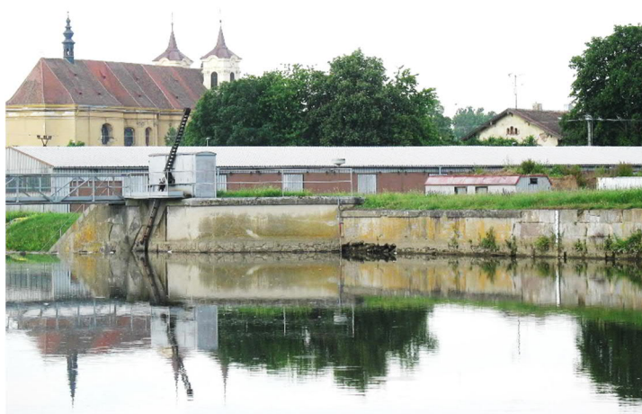
Obr.: Umístění stávajícího hladinového čidla (dnes již nepoužívané) v pravé zdi jezu Rajhrad v nadjezí
