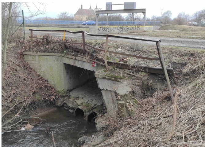
Obr.: Vyústění a ŽB mostek přes Ivanovický potok na levém břehu pod jezem Rajhrad
