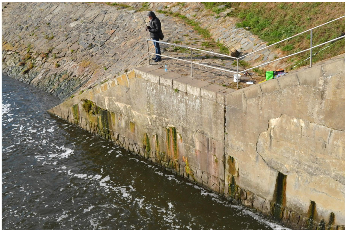
Obr.: Pohled na pravou nábrežní zeď v podjezí vývaru a rozsah poškození výrony vody.
