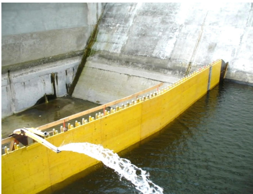
Obr.: Příklad použití systémového bednění a rozpět z rámů pro nasazenou jímku ve vývaru jezu.
