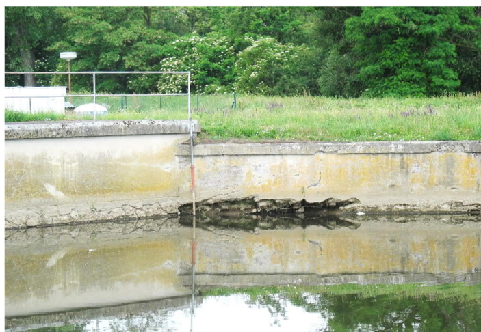
Obr.: Umístění stávajícího hladinového čidla (dnes již nepoužívané) v pravé zdi jezu Rajhrad v nadjezí
