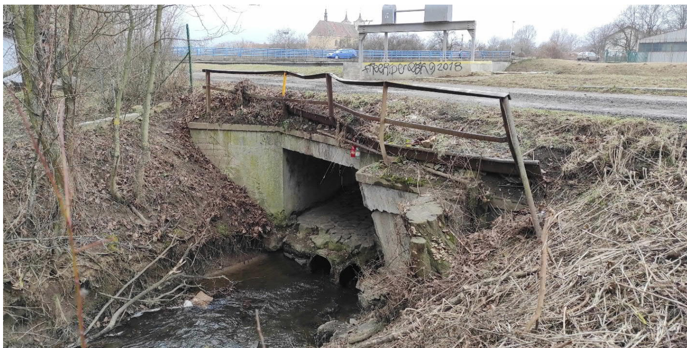
Obr.: Stav ŽB mostku přes Ivanovický potok na levém břehu pod jezem Rajhrad
