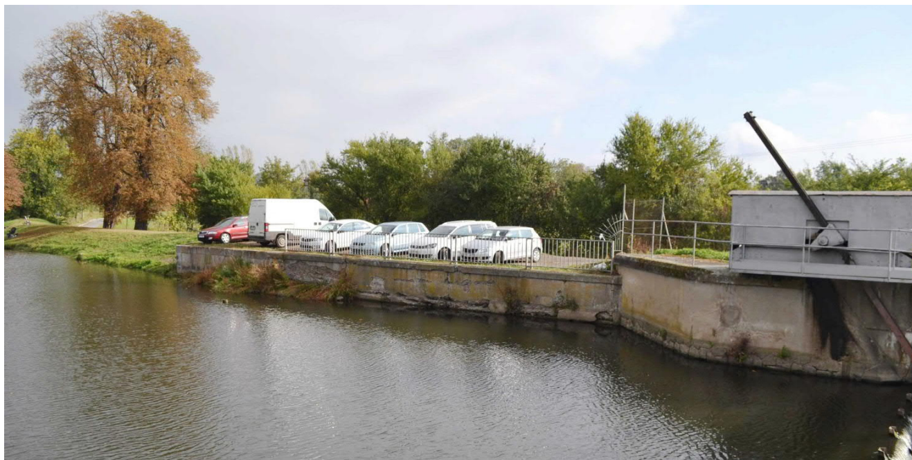
Obr.: Prostor levého břehu v nadjezí – kompletní nahrazení snížené LB opěrné zdi v rámci rekonstrukce jezu.
