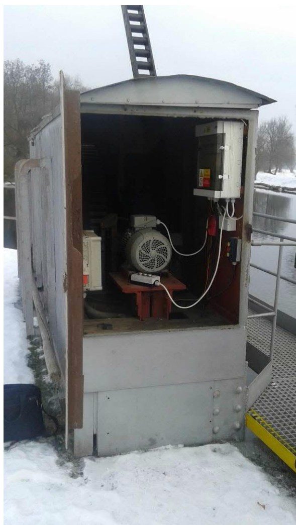
Obr.: Stávající pohon jezové klapky
