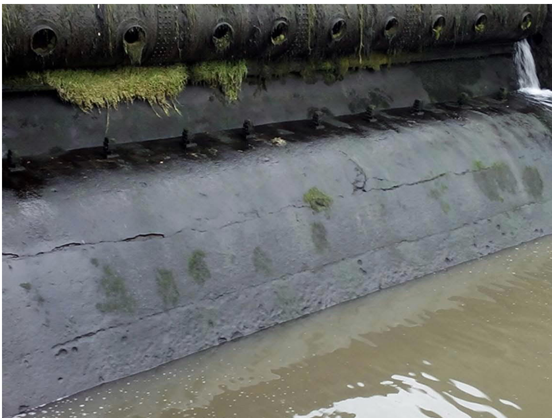
Obr.: Stav betonů tělesa přelivu a těsnění klapek jezu Rajhrad v listopadu 2016
