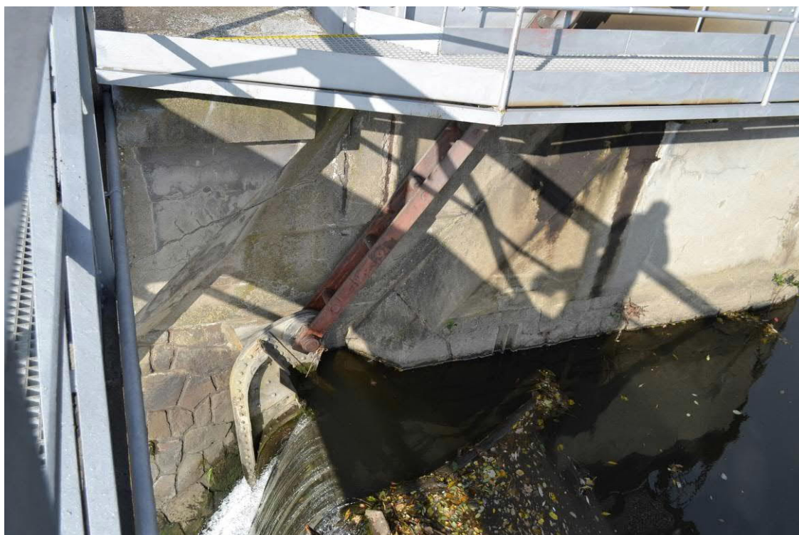
Obr.: Boční drážky ve výklencích pilíře pro vedení cévové tyče
