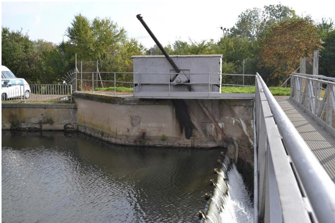
Obr.: Stávající plechová budka pro pohon jezové klapky
